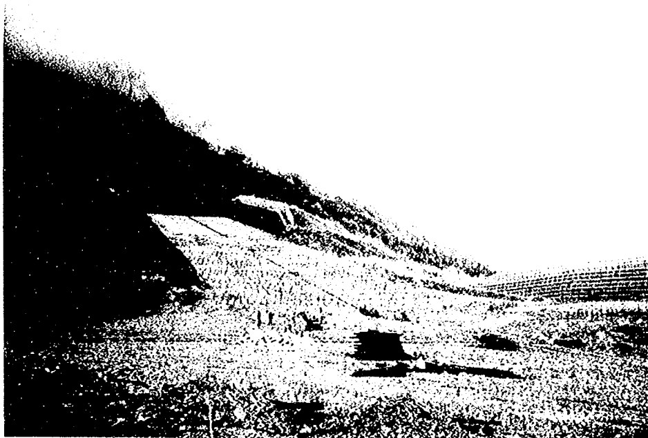
写真-付.1 新潟県西頸城郡能生町柵口地区に設置された誘導工 奥が1号誘導工、手前が2号誘導工
