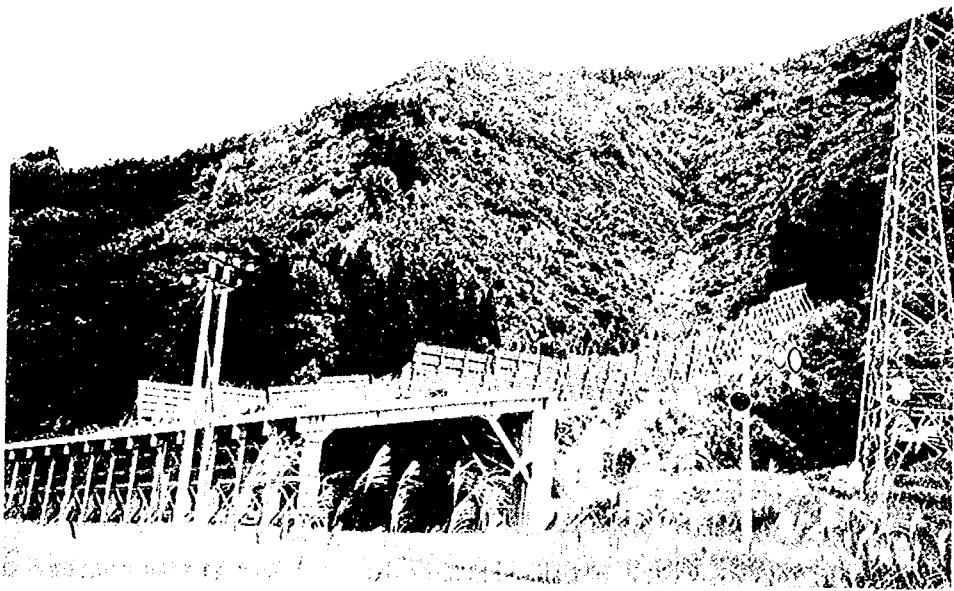
写真-付. 5 新潟県南魚沼郡湯沢町堀切地区に設置された誘導柵
