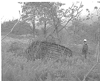
写真－４ 集水井の傾動
