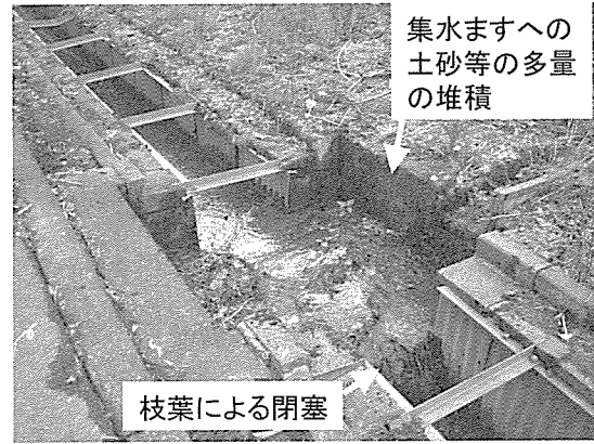
写真-1.10 集水ますの堆砂事例
