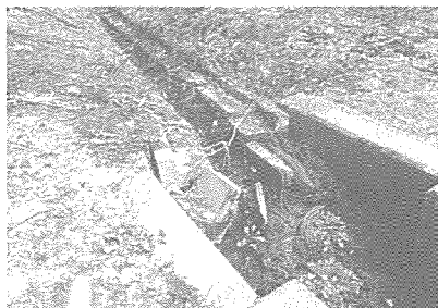
写真－10 目地の開きによる漏水で周辺が浸食 写真－11 接続部の破損と集水ますの土砂の堆積 写真－12 落差壁の傾動
