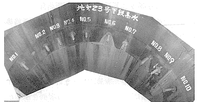
写真-4.7 集水井壁面への集水管孔番号記入例
