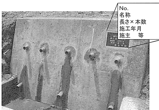
写真-4.6 施設へのプレート設置例
