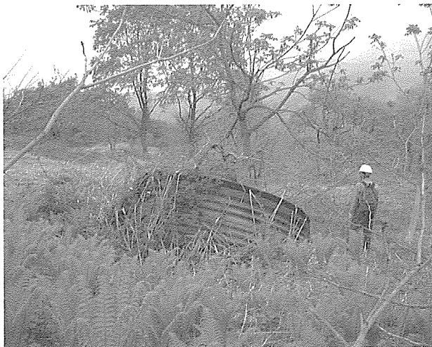
写真－1.3 傾いた集水井事例
