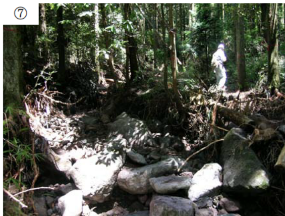
⑦ 岳本川左支川の侵食状況
