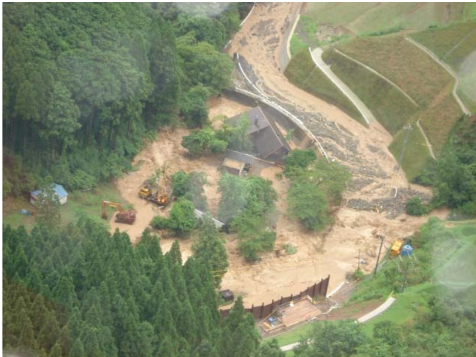
図 4.2.1 美里町早楠地区の氾濫状況：津留川 2)
