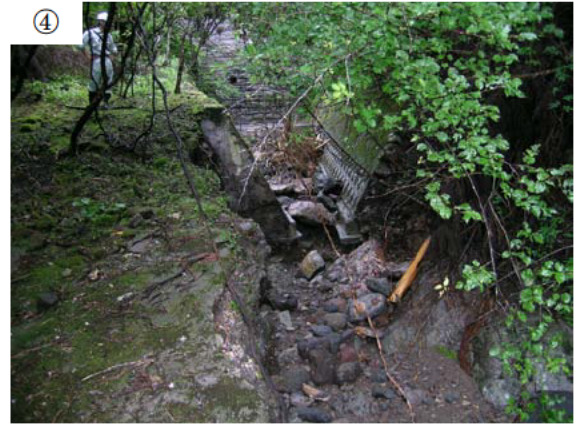
④ 岳本川砂防堰堤下流
