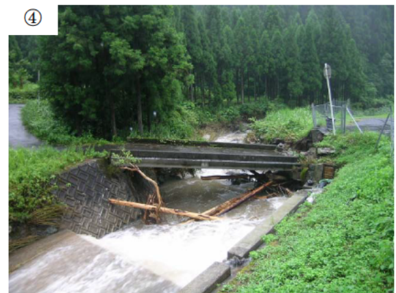
図 4.6.2 屋堂羅川の被害状況（閉塞・堆積の発生した橋梁部） 2)
