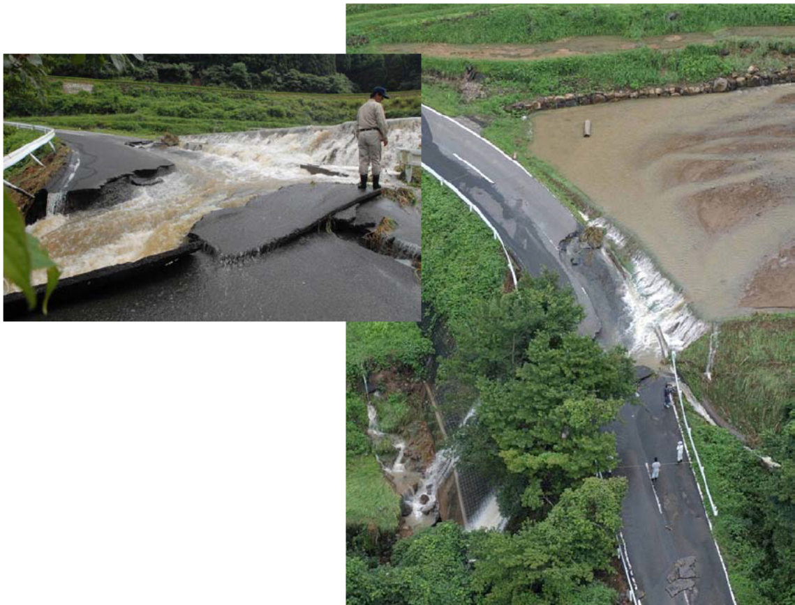
図 3.3.1 鉄砲水で崩壊した国見山麓広域農道（災害発生地点） 2)
