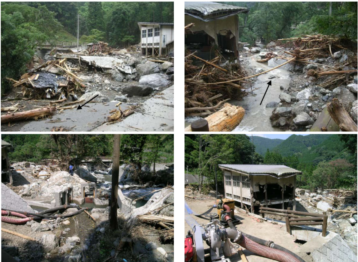
図 4.2.9 柏川（開田地区）の状況 2)
