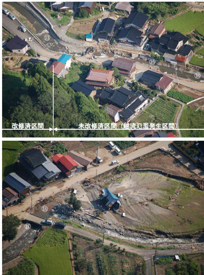
図 4.6.4 角谷川の被害状況 2)
