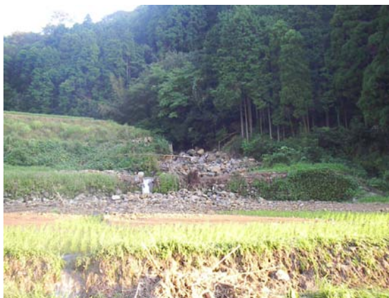
図 3.3.4 谷出口の河道閉塞決壊痕跡
