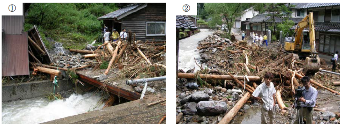
図 4.6.1 屋堂羅川の被害状況（閉塞・堆積の発生した橋梁部） 1)
