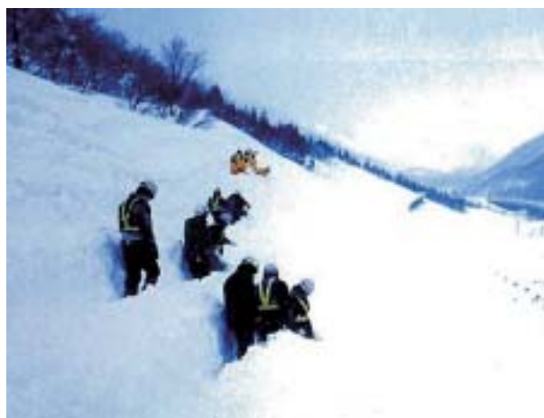
図 5-5 踏み固め・階段工の方法
