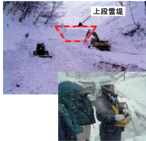
写真 5-44 無人重機での雪堤設置作業
