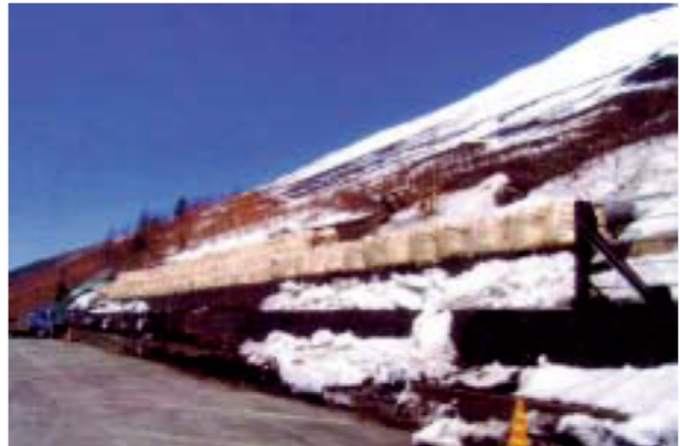
写真 5-32 斜面下端に大型土のう設置(静岡県富士山スカイライン)
