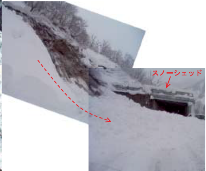
写真 3-10 雪崩の発生状況
