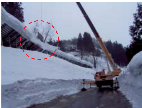
写真 5-13 クレーンおよび鉄板での法面雪庇処理(福井県大野市:国道 158 号)
