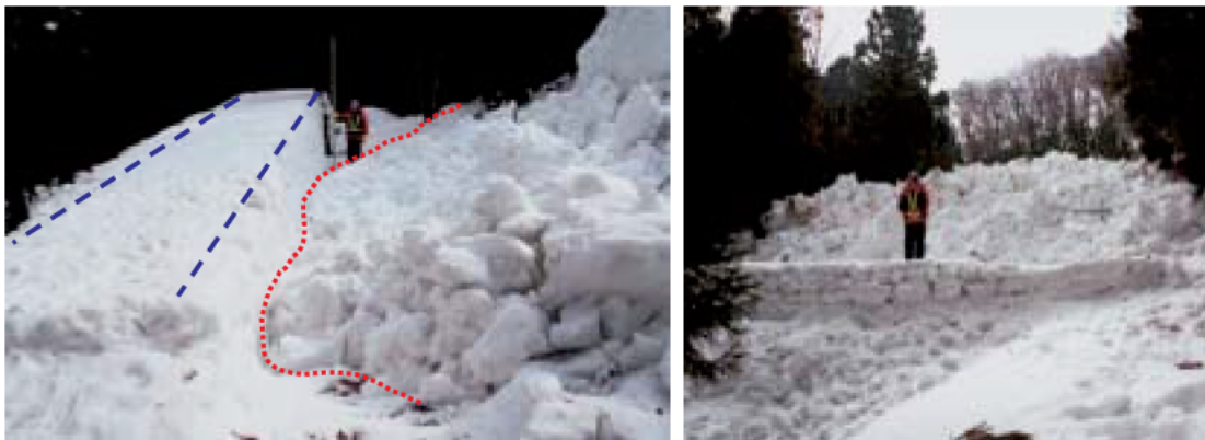
写真 5-28 雪堤が雪崩を捕捉した状況(新潟県湯沢町:国道 17 号) 5)
