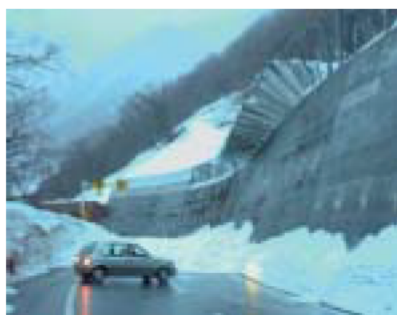
写真 5-46 雪崩発生斜面と被災状況
