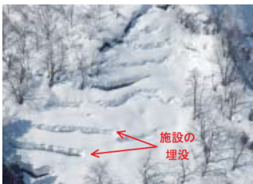
写真 3-25 雪崩予防柵の埋没
