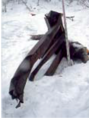
写真 3-27 雪崩予防柵の破損
