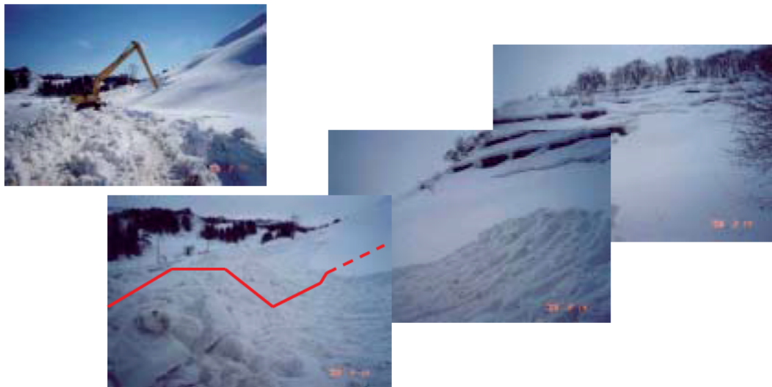
写真 5-29 斜面雪庇処理および堆雪ポケット確保(新潟県長岡市:国道 290 号) 2)
