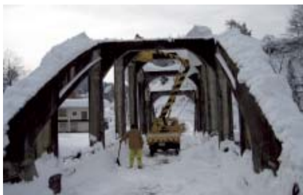
写真 5-5 高所作業車による橋梁のトラス上部の雪庇処理 (長野県栄村:一)長瀬横倉停車場線)
