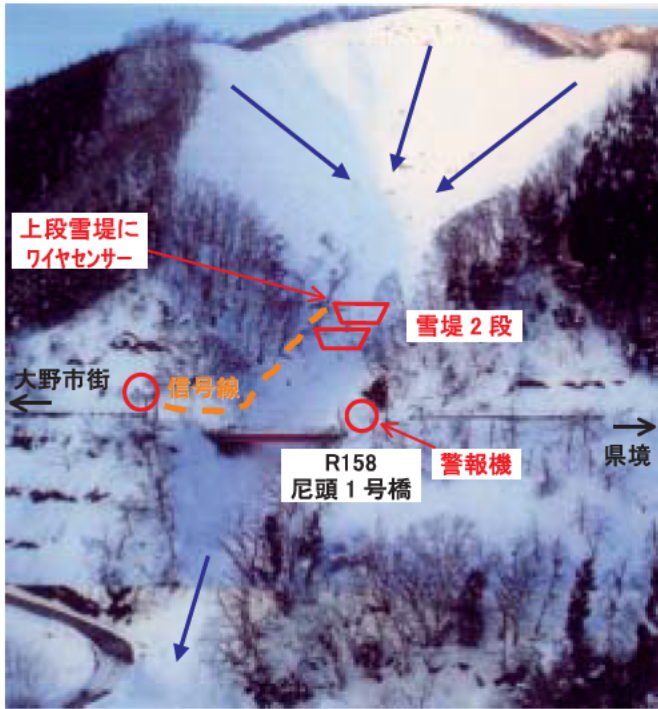
写真 5-43 雪堤および雪崩発生感知・通報システムの設置状況
