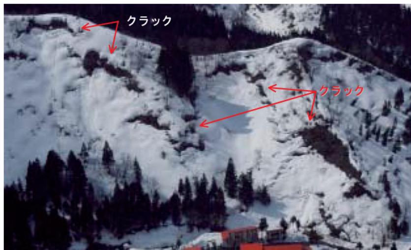
写真 3-15 斜面のクラック(雪割れ)
