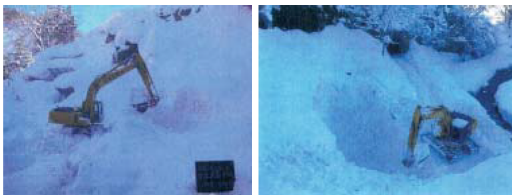
写真 5-29 斜面雪庇処理および堆雪ポケット確保(新潟県長岡市:国道 290 号) 2)
