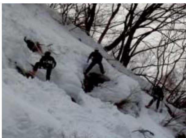
写真 5-1 尾根部の雪庇処理(新潟県妙高市:主)飯山斑尾新井線)
