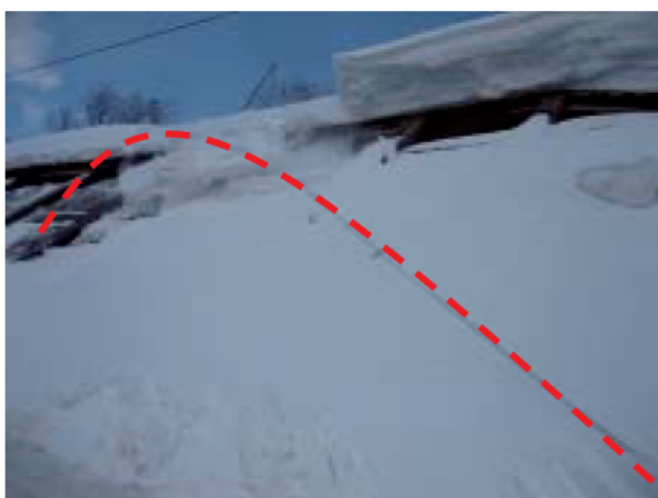
写真 5-7 ワイヤロープによる法肩部の雪庇処理(長野県飯山市：主)飯山斑尾新井線)
