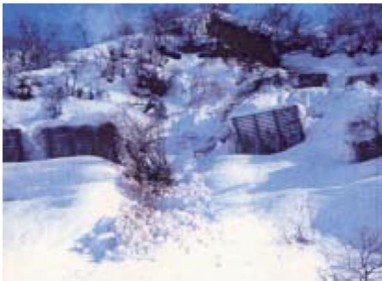
写真 3-29 雪崩予防柵の間を流下した雪崩 1)
