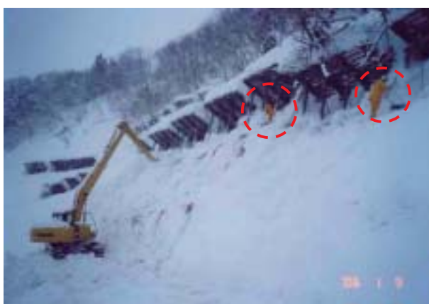
写真 5-18 バックホウと人力による雪崩対策施設付近の雪庇処理
