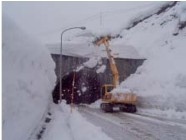
写真 5-12 バックホウでのトンネル坑口部の雪庇処理(新潟県十日町市:国道 253 号) 1)
