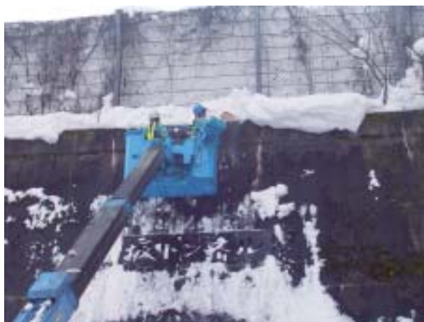
(道路利用者の安全確保のため、通行規制等を行う。 下に人や車両等がないことを確認しながら行う。)
