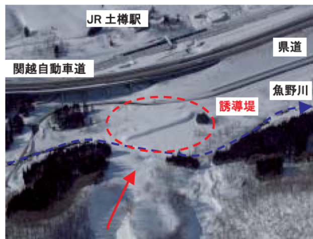
写真 5-40 誘導堤(導流堤)設置状況 5)
