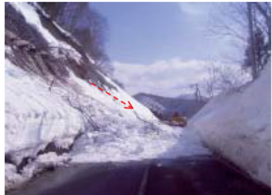
写真 3-12 法面からの崩落雪
