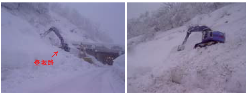
(斜面積雪上に重機用の登坂路を施工し、対象箇所へ進入して処理する。)
