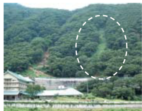
写真 5-51 平成 19 年 8 月の斜面状況
