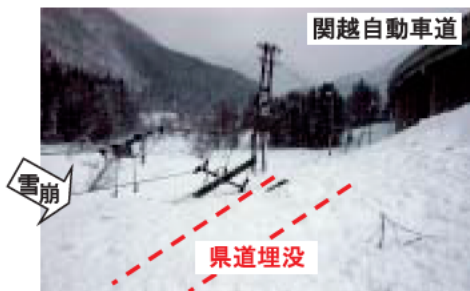
写真 5-38 県道埋没と電柱倒壊 5)
