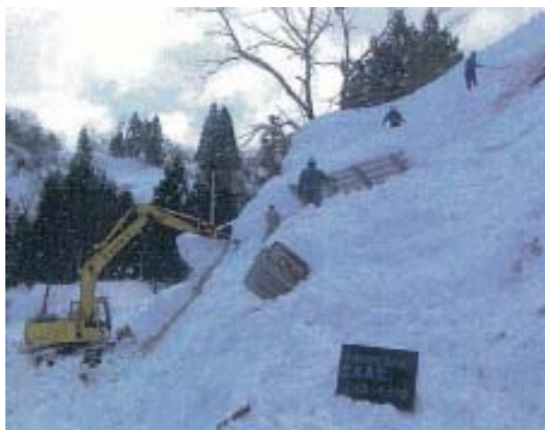
写真 5-18 バックホウと人力による雪崩対策施設付近の雪庇処理
