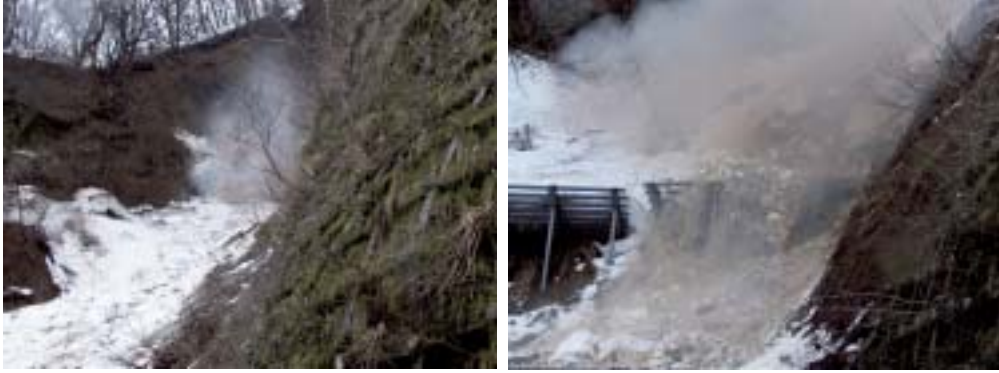
写真 5-22 蒸気圧破碎薬剤による雪庇処理(新潟県柏崎町:一)門出石黒線) 6)
