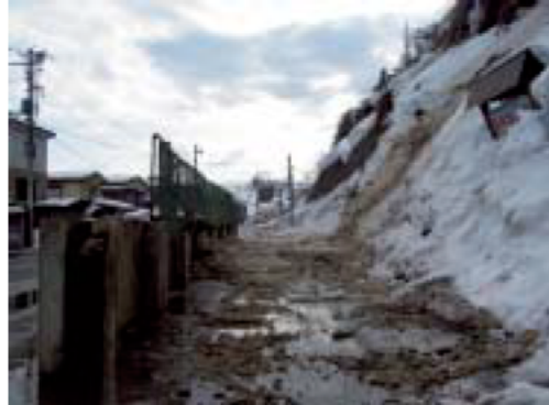
堆雪ポケットの状況
