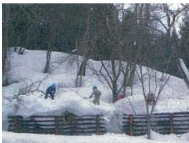
写真 5-2 斜面積雪の除去(福井県大野市:国道 158 号)
