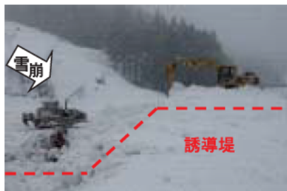
写真 5-39 誘導堤設置作業 5)
