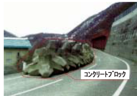
写真 5-50 コンクリートブロックの設置状況
