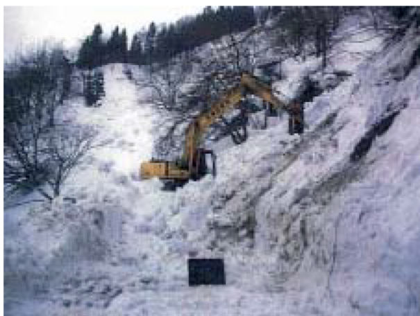
(バックホウで斜面積雪を掻き落とし除去する。)
