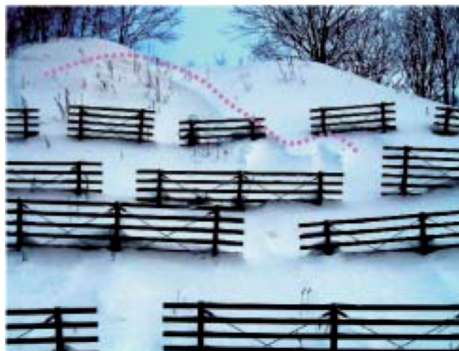
写真 4-6 雪崩予防柵を斜面積雪がすり抜けた現象の例 図中の破線は、積雪破断面の位置を示す。
