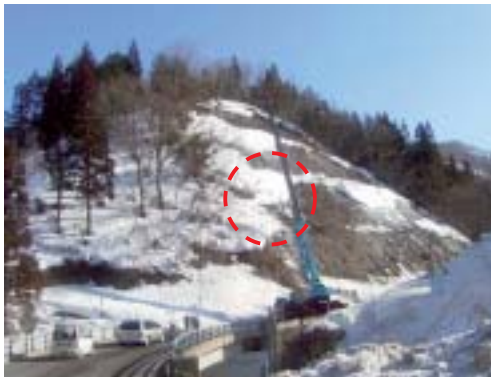
写真 5-13 クレーンおよび鉄板での法面雪庇処理(福井県大野市:国道 158 号)
