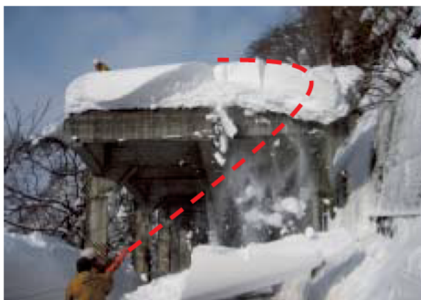
写真 5-6 ワイヤロープによるスノーシェッド坑口部の雪庇処理
