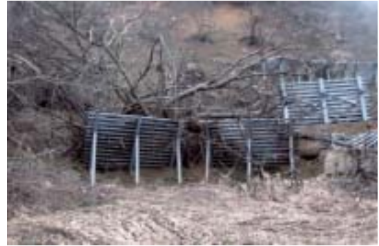
写真 3-7 柵上の土砂や樹木の堆積
