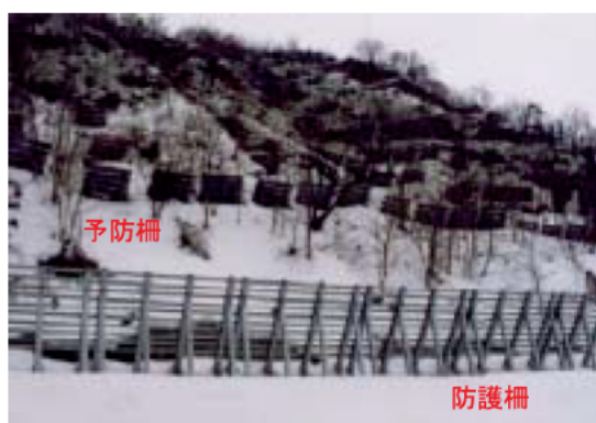
写真 3-4 予防柵(上部)と防護柵(下部)の設置状況 5)
