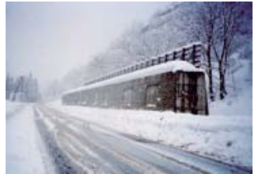
写真 3-8 防護擁壁の設置状況 5)
