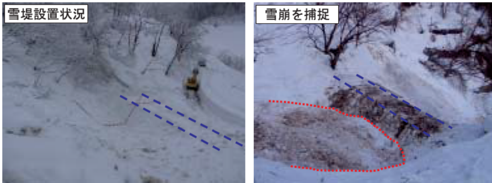
写真 5-27 雪堤が雪崩を捕捉した状況(新潟県妙高市:主)飯山斑尾新井線)
