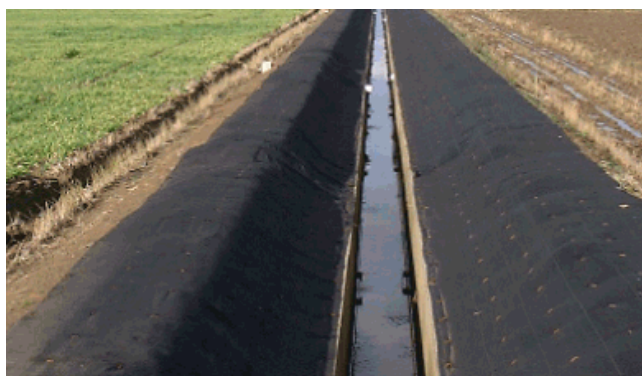
写真-29 防草シート
