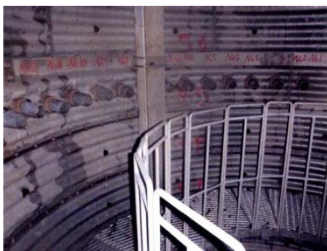
写真-22 集水井内に中間足場を設置した事例（由比地すべり 静岡県）
