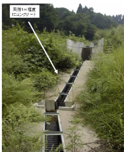
写真-21 水路両側にコンクリートを敷いた事例（新潟県）
