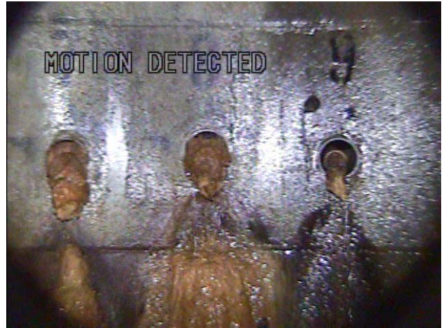
写真-25 集水管孔口の状況
