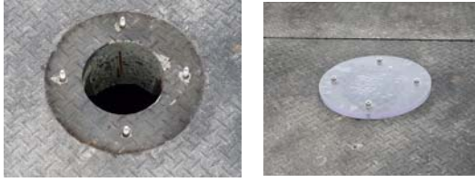
写真-24 カメラ挿入用点検穴
