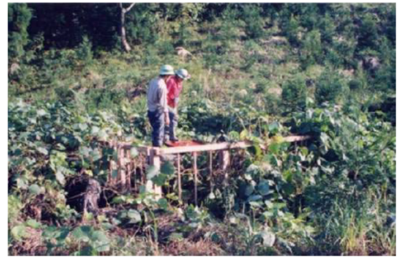
写真-20 10月に撮影した集水井の状況
