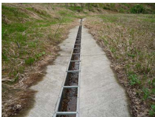
写真-28 水路両側面のコンクリート張り
