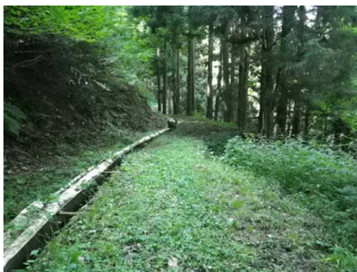
写真-32 廃棄されたガードレールを利用した水路の蓋
