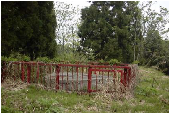
写真-19 5月に撮影した集水井の状況
