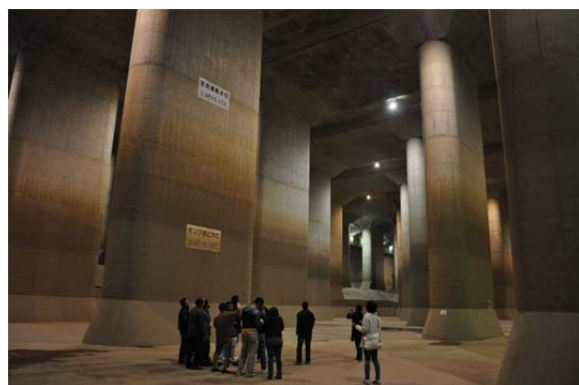
首都圏外郭放水路 調圧水槽
