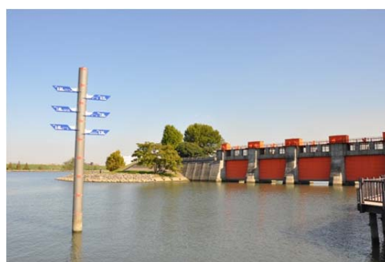
旧岩淵水門と実績洪水浸水深表示板
