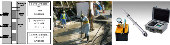
図 孔内における試験実施位置 写真 孔内載荷試験実施状況 写真 孔内打撃応答試験実施状況
