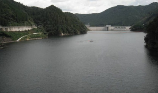
ダム本体の状況(平成23年10月3日)(上流面)
