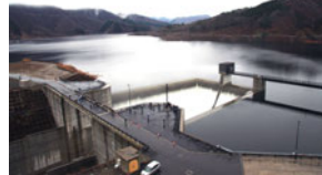
最高水位を迎え非常用洪水吐きからの 越流状況
