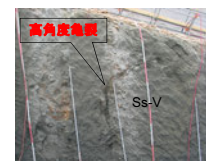
左岸アバット部監査廊下流壁
