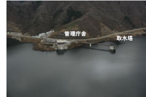
最高水位時の管理庁舎と取水塔
