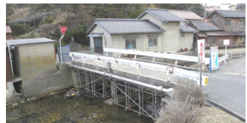
写真-1 撤去前の状況
