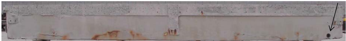
写真-4 No.2試験体(無補強桁)B面
