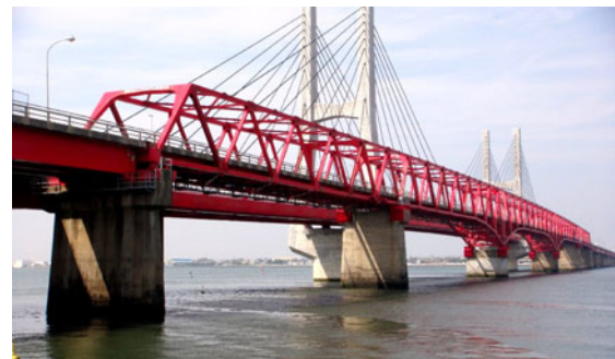
図-1 撤去前の対象橋梁（手前）と新橋（奥）
