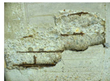
写真-2 撤去前の床版下面状況
