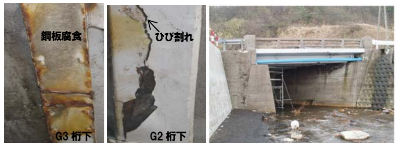
写真-2 撤去前の状況
