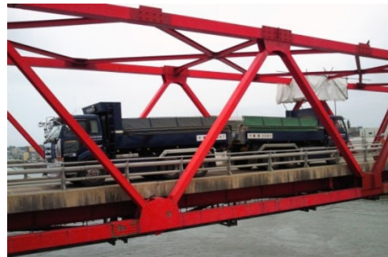
図-4 荷重車载荷の状況
