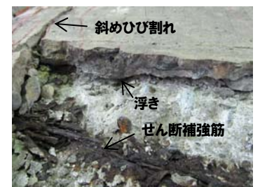
写真-8 解体途中・浮き確認
