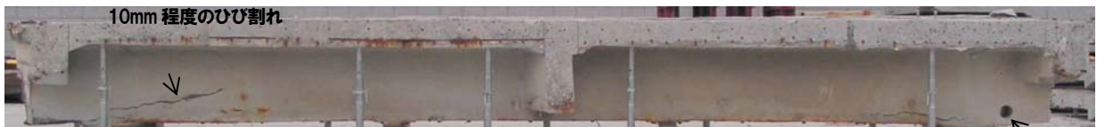
写真-3 No.1試験体(鋼板補強桁)B面
