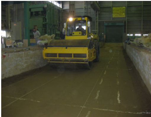
写真1 締固め回数試験状況
