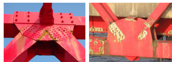
a) 上弦材格点部 b) 下弦材格点部
