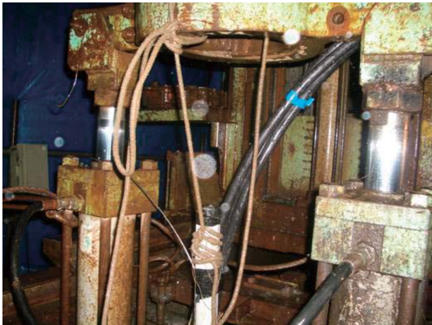
写真3-34 油圧ジャッキとロープでガイド管の孔口部を吊るした事例
