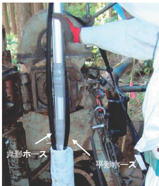
写真3-18 平形ホースと丸形ホースの挿入 深度50mより以深は丸形ホースを配置。50mより上位は平形ホースを配置
