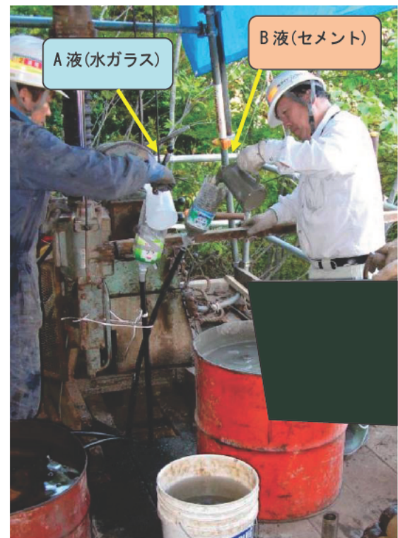
写真3-33 水ガラス・セメント注入状況
