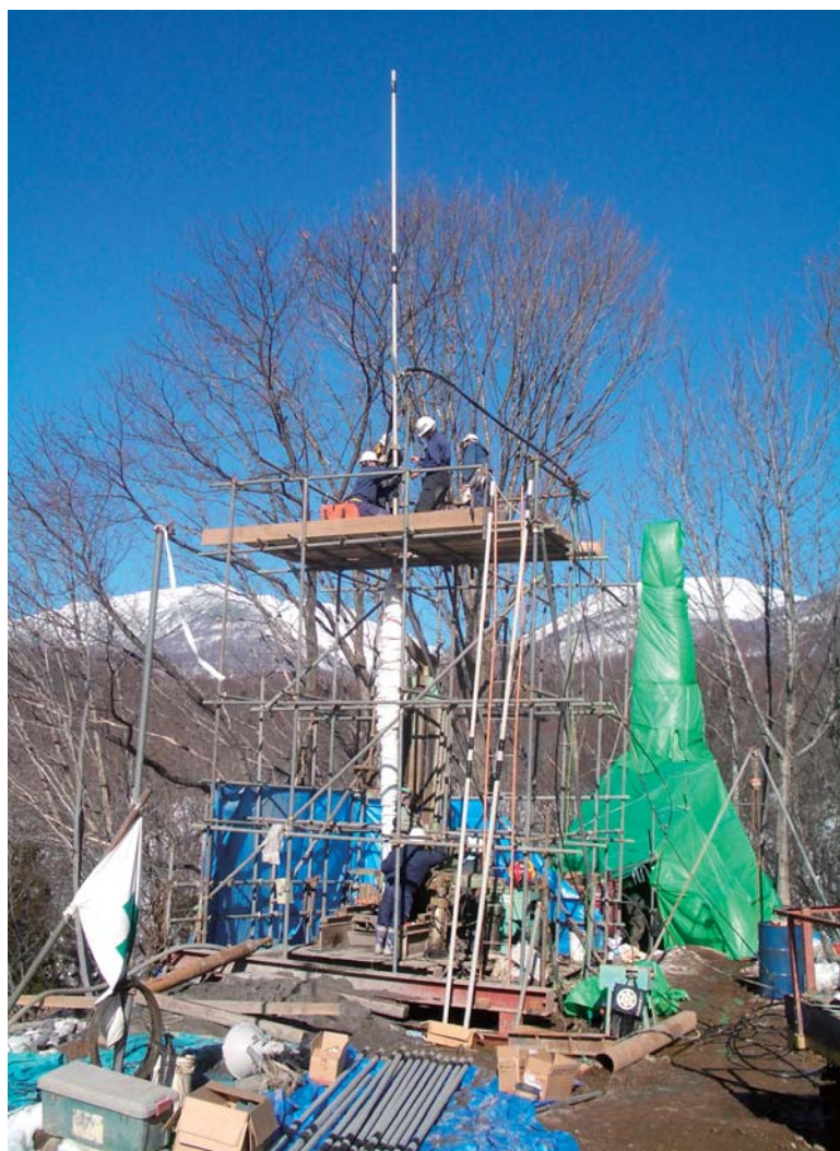
写真3-3 ガイド管の組立て足場の仮設例
