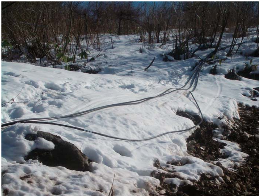
写真3-8 グラウトホースを伸ばした事例
