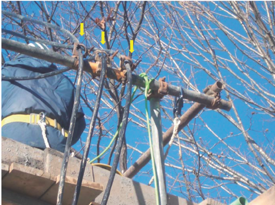
写真3-10 グラウトホースが重ならないようにクランプで工夫した事例
