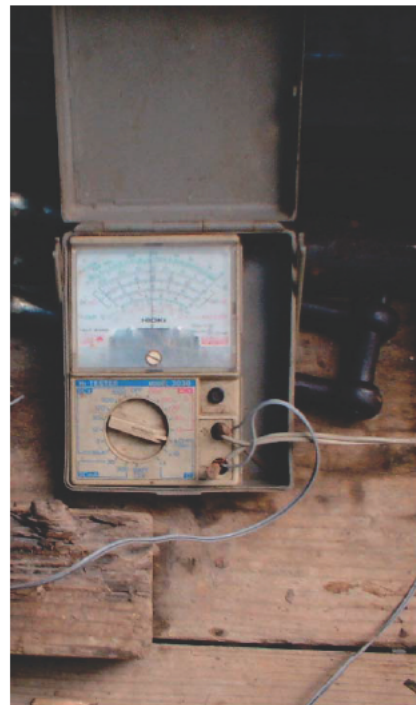
写真3-32 通電確認状況
