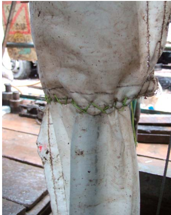
写真3-37 パッカー縫合部の状況 (共上がりして苦労した)
