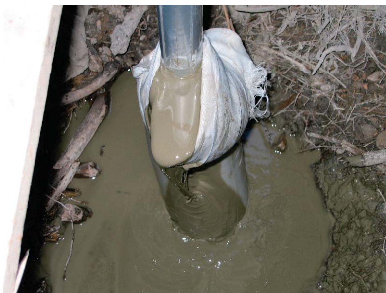
写真3-27 充填材が上昇している孔口の確認状況
