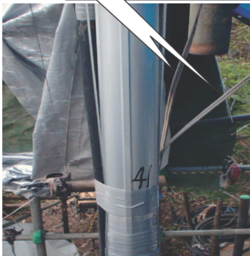
写真3-31 電線貼付け状況
