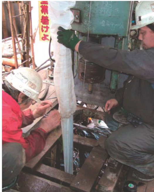
写真3-36 パッカー縫合状況 (現場の寒さに加え、細かい作業となる)
