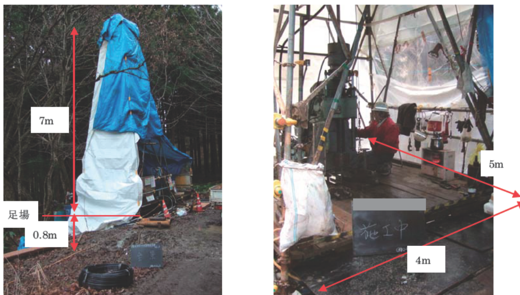
写真3-35 作業スペースの状況
