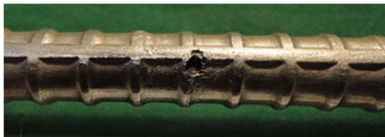
(a)孔食による断面欠損を伴う腐食
