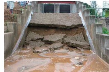
写真-6 越水130分後
