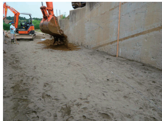
写真-3.9 堤体材料の運搬状況（山砂）
