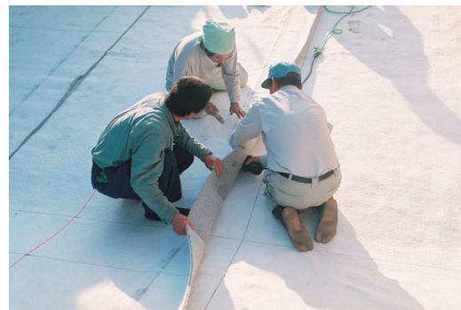
写真-2.1 堤防模型作製（締固め作業） 写真-2.2 吸出し防止シート設置（繋ぎ目溶着）
