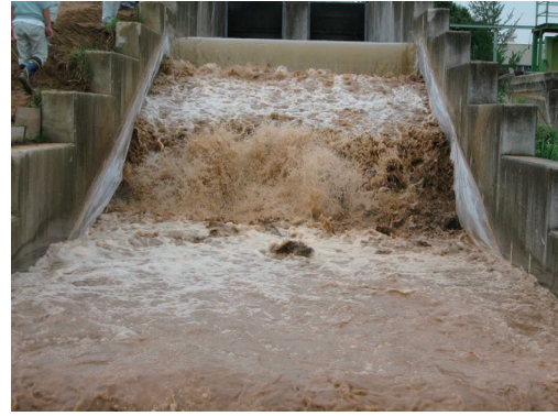
写真-3.35 越水131分後
