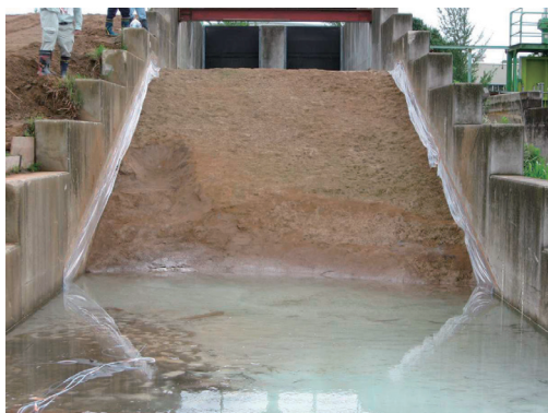
写真-3.28 簡易補修後（越水120分後）
