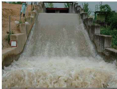
写真-4 越水90分後
