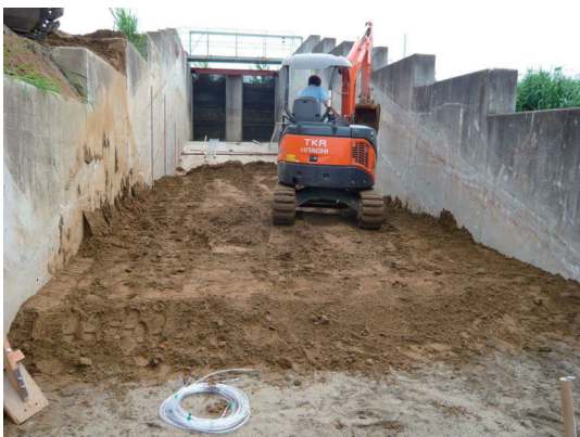
写真-3.10 堤体材料の敷均し状況
