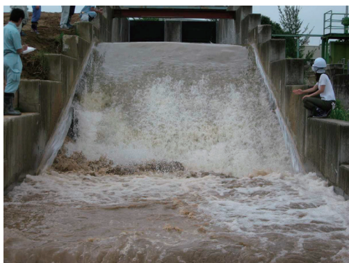
写真-3.30 越水123分後
