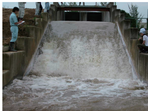
写真-3.29 越水121分後
