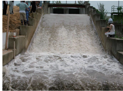
写真-3.17 越水5分後
