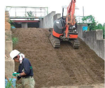
写真-9 施工状況(転圧)
