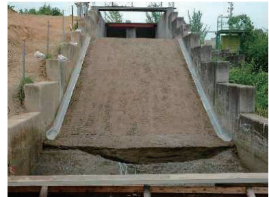
写真-3 越水60分後
