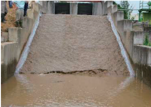
写真-3.25 越水60分後
