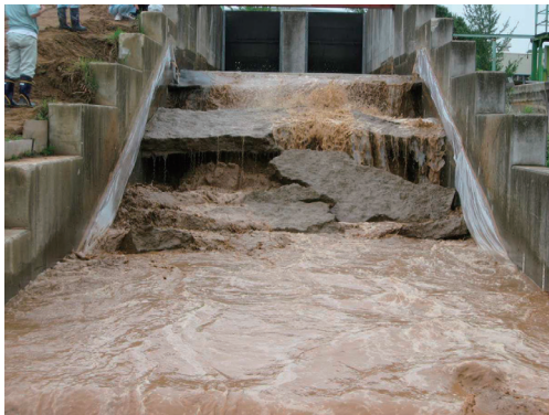
写真-3.36 越水132分後
