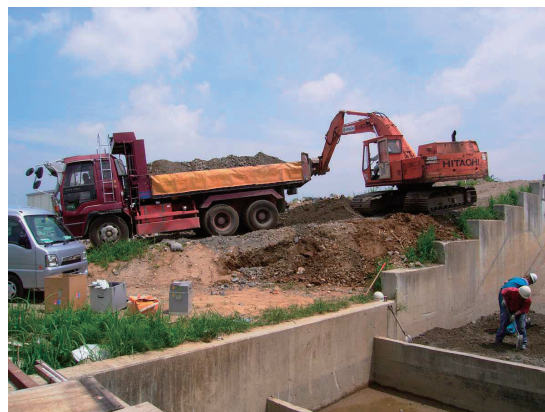
写真-3.3 土質材料の運搬状況
