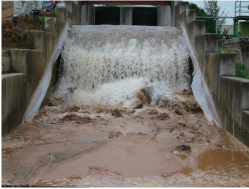
写真-3.34 越水130分後 再開直後
