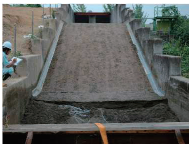
写真-7 越水180分後
