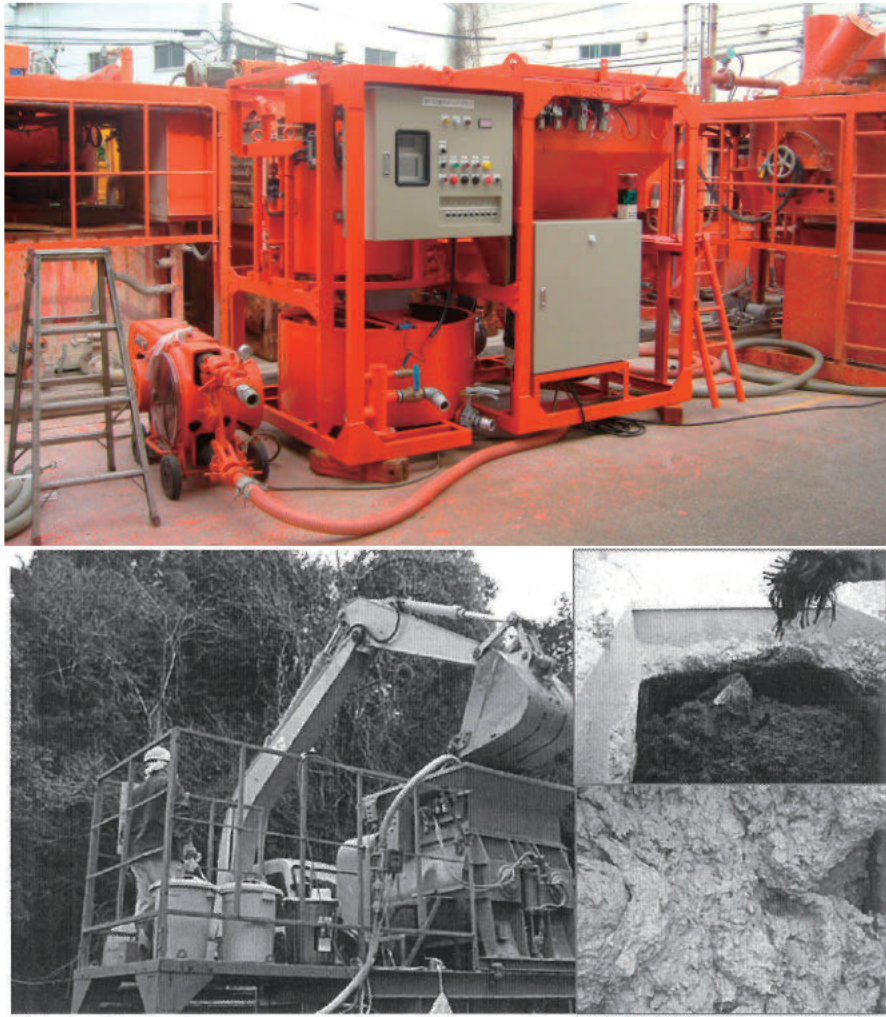
写真-3.1 強制攪拌方式（ドライタイプ）（工法1）の施工状況例
