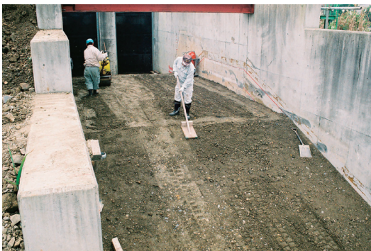
写真-2.1 堤防模型作製（締固め作業） 写真-2.2 吸出し防止シート設置（繋ぎ目溶着）
