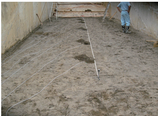
写真-3.8 マノメーター設置状況
