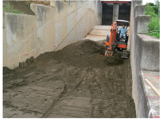
写真-3.5 基礎地盤の敷均し状況
