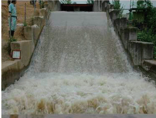
写真-3.43 越水150分後
