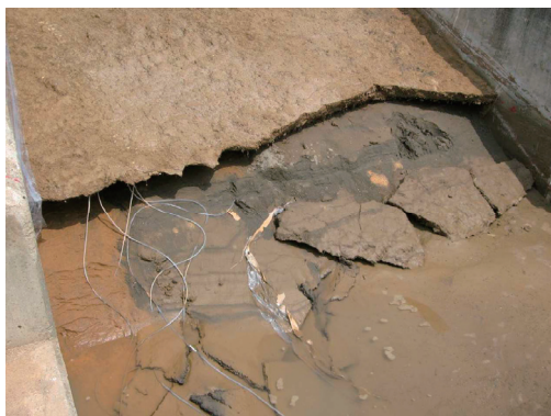
写真-3.21 短繊維混合補強土下側の状況
