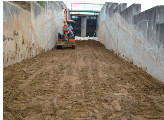
写真-3.11 堤体材料の転圧状況
