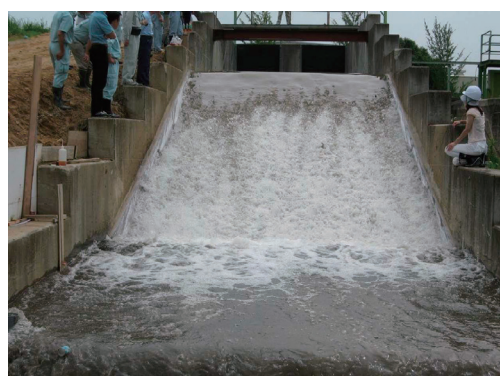
写真-3.15 越水1分後
