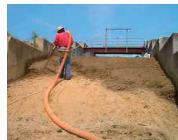
写真-9 施工状況(吹付)
