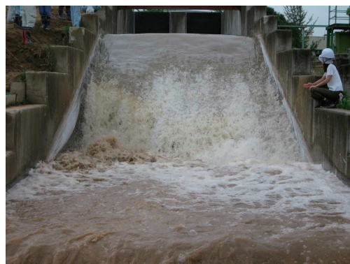
写真-3.31 越水125分後
