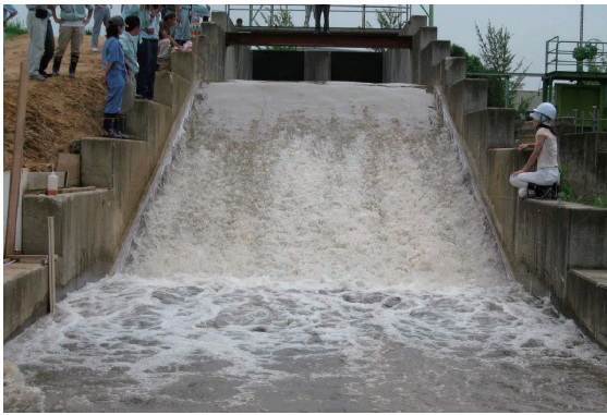
写真-3.16 越水3分後
