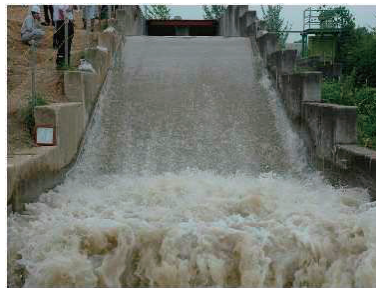
写真-2 越水30分後
