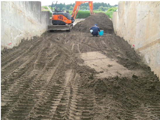
写真-3.6 基礎地盤転圧状況
