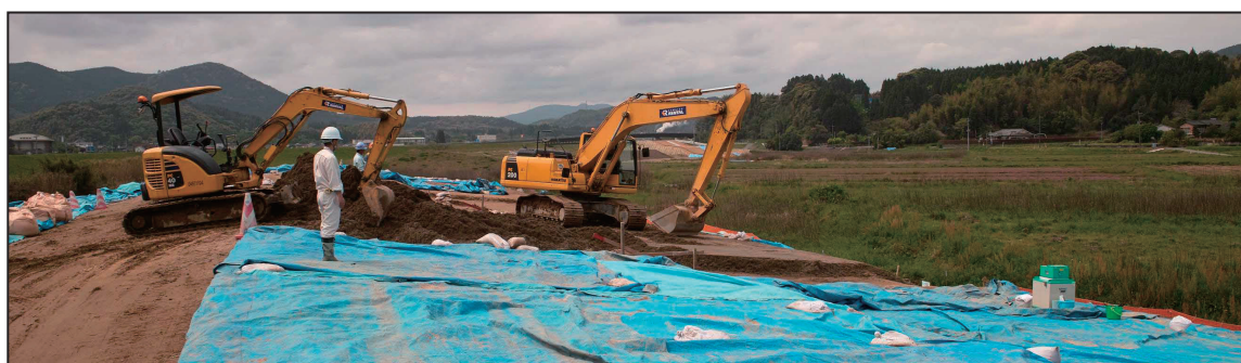
写真-5.3 転圧状況
