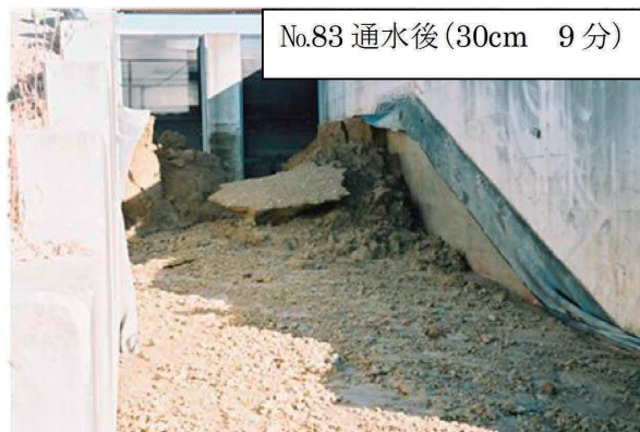
写真-2.5 湛水有り、裸堤の実験 (ケース83)
