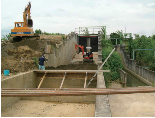
写真-3.4 材料搬入状況（川砂）
