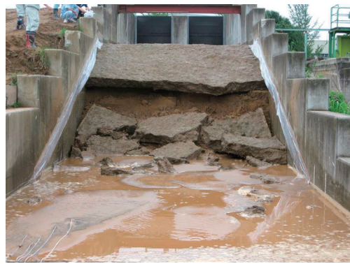
写真-3.33 越水130分後
