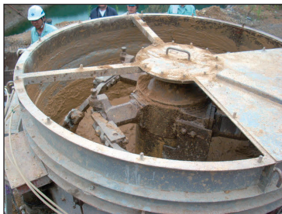
写真-5.1 強制攪拌方式の混合状況
