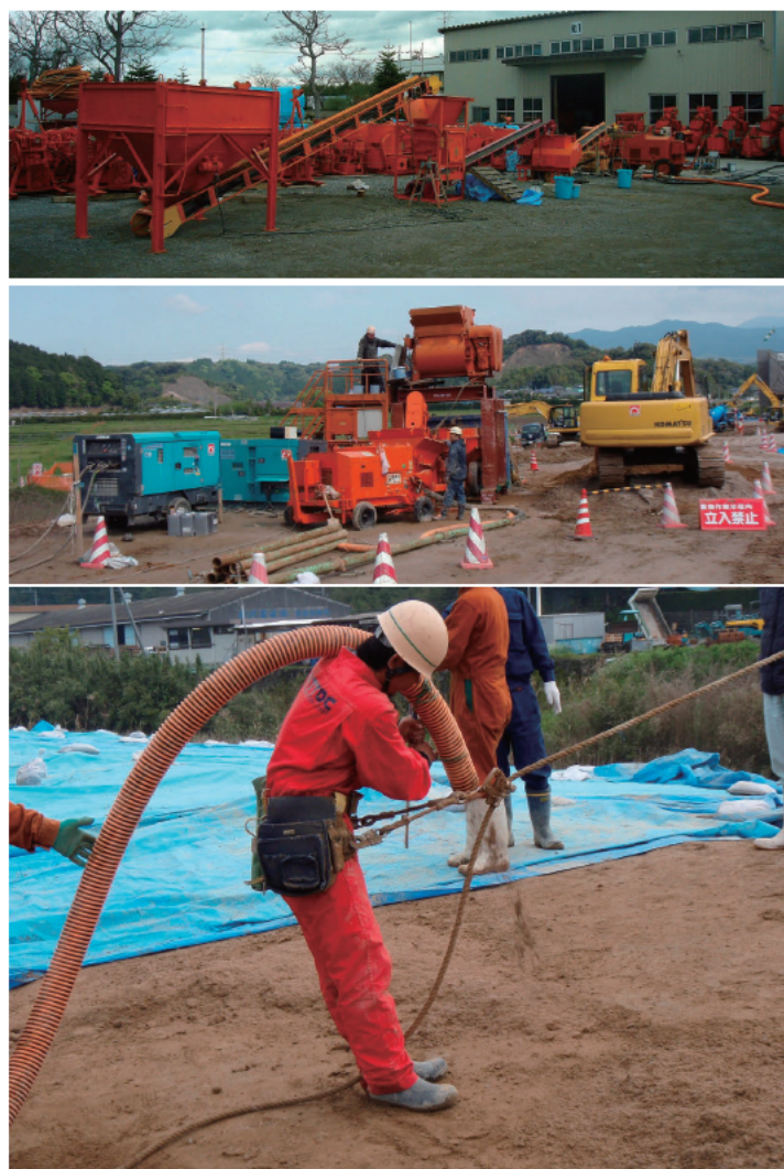
写真-3.2 強制攪拌方式（ドライタイプ）（工法1）の施工状況例
