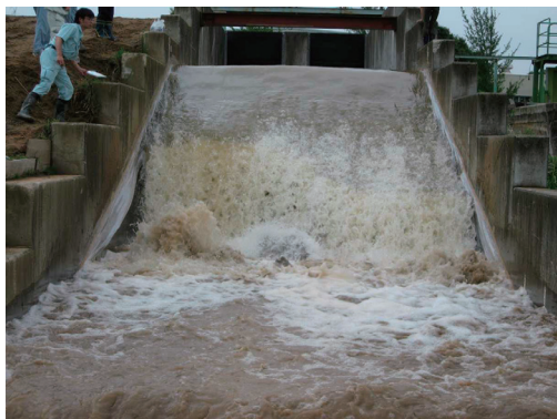
写真-3.32 越水127分後
