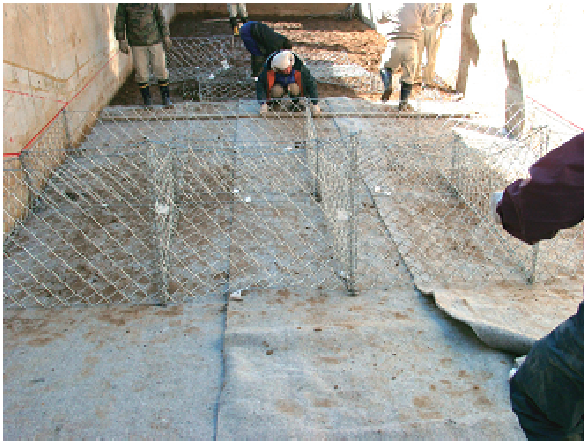
写真-4.1 のり尻工及びドレーン工 (鉄線枠)
