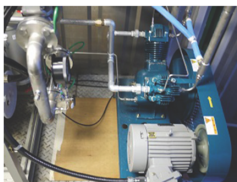
写真-16 冷却配管設置状況
