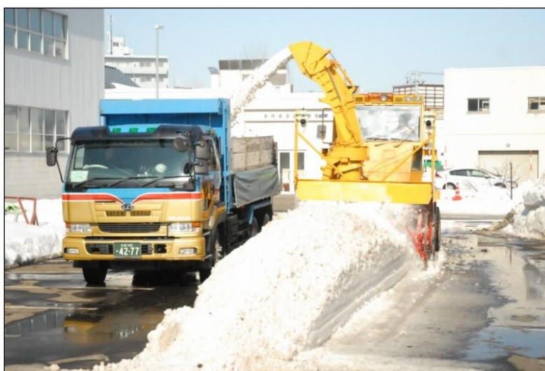
写真- 19 ダンプトラックへの積み込み状況
