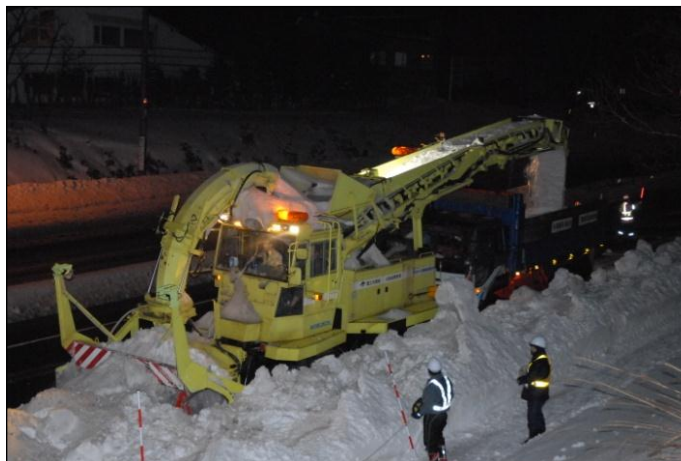
写真- 16 現場試験状況
