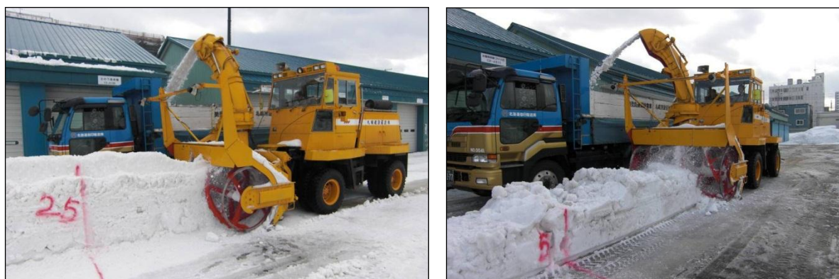
写真- 15 雪堤除雪状況 (左：高雪堤、右：低雪堤)
