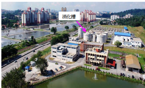
写真-1 Pantai下水処理場
