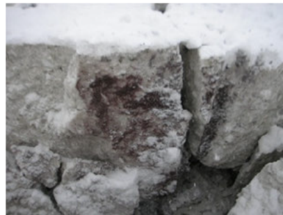
写真-14 雪に付着した残渣状況
