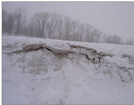
施工法 5の下から
