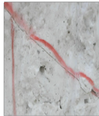
切断後の状況
