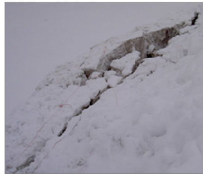
施工 3面上から
