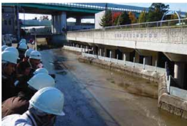
白子川比丘尼橋下流調整池取水口
