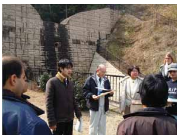
広島市内の砂防堰堤
