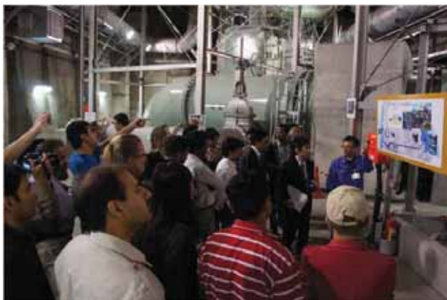
川治ダム・五十里ダム連結トンネル
