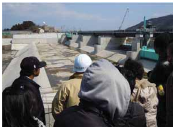
斐伊川放水路建設現場
