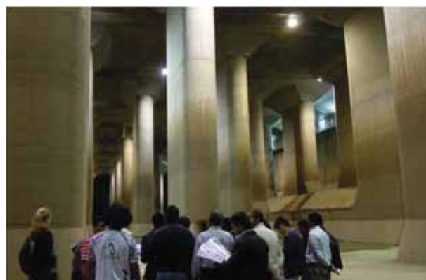
首都圏外郭放水路内 調圧水槽
