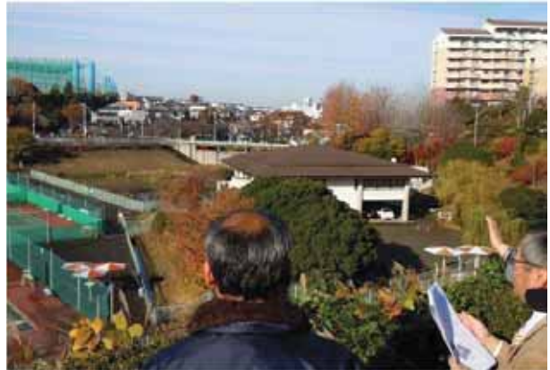
霧が丘調整池
