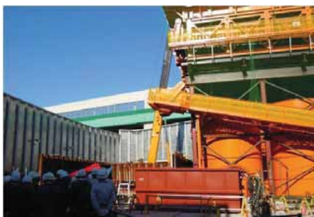
立坑建設現場
