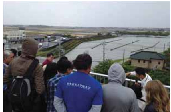
事務所屋上から陸側を遠望
