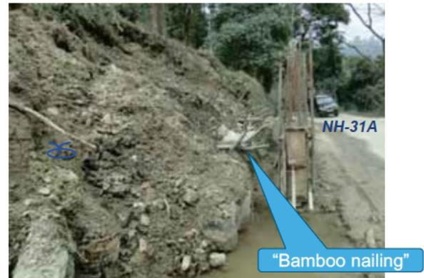
写真-1 BRO による bioengineering 的手法の活用(竹材によるネイリング)。平成 24 年 3 月の日印合同調査時の状況。無降雨時であるが、斜面からは湧水が認められた。写真外の斜面上方にも顕著な変状が生じている。
