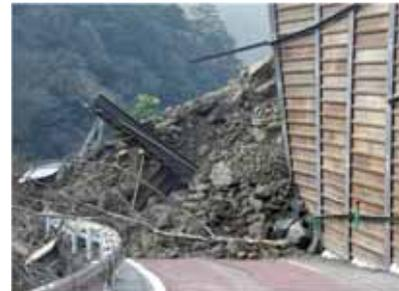
図1.仮設防護柵被災事例
