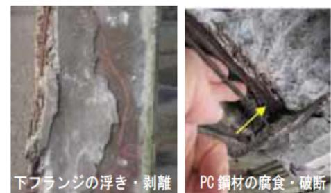
写真-2 損傷状況
