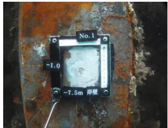
第2回試験 岸壁(-7.5m)No.1
