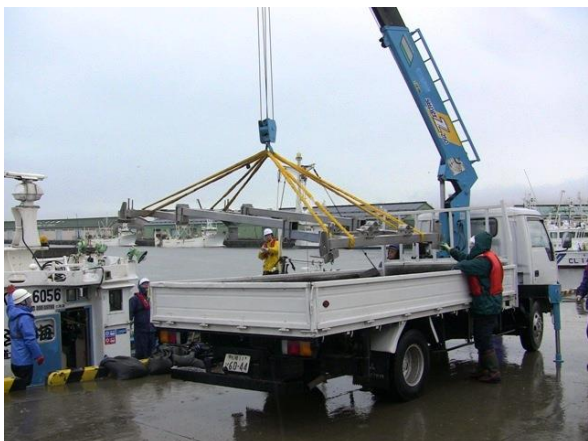
艀装用架台設置
