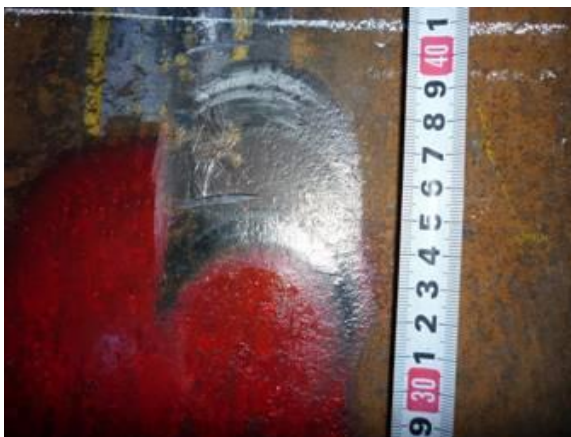
第1回試験 ケレン状況
