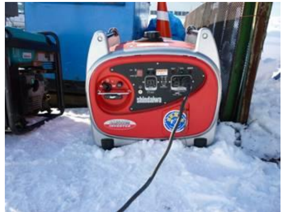
第1回試験 発電機
