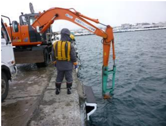
第2回試験 付着物除去状況
