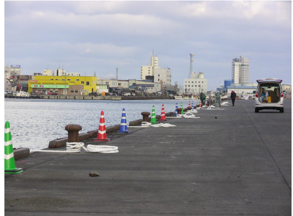
陸上作業（ロープ投入、セーフティーコーン設置）
