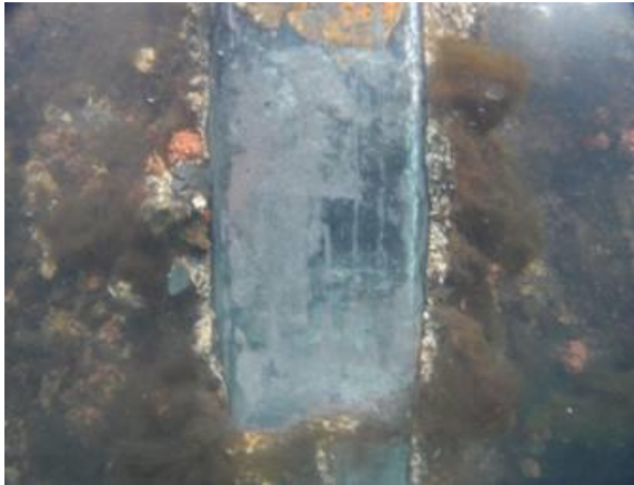
第2回試験 バケットによるケレン
