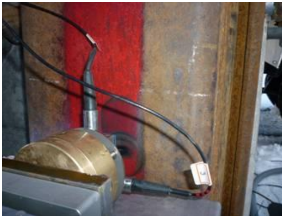
第1回試験 ケレン状況
