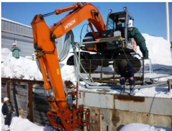
第1回試験 架装装置設置状況
