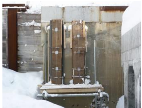
第1回試験 鋼矢板設置状況
