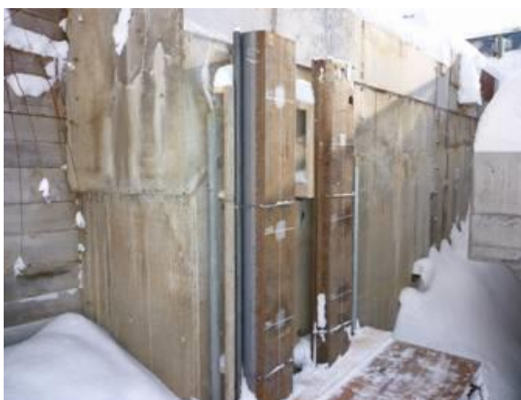
第1回試験 鋼矢板設置状況
