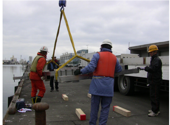
艀装用架台撤去
