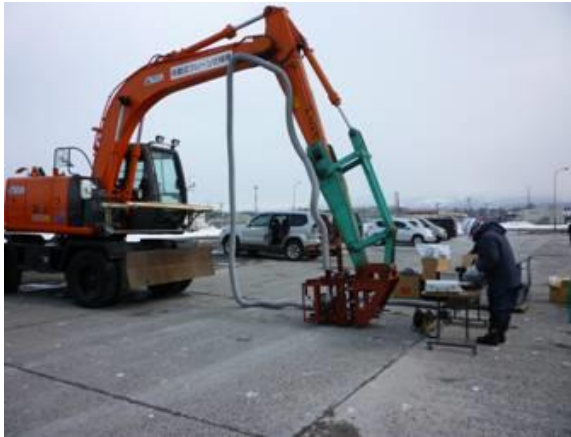
第2回試験 架装装置設置状況
