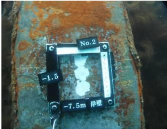
第2回試験 岸壁(-7.5m)No.2
