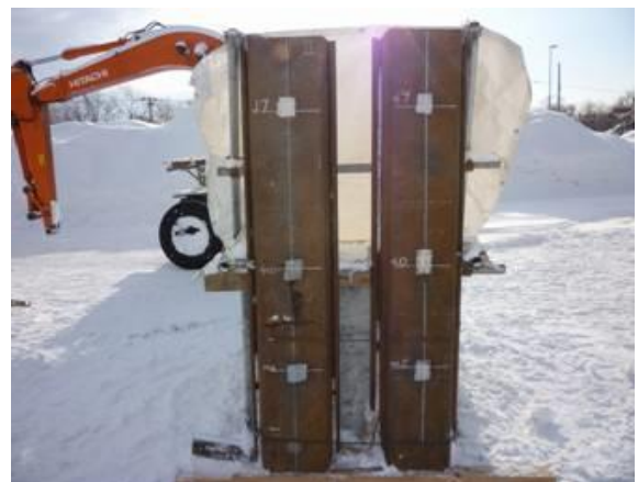
第1回試験 鋼矢板設置状況
