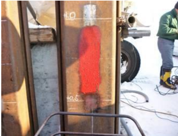
第1回試験 ケレン状況
