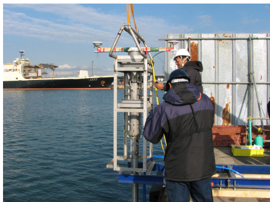
陸上計測架台設置状況
