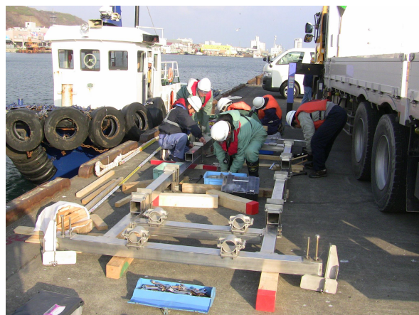
艀装用架台組立
