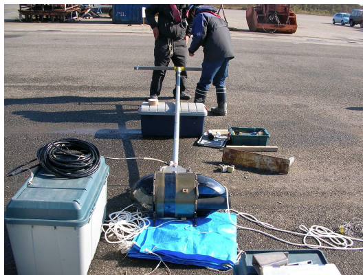
パイプへの取付状況
