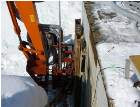
第1回試験 架装装置設置状況
