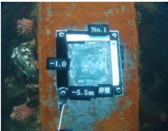
第2回試験 岸壁(-5.5m)No.1
