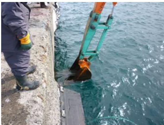
第2回試験 付着物除去状況
