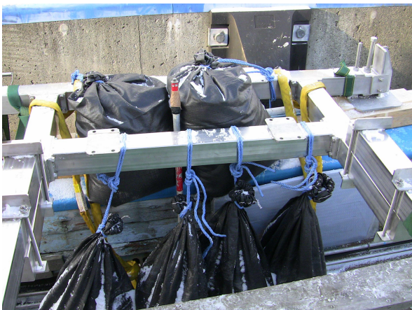
艀装用架台設置（ウエイト設置）
