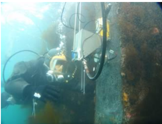
第2回試験 マグネットによる設置状況
