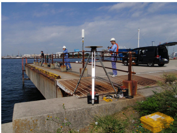
陸上作業（GPS 基地局設置）
