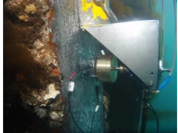
第2回試験 マグネットによる設置状況
