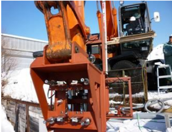
第1回試験 架装装置設置状況
