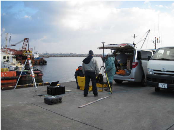
陸上作業（GPS 基地局設置）
