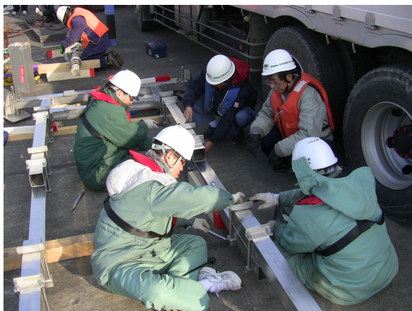
艀装用架台組立
