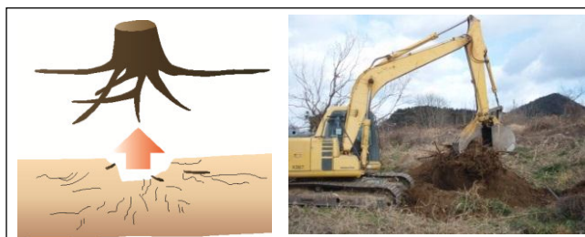
図-13 除根のイメージ(左)及び作業状況(右)
