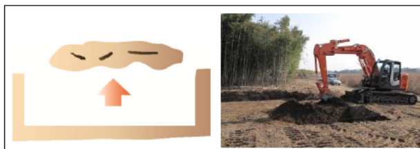
図-30 土砂掘削のイメージ(左)及び作業状況(右)
