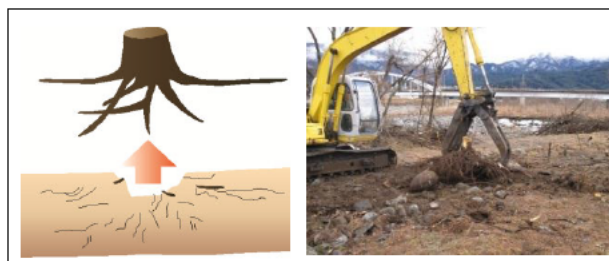
図-18 除根のイメージ(左)及び作業状況(右)
