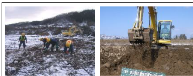
図-22 木片除去の状況 (人力(左)及びスケルトンバケット(右))
