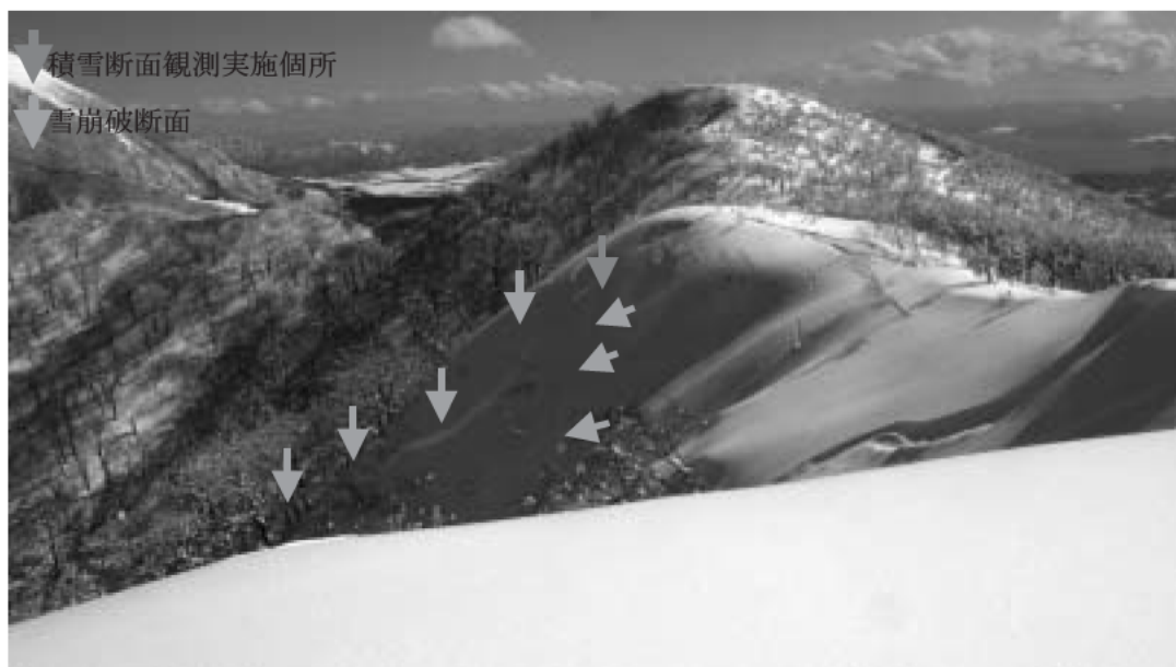
図 5-32 雪崩発生区の状況(遠景)
