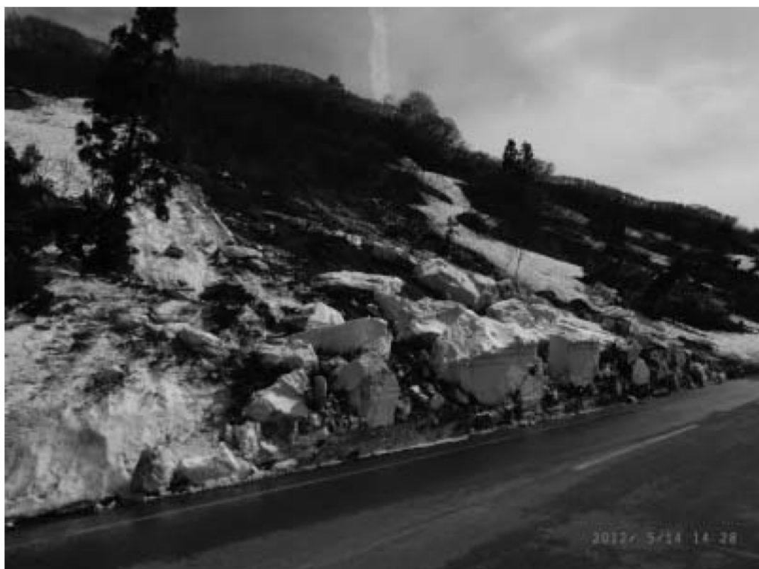
図 5-56 雪崩堆積物の状況
