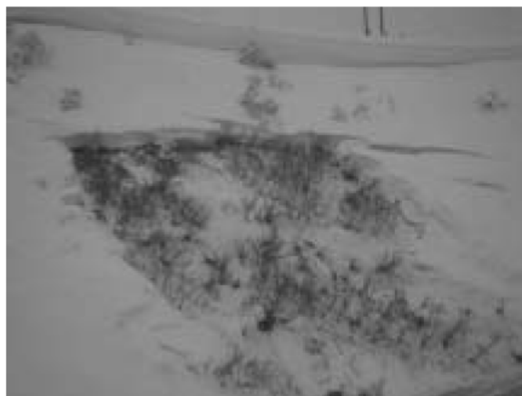
図 5-65 雪崩発生箇所
