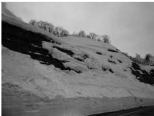
法面上の雪が崩落している状況
