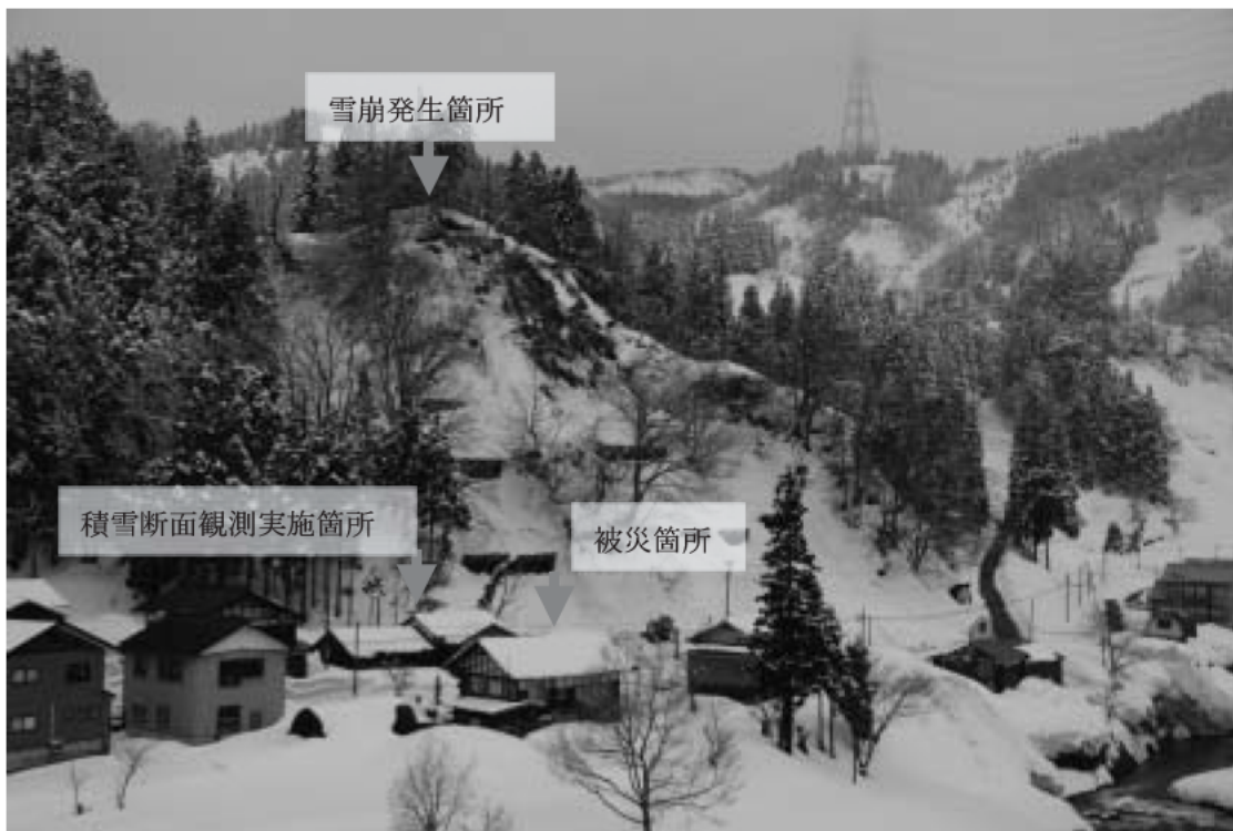
図 5-25 雪崩発生箇所全景
