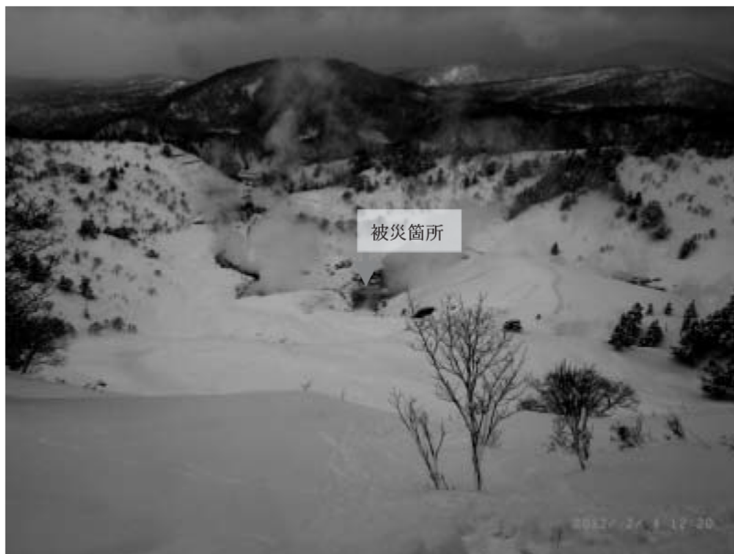
図 5-13 雪崩発生区からみた被災箇所
