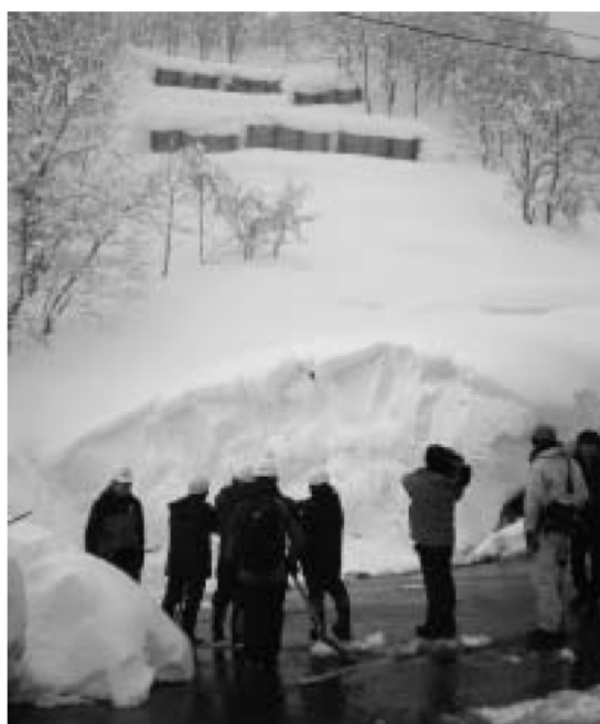
雪崩予防柵の雪庇の発達状況の点検
