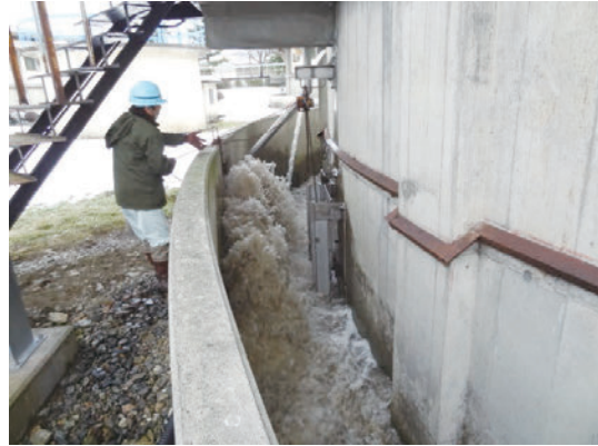
散水ろ床の湛水時の通水ゲートの解放作業（ろ床内に一時的に貯留された水と閉塞物が一気に流出する）
