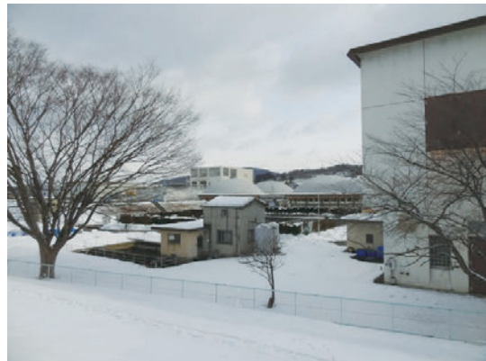
散水ろ床外観遠景(中央部ドーム型覆蓋)
