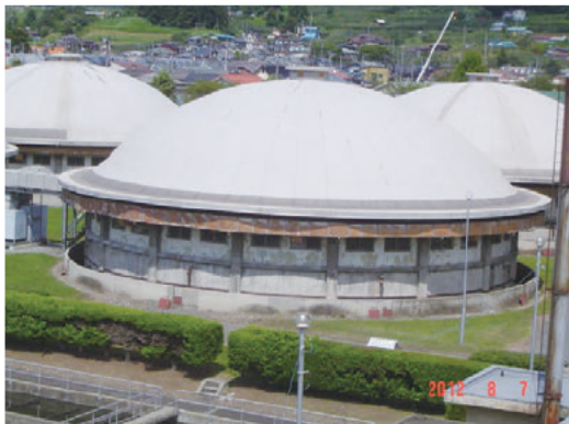
散水ろ床外観近景
