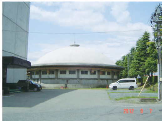
散水ろ床外観近景
