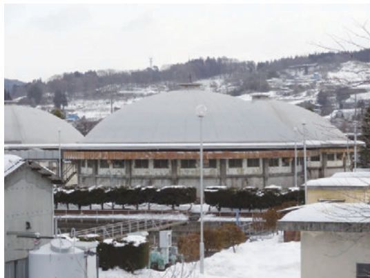
散水ろ床外観近景(中央部ドーム型覆蓋)
