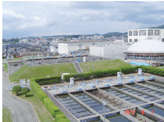
最初沈澱池、散水ろ床、最終沈澱池(高低差が付いている)
