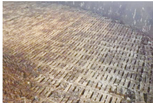
ろ床底部(写真は盛岡市上下水道局下水道施設管理課より提供)
