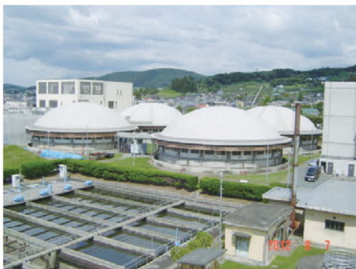
散水ろ床外観遠景
