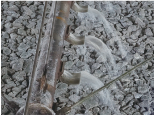
吹き出し口の形状(ノズルとプレートは週1回洗浄)
