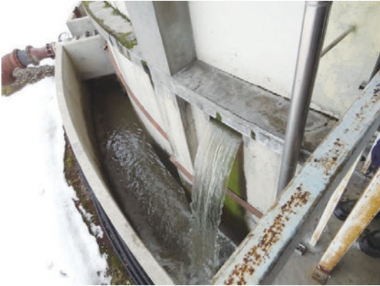
散水ろ床の湛水時の放流口からのオーバーフローの状況
