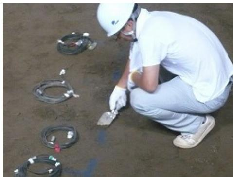
(a) 間隙水圧計の設置状況
