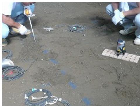
(b) 間隙水圧計の設置状況
