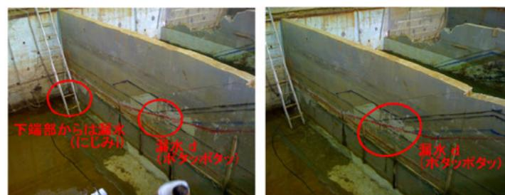
図-A.6 ピットC側での漏水状況写真
