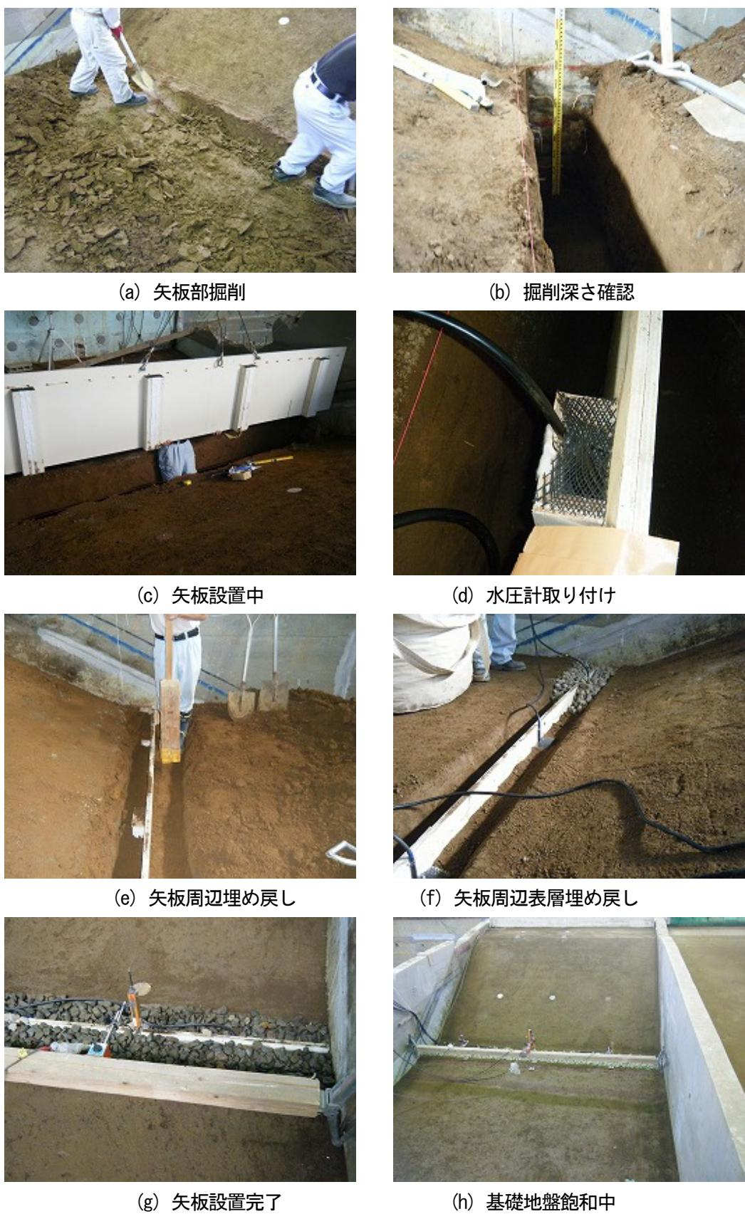
図-C.4 ケース 2 模型製作状況
