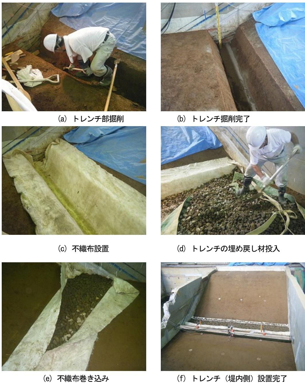
図-C.5 ケース3模型製作状況
