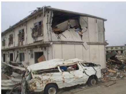
Fig. 13 Debris impact
