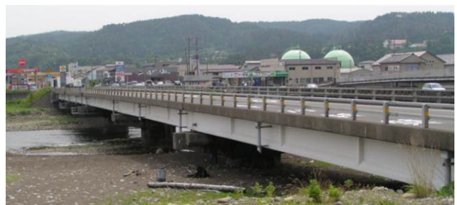
写真-1 橋梁全景 (A2側から撮影)
