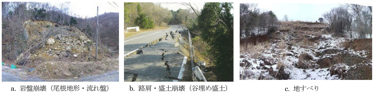
写真 4-1 宮城県、福島県の道路斜面災害の代表事例
