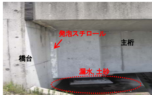
写真-3 コンクリート道路橋桁端部の状況
