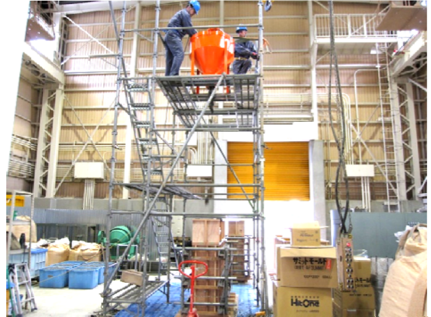
写真2 4m からの打込み状況
