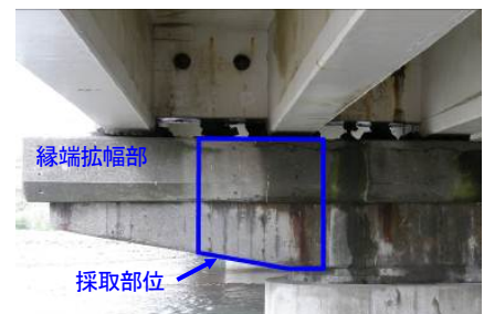
写真-2 P4橋脚 (A2側)
