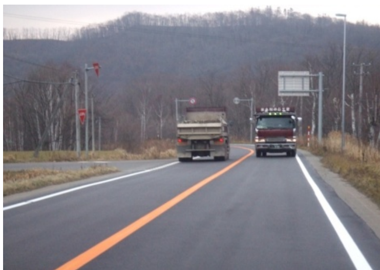
写真-1.1 北海道郊外部の典型的な2車線道路
