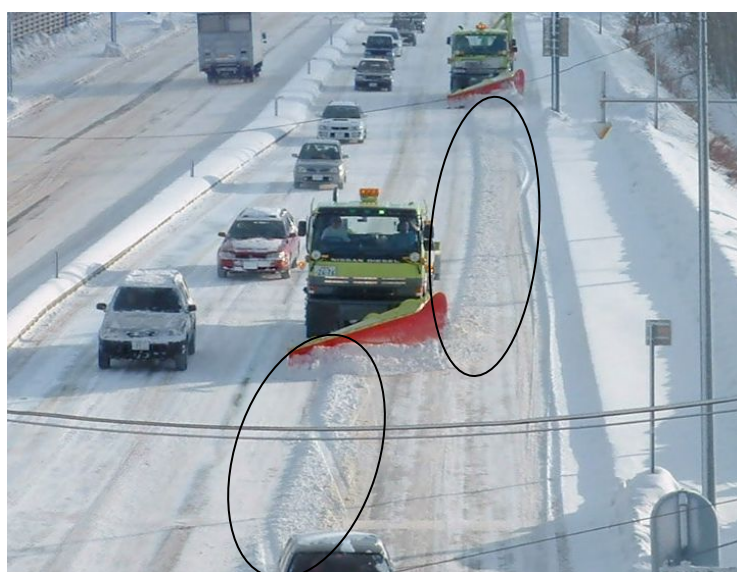
写真-4.2 除雪による車線上の雪堤発生状況
