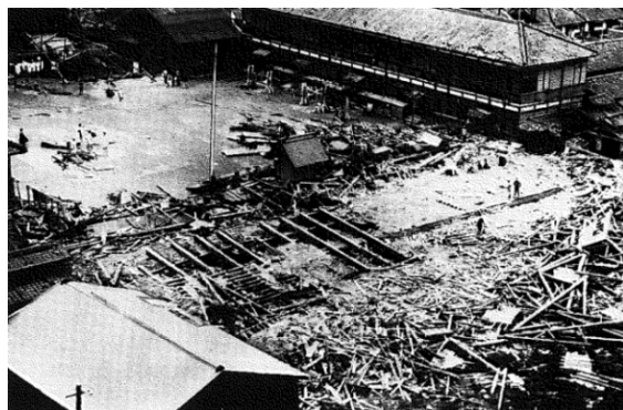
室戸台風（1934年）で被害を受けた大阪市内の小学校 [18]
