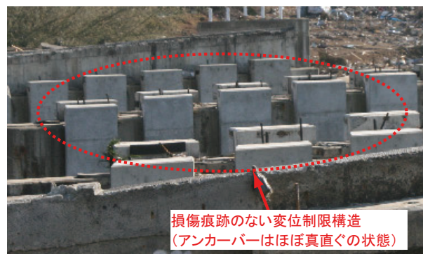
写真-3 損傷が見られない変位制限装置（沼田跨線橋）
