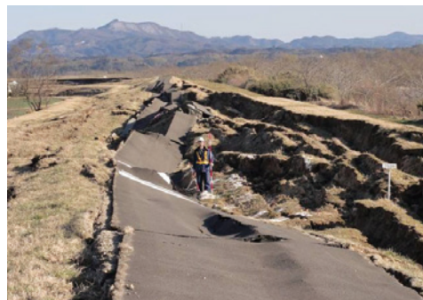
写真-1 河川堤防の大規模な被害 (阿武隈川下流右岸 30.6k+34～31.4k+160) 3)
