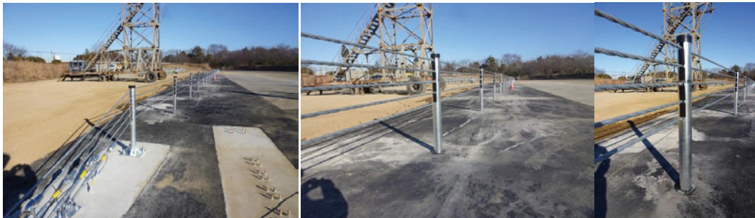
写真-6 突試験施設での設置状況
