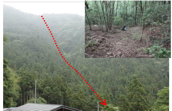
写真-10 奥多摩町(H地区)で発生した雪崩経路の斜面状況と発生区の状況(2014年6月18日撮影)
