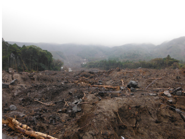
写真-3 神達地区の被災状況
