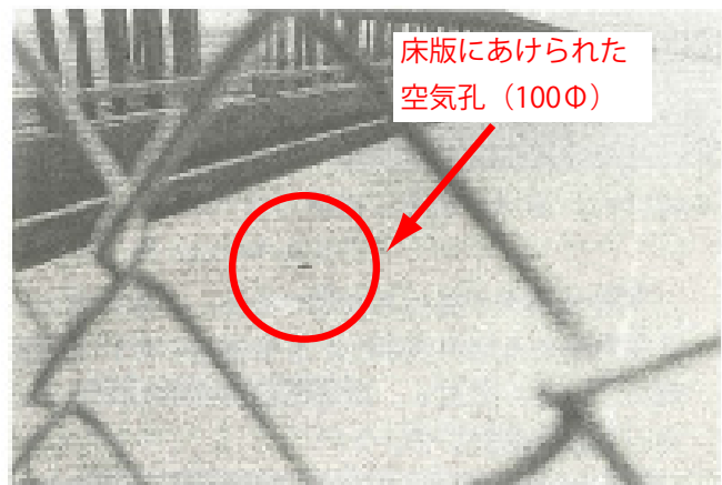
写真-11 桁間の空気溜り対策の事例 (I-10, アメリカ) 16)
