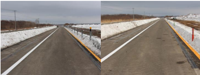
写真-11 走行試験区間の状況
