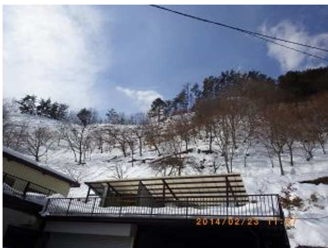
写真－７ 雪崩が発生した斜面の状況(山梨県大月市)
