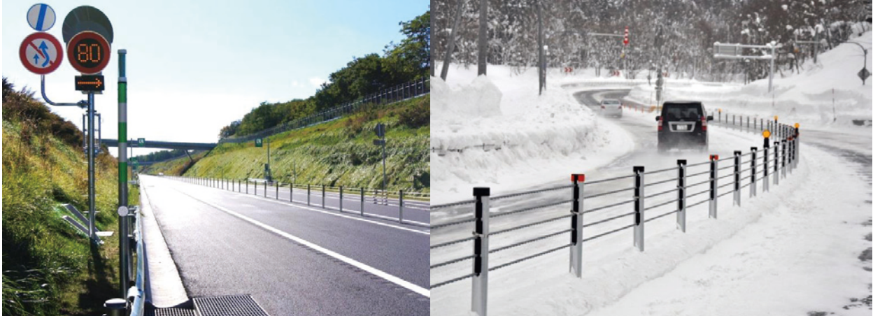
写真-14 道央自動車道(左)と一般国道275号(右)
