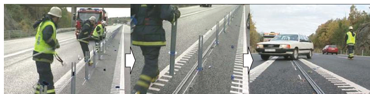
写真-4 緊急時の開口部設置 1)
