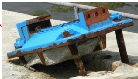
写真-9 津波による実橋における支承の破壊状況 (小泉大橋)
