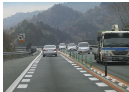
写真-1 暫定2車線道路
