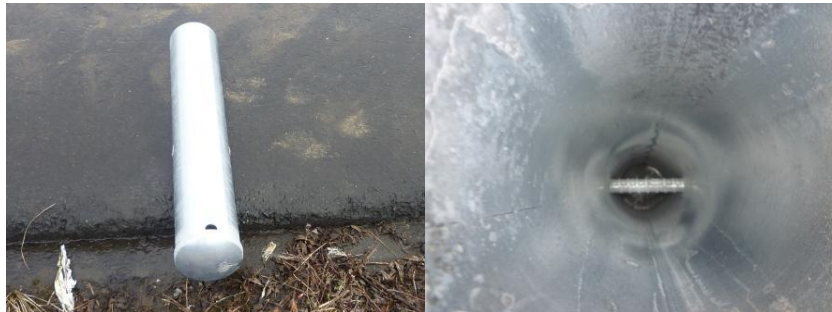
写真-9 スリーブ(左)と管内の支柱支え(右)
