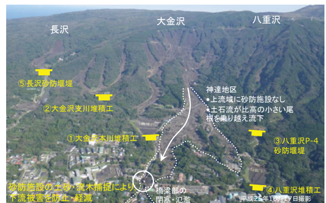
写真-6 土石流発生状況と砂防施設配置状況
