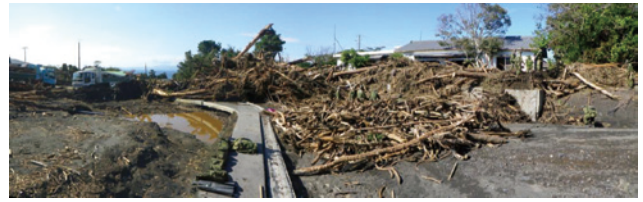
写真-8 橋梁部の閉塞に伴う溪流保全工内の土砂・流木堆積状況
