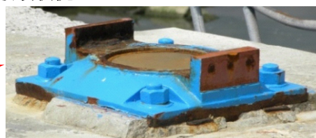
写真-8 支承の破壊状況
