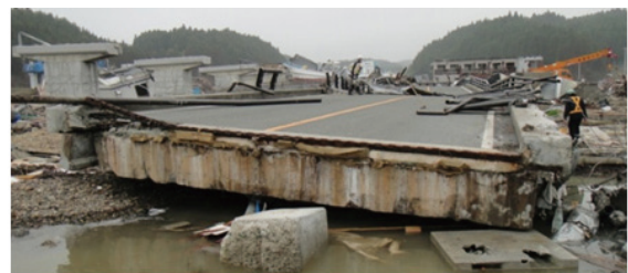
(b) 橋が裏返らずに流出した橋 写真-1 上部構造が流出した橋
