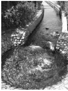
写真-1 せせらぎ水路A
