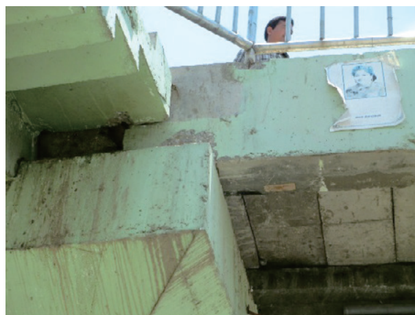
写真-4 アルニコハイウェイの横断歩道橋の基礎の変位による橋桁部でのずれ
