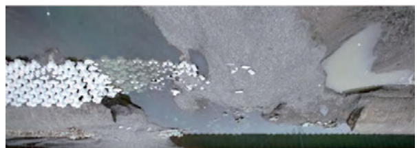
図-20 根固めブロックに破堤が到達
