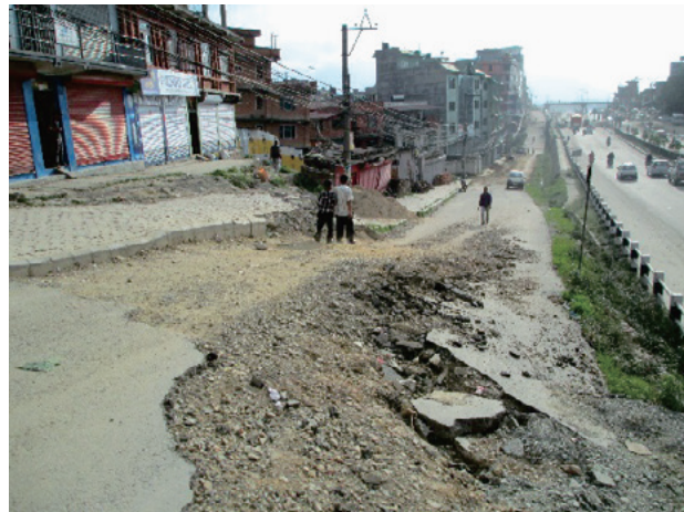
写真-3 アルニコハイウェイの土工部のクラック、沈下
