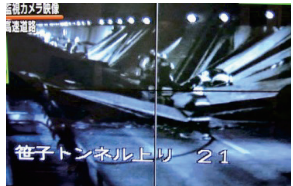
図-1 笹子トンネル
