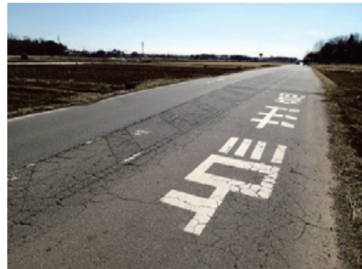
写真-12 路面状況
