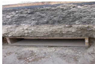
写真-4 模擬空洞敷設状況 (空洞 A)
