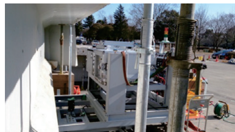
図-4 撤去桁の撮影
