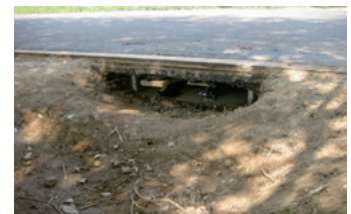
写真-5 模擬空洞敷設状況 (空洞 C)
