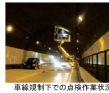
車線規制下での点検作業状況
