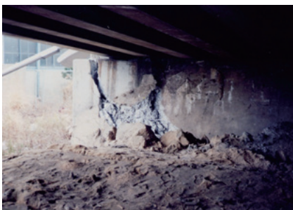
写真－1 側方流動に伴って生じたと考えられる橋の被害
