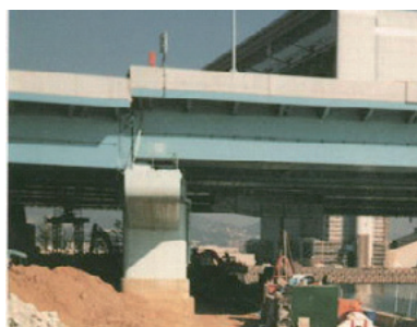
写真－1 側方流動に伴って生じたと考えられる橋の被害
