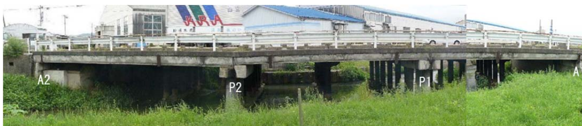
写真-2.1 橋梁全景（平成20年度橋梁点検調査）
