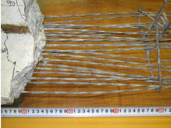
b) 6' ~ 3' 断面付近 (下フランジ側)
