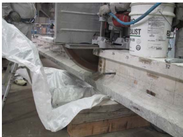
写真- 4.1 解体状況 (左 : 桁切断 右 : 桁中央はつり後)
