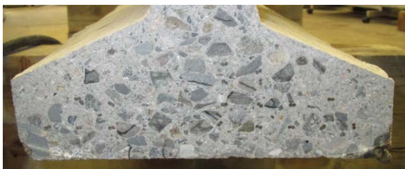
c) G6 桁 22' 桁切断面（下フランジ）
