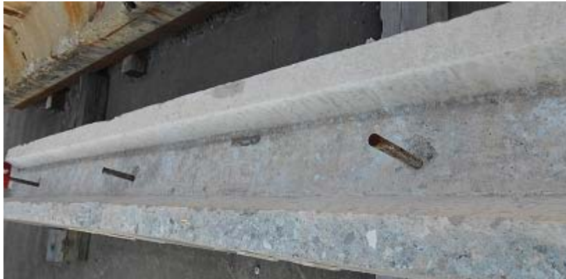
b) 桁側面 (A面側)
