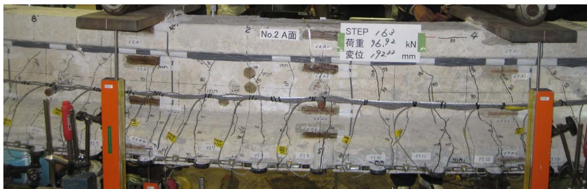
写真- 3.7 96.9kN 載荷時 桁側面ひび割れ状況
