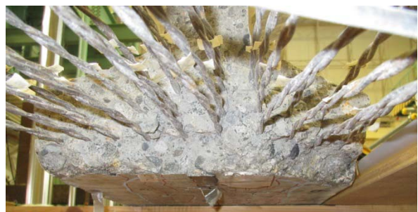
b) G3 桁 6 断面付近（はつり調査）
