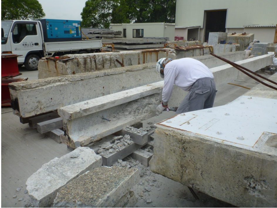
写真- 2.4 はつり状況 (G6 桁)
