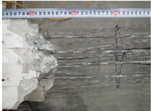
e) 6' ~ 3' 断面付近 (上フランジ側)
