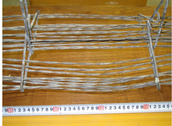
c) 3' ~ 3 断面付近 (下フランジ側)
