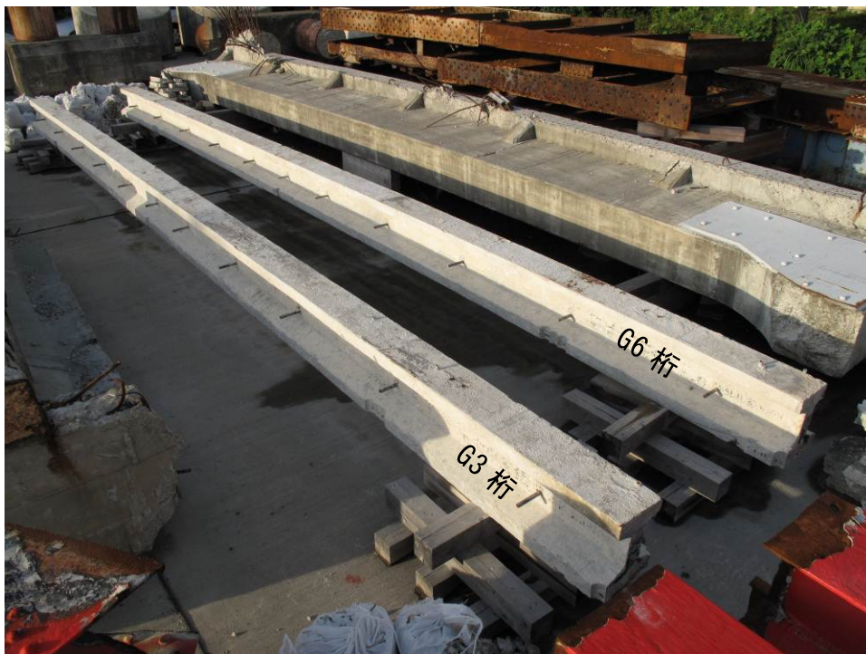
写真- 2.5 はつり後の状況 (手前 G3 桁、奥 G6 桁)
