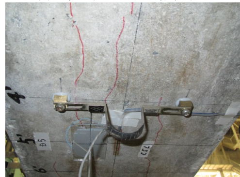
下面π型変位計設置状況
