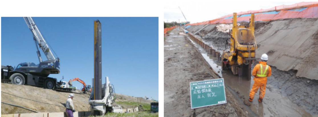
写真-9.4.1 矢板打設状況
