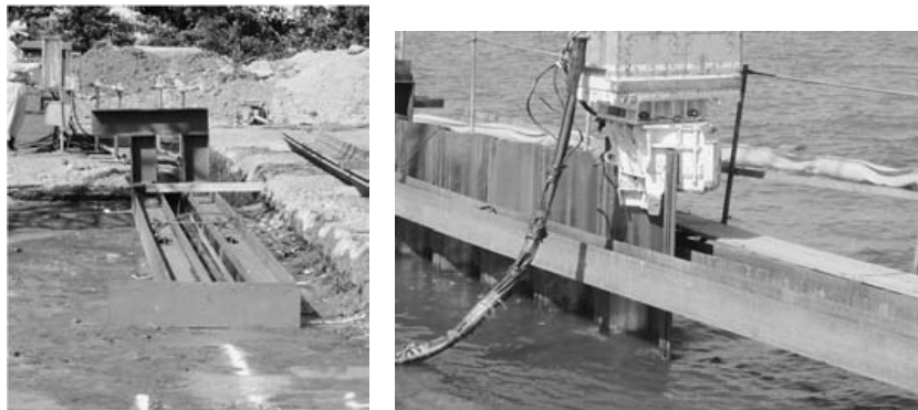
図-9.4.1 導枠工の例
