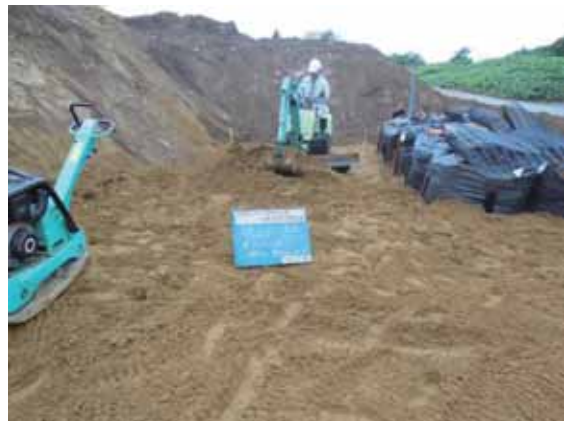
写真-4.2.2-5 大型土のう1段目裏込め材の撒出し・敷均し状況
