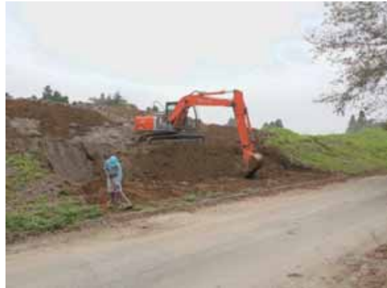
写真-4.2.1-21 既設盛土掘削状況
