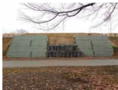
写真-21 施工完了
