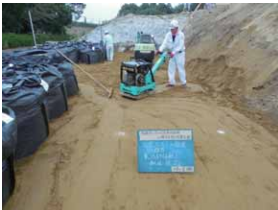
写真-4.2.2-6 大型土のう1段目裏込め材の転圧状況
