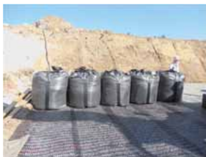
写真-1 大型土のう
