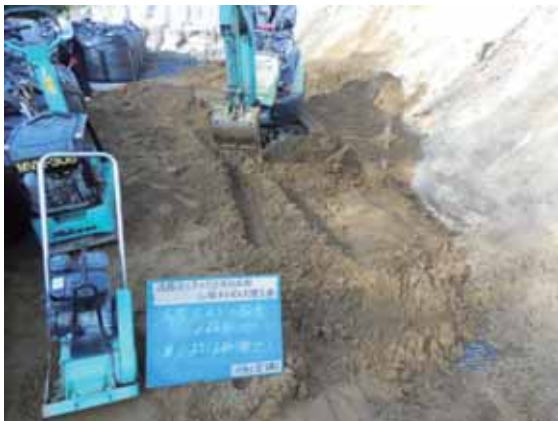
写真-4.2.2-5 大型土のう1段目裏込め材の撒出し・敷均し状況
