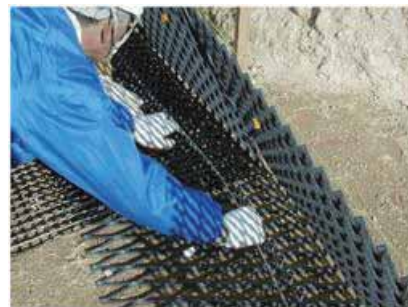
写真-15 連結用のジオテキスタイルの接続
