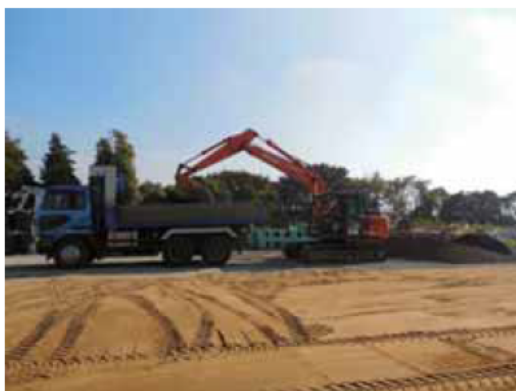
写真-7.1.2-1 トラック及びダンプトラック写真
