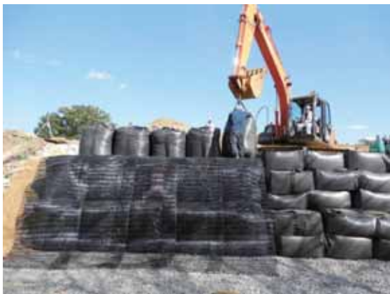
写真-4.2.2-10 3段目の大型土のう設置状況
