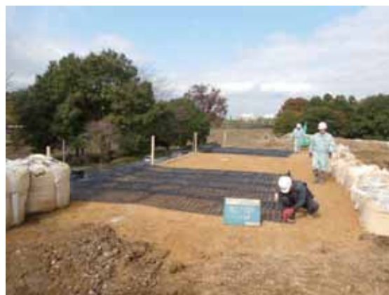
写真-4.2.2-15 補強材の設置状況
