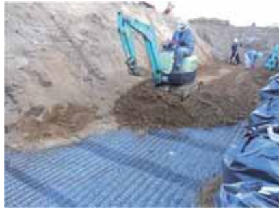
写真-12 盛土材のまき出し
