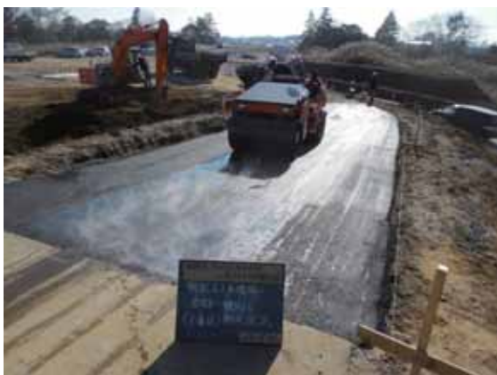
写真-4.2.4-12 上り側スロープの舗装工：延長
