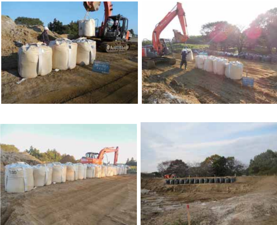
写真-4.2.2-14 上載盛土背面側の土のう設置状況
