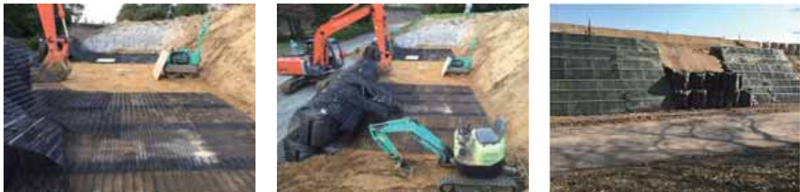
写真-7.3.2-1 敷設および壁面の状況
