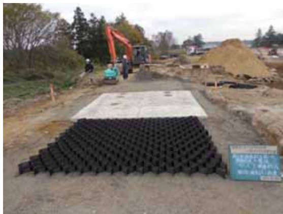
写真-7.1.3-2 格子状補強材 A の設置状況
