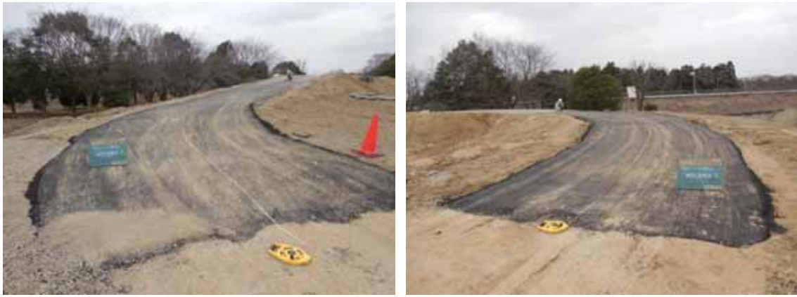
写真-4. 2. 4-13 舗装延長区間距離計測
