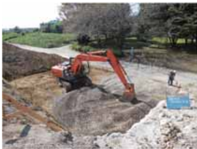
写真-2 砕石のまき出し状況
