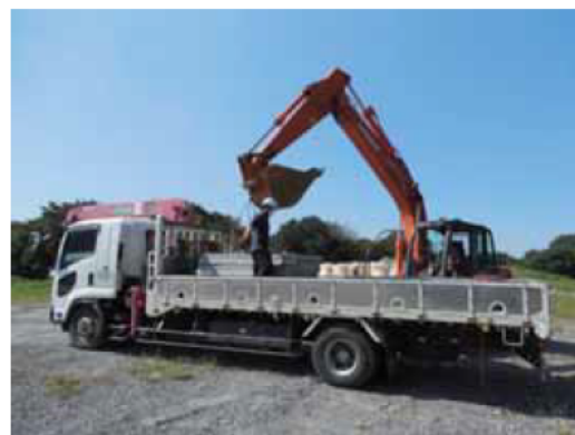
写真-7.1.2-2 トラッククレーン写真
