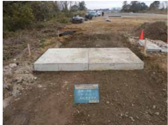
写真-7.1.3-6 路面段差を模倣した地盤の造成と床版の設置状況
