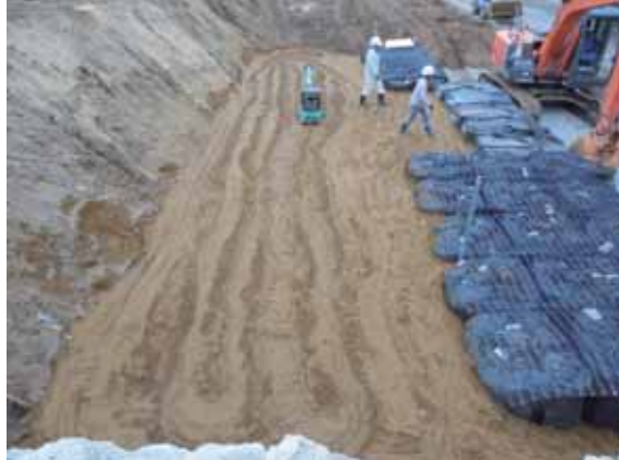
写真-4.2.2-6 大型土のう1段目裏込め材の転圧状況
