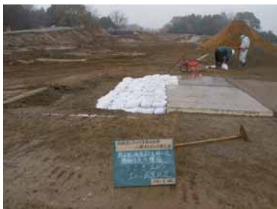
写真-7.1.3-13 土のう(一般)の設置，段差擦り付け状況：応急復旧段階(復旧盛土構築)
