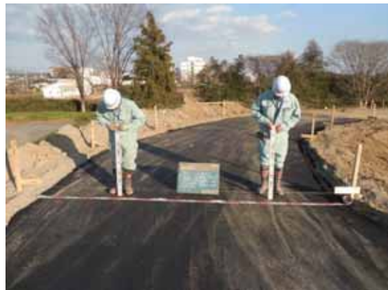
写真-4.2.4-11 下り側スロープの舗装工：延長
