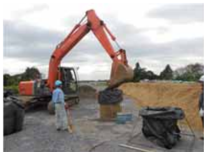
写真-4 大型土のうの製作（円柱形状）
