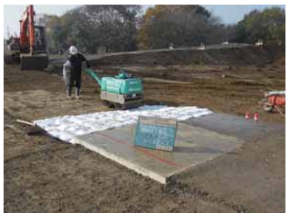
写真-7.1.3-13 土のう(一般)の設置，段差擦り付け状況：応急復旧段階(復旧盛土構築)
