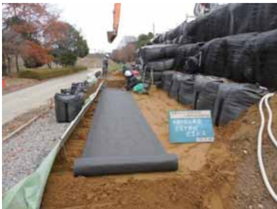
写真-4.2.2-19 壁面材設置及び裏込め材撒出し，敷均し，転圧状況
