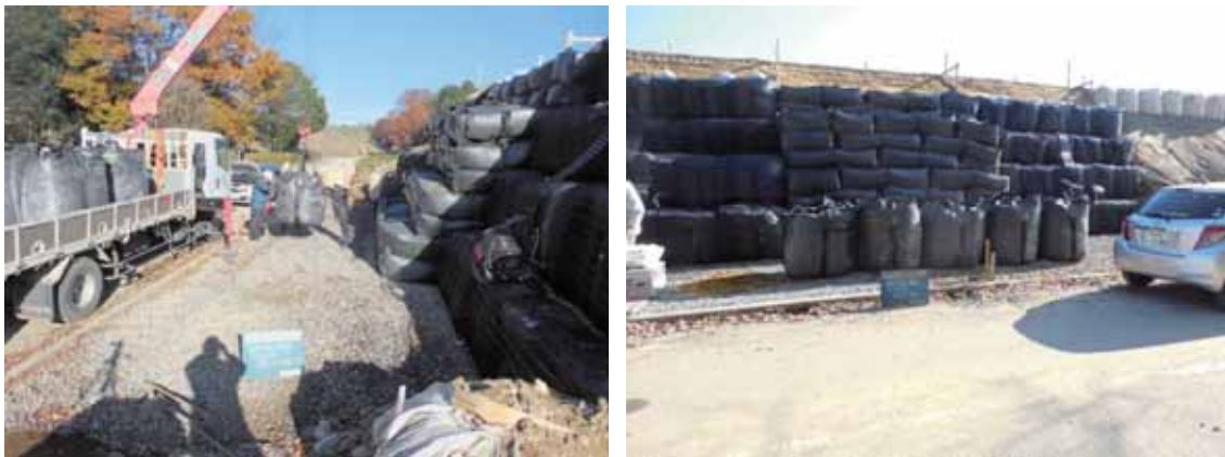
写真-4.2.2-18 大型土のう設置状況(緩衝区間)
