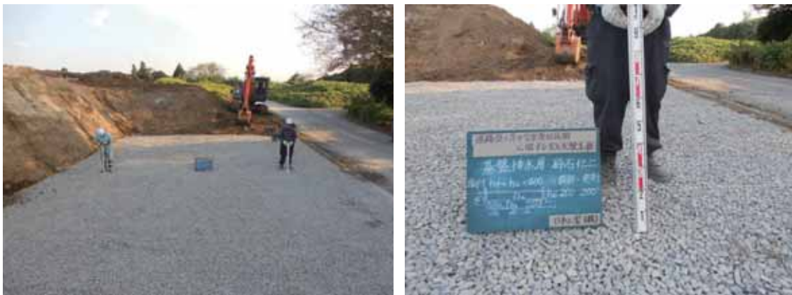
写真-4.1.2-25 基盤排水層仕上がり状況
