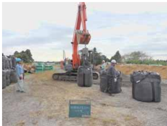
写真-4. 1. 2-27 大型土のう作製手順
