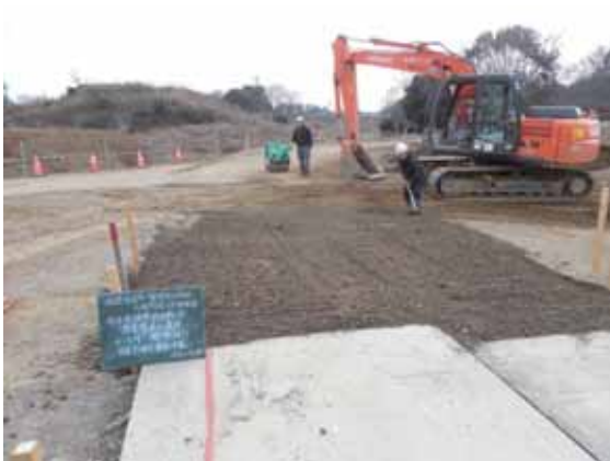
写真-7.1.3-15 ケース3の試験ヤード再構築状況
