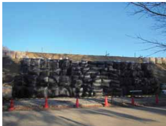
写真-4.2.2-17 上載盛土の構築完了
