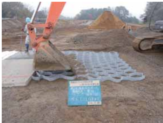
写真-7.1.3-12 格子状補強材Dの設置，段差擦り付け状況
