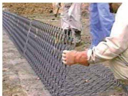
写真-14 壁面材の設置
