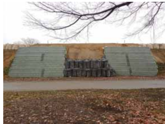
写真-4.2.2-21 本復旧盛土完成
