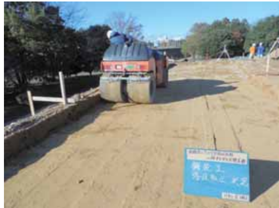
写真-4.2.4-3 路床掘削～転圧状況
