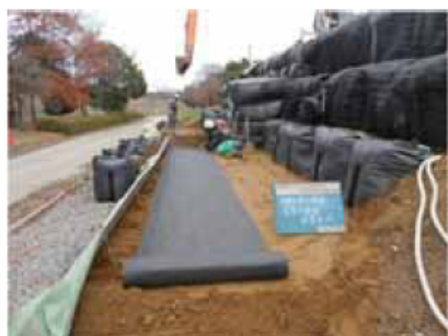
写真-20 層厚管理材の敷設
