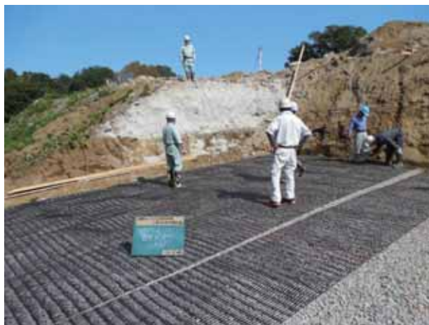
写真-4.3.1-1 補強材の設置状況
