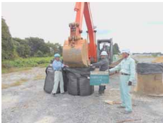
写真-4. 1. 2-27 大型土のう作製手順
