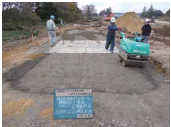
写真-7.1.3-3 格子状補強材 B の設置状況
