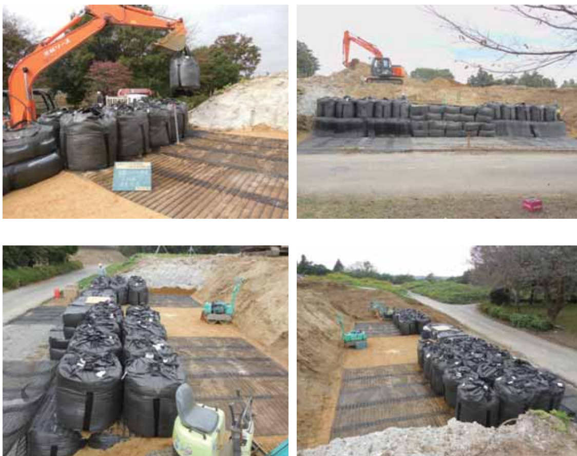
写真-4.2.2-7 2 段目の補強材・大型土のう設置状況
