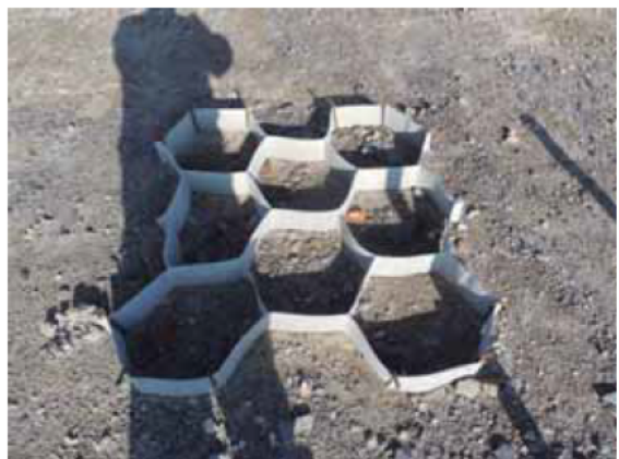
写真-7.1.2-8 格子状補強材C及び格子状補強材D
