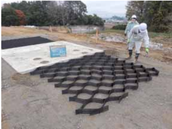
写真-7.1.3-3 格子状補強材 B の設置状況
