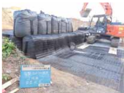
写真-10 大型土のうの設置（2段目）
