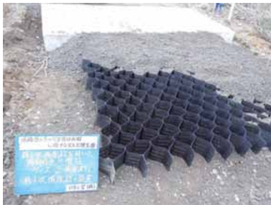
写真-7.1.3-8 格子状補強材 C の設置状況
