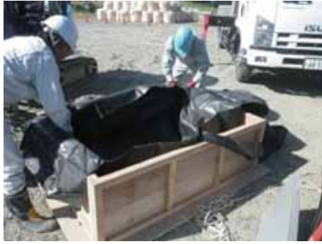
1) 型枠への取り付け
