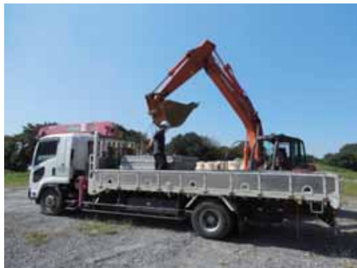
【ユニッククレーン(4tトラック)】
