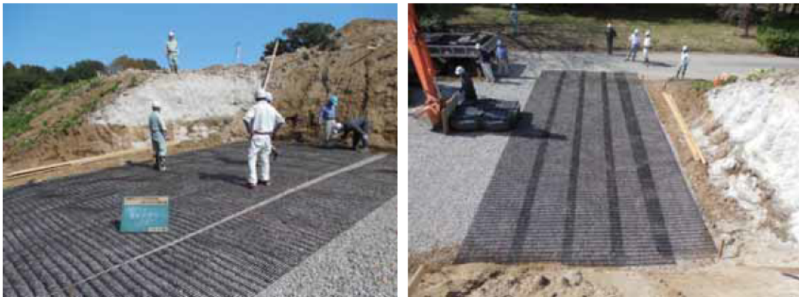
写真-4.2.2-1 試験施工基盤面の補強材設置状況
