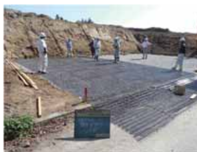
写真-7 敷設（最下層）
