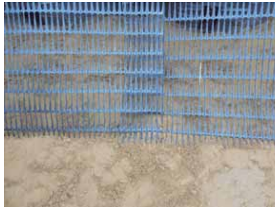
写真-4.2.2-4 補強材設置：大型土のう 1 段目への巻込み
