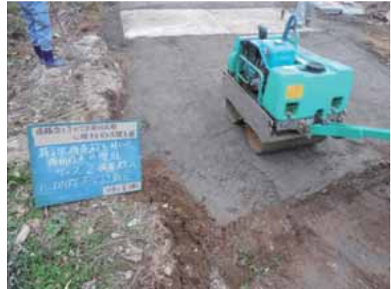
写真-7.1.3-9 段差擦り付け・復旧作業, 転圧状況: 格子状補強材 A
