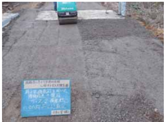
写真-7.1.3-10 段差擦り付け・復旧作業, 転圧状況: 格子状補強材 C
