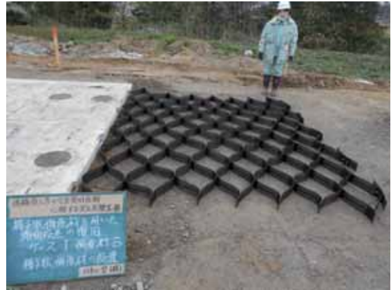
写真-7.1.3-3 格子状補強材 B の設置状況
