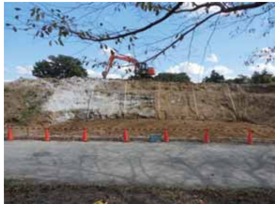
写真-4.2.1-21 既設盛土掘削状況
