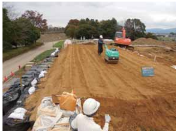
写真-4.2.2-16 上載盛土の構築(撒出し, 敷均し, 転圧状況)
