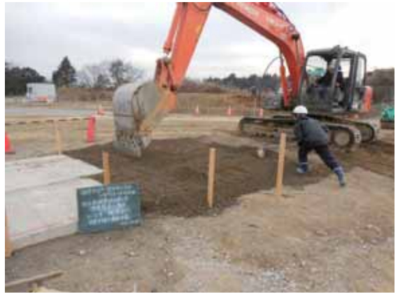
写真-7.1.3-14 土のう損傷状況：応急復旧段階(復旧盛土構築)の走行試験後
