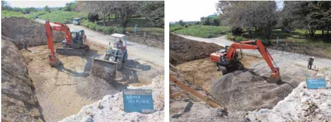
写真-4.1.2-24 基盤排水層造成状況
