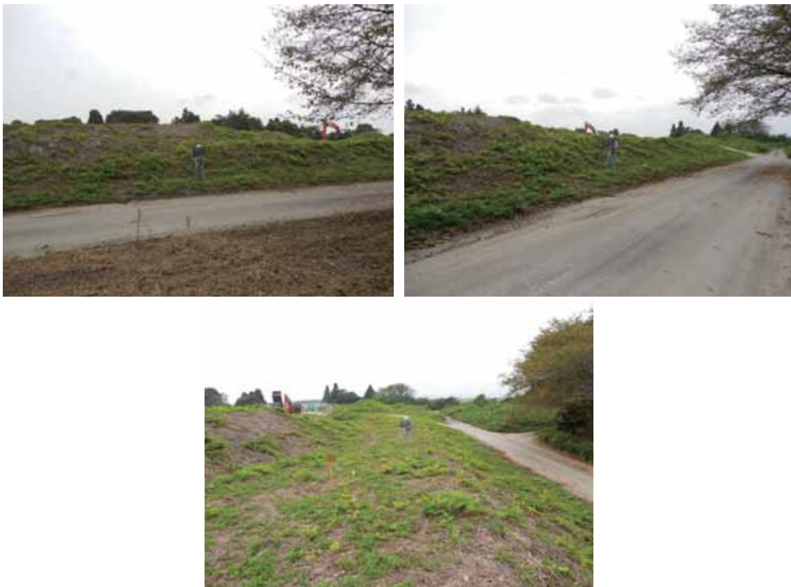
写真-4.2.1-20 本調査着手前現場状況
