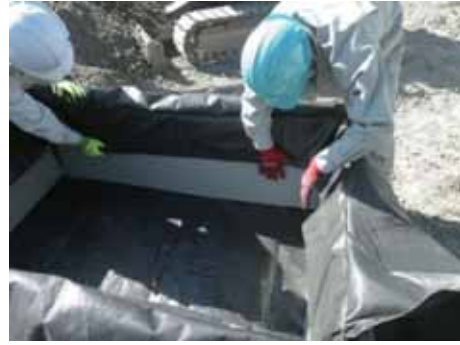
2) プラスチック板の設置
