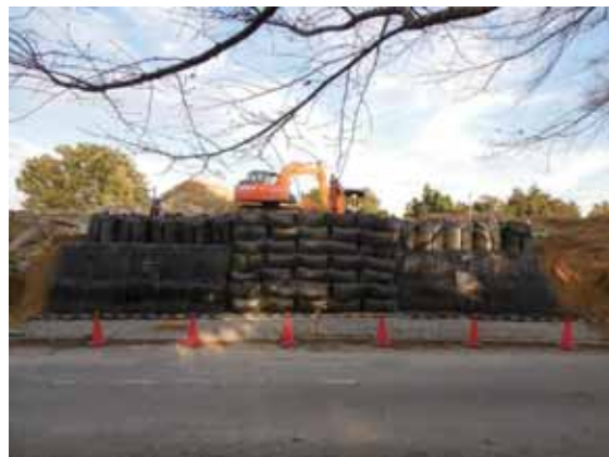
写真-4.2.2-10 3段目の大型土のう設置状況
