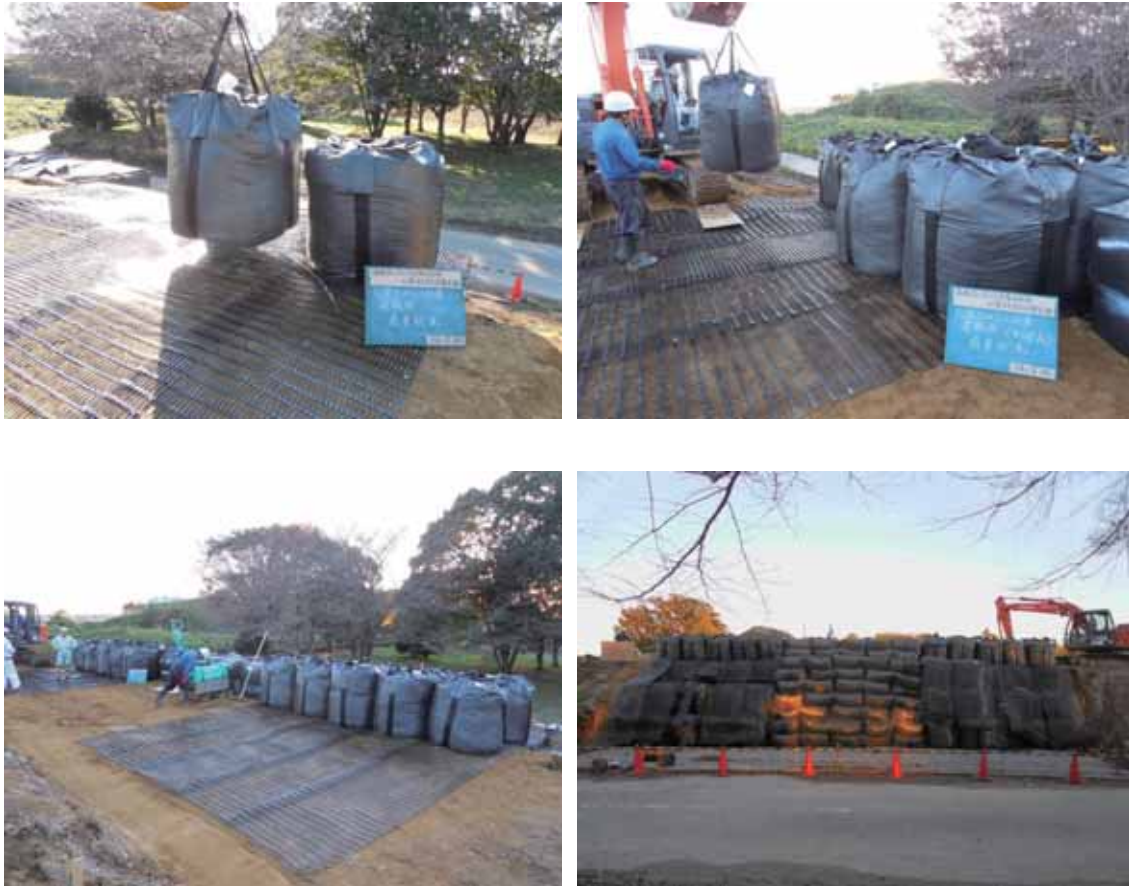
写真-4.2.2-12 4 段目の補強材・大型土のう設置状況
