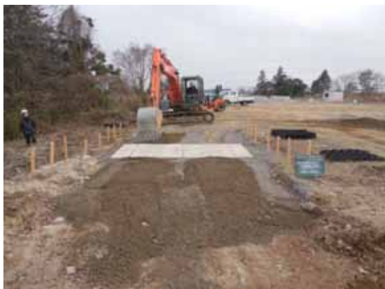
写真-7.1.3-17 ケース2 試験ヤード埋戻し・転圧状況(処置)
