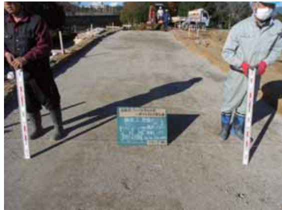
写真-4.2.4-6 路盤仕上がり状況
