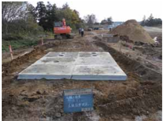
写真-7.1.3-1 路面段差を模倣した地盤の造成と床版の設置状況
