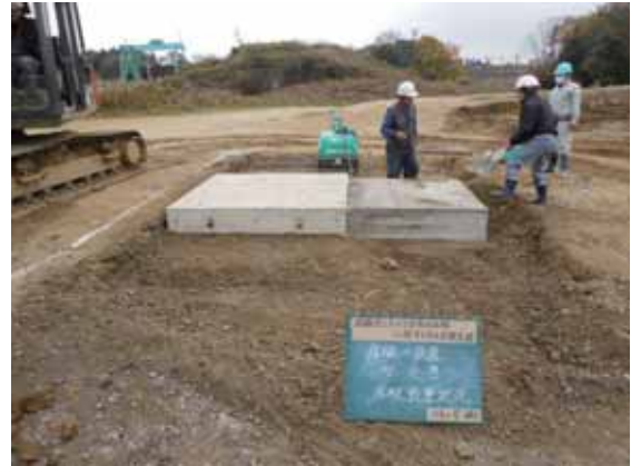
写真-7.1.3-11 路面段差を模倣した地盤の造成と床版の設置状況
