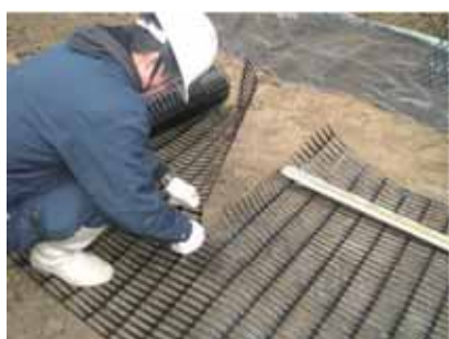
写真-6 ジオテキスタイルの切断
