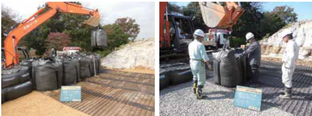
図-4.3.1-2 大型土のう設置概要
