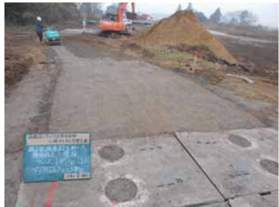
写真-7.1.3-5 段差擦り付け・復旧作業, 転圧状況: 格子状補強材B
