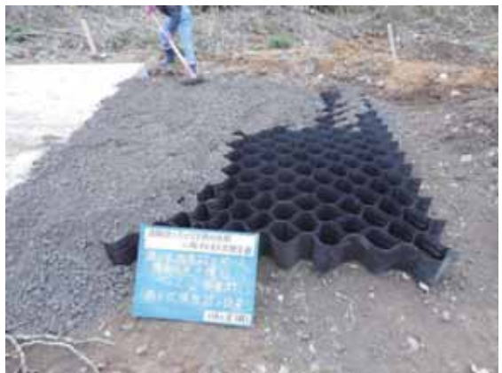
写真-7.1.3-8 格子状補強材 C の設置状況
