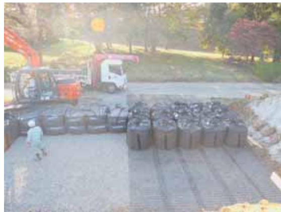
写真-4.2.2-3 1段目大型土のう設置状況：B断面
