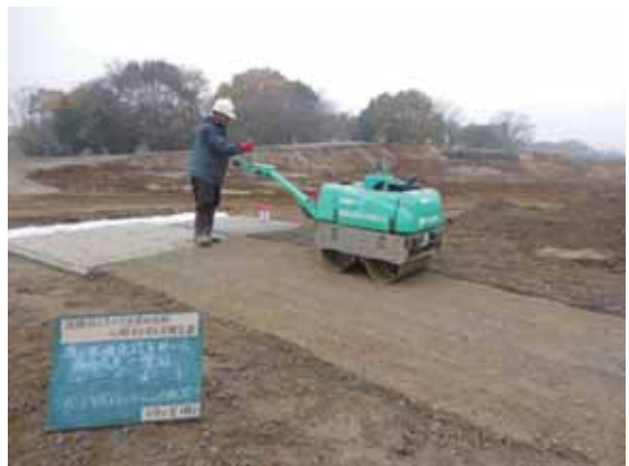
写真-7.1.3-12 格子状補強材Dの設置，段差擦り付け状況
