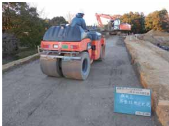
写真-4.2.4-5 路盤工状況
