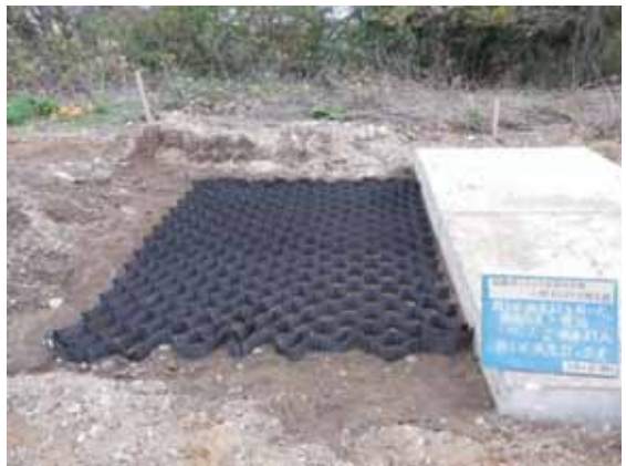
写真-7.1.3-7 格子状補強材 A の設置状況
