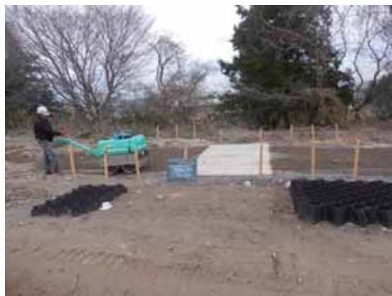
写真-7.1.3-17 ケース2 試験ヤード埋戻し・転圧状況(処置)
