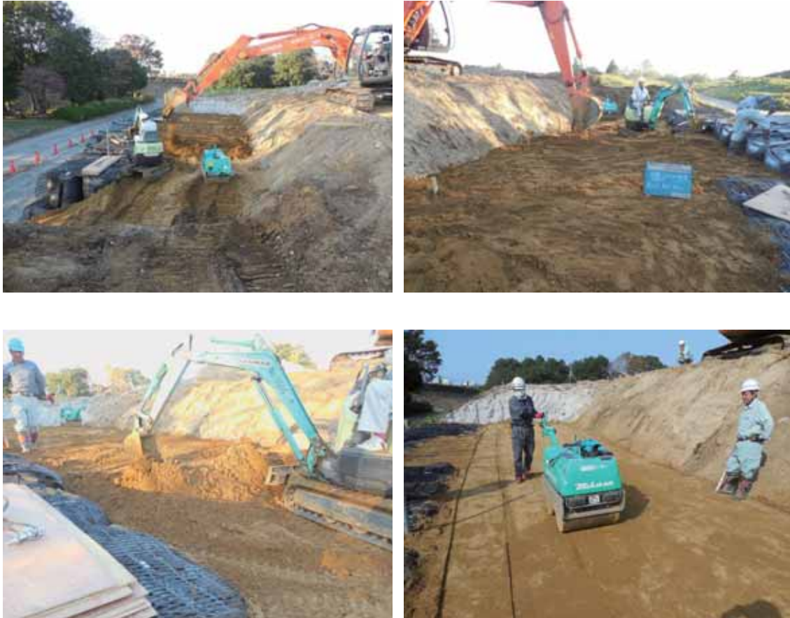
写真-4.2.2-8 2段目大型土のう裏込め材撤出し、敷均し、転圧状況
