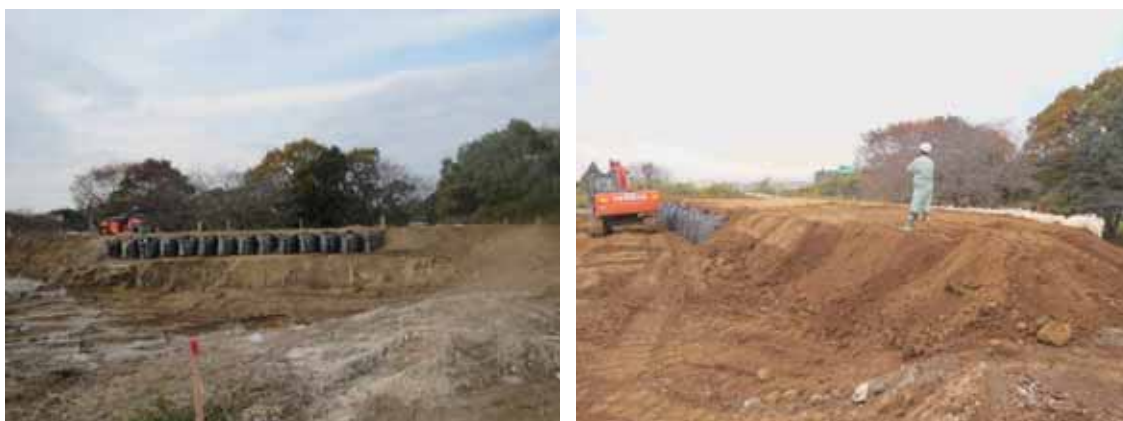
写真-4.2.4-1 走行実験道路周辺部の大型土のう設置状況
