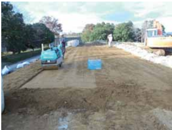
写真-4.2.2-16 上載盛土の構築(撒出し, 敷均し, 転圧状況)
