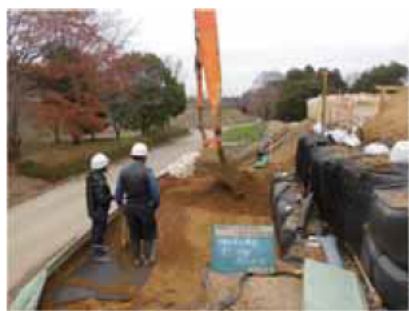
写真-18 盛土材料のまき出し
