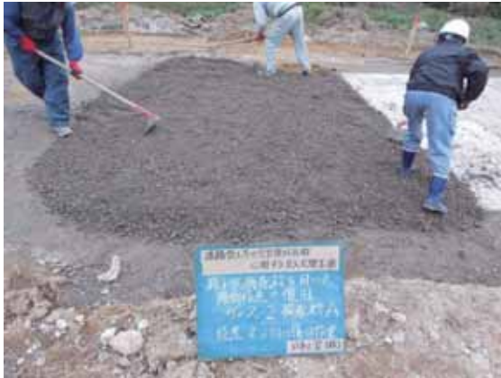
写真-7.1.3-9 段差擦り付け・復旧作業, 転圧状況: 格子状補強材 A
