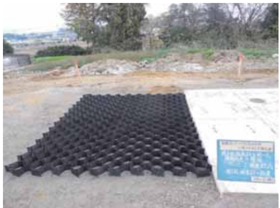
写真-7.1.3-2 格子状補強材 A の設置状況
