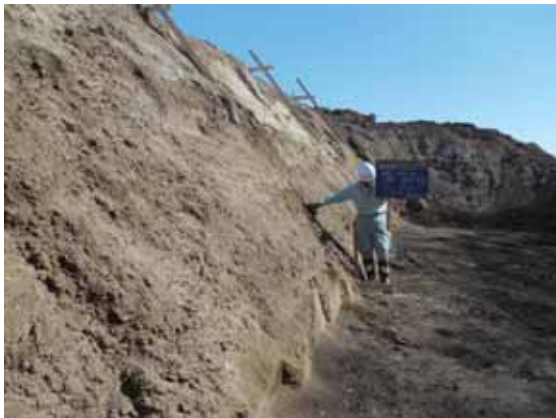
写真-4.2.1-21 既設盛土掘削状況
