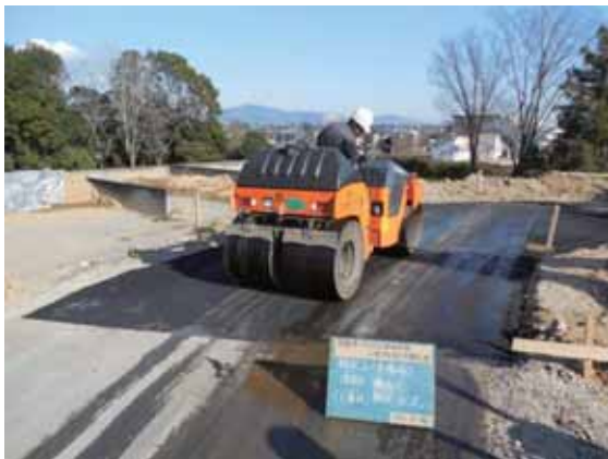
写真-4.2.4-11 下り側スロープの舗装工：延長
