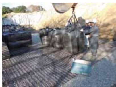
写真-8 大型土のうの設置
