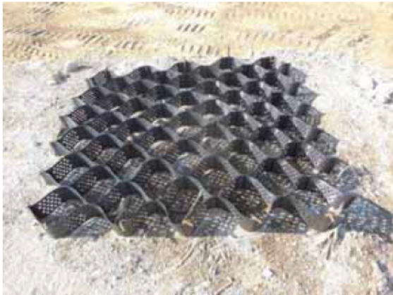
写真-7.1.2-7 格子状補強材A及び格子状補強材B
