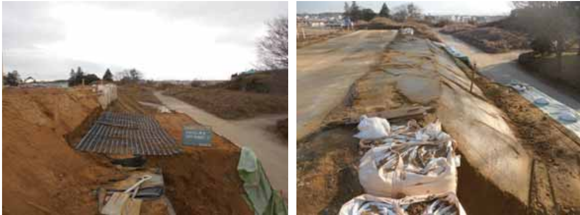
写真-4.2.2-20 上載盛土の構築状況
