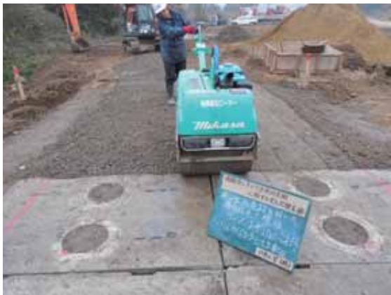
写真-7.1.3-5 段差擦り付け・復旧作業, 転圧状況: 格子状補強材B
