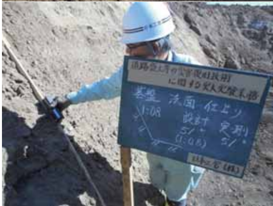
写真-4.2.1-22 背面既設盛土の切土法面状況
