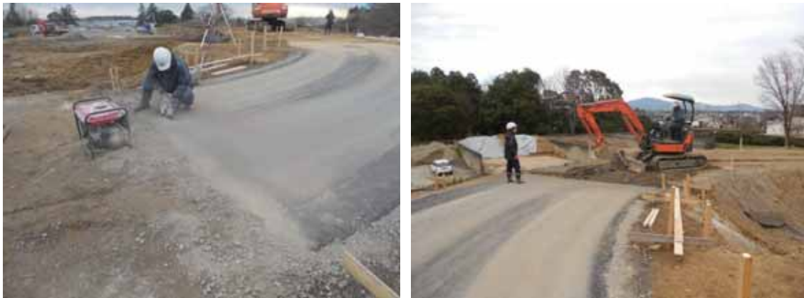
写真-4.2.4-10 舗装区間の擦り付け状況
