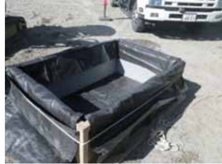
4) 型枠への設置
