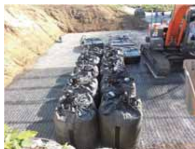
写真-9 大型土のうの配列
