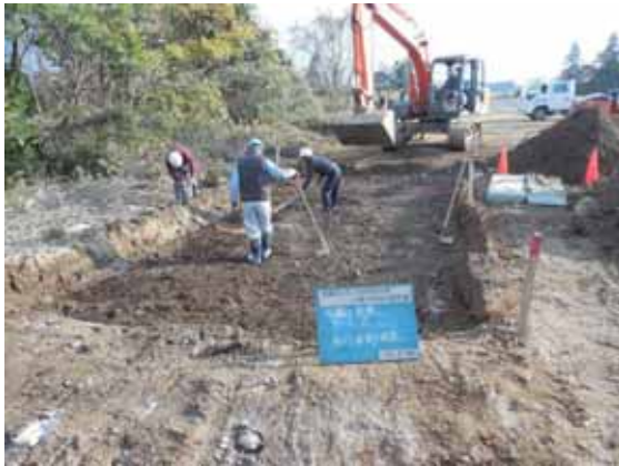
写真-7.1.3-6 路面段差を模倣した地盤の造成と床版の設置状況
