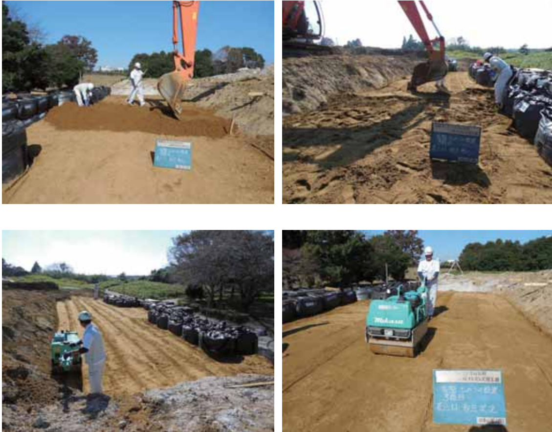
写真-4.2.2-11 3段目大型土のう裏込め材撤出し、敷均し、転圧状況
