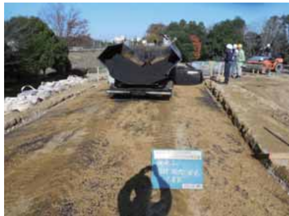
写真-4.2.4-6 路盤仕上がり状況
