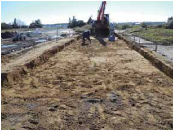
写真-4.2.4-3 路床掘削～転圧状況
