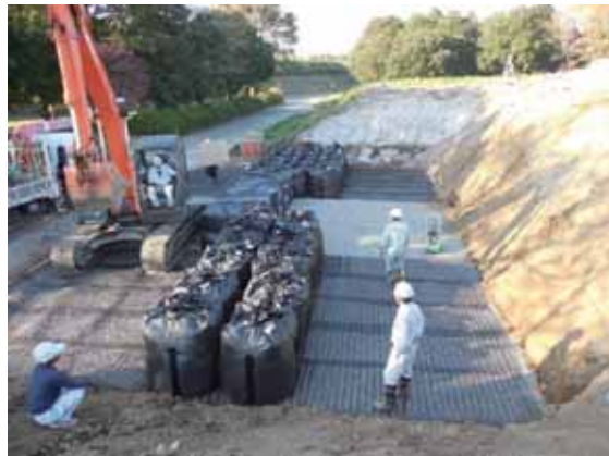
写真-4.2.2-2 1 段目大型土のう設置状況 : A 断面
