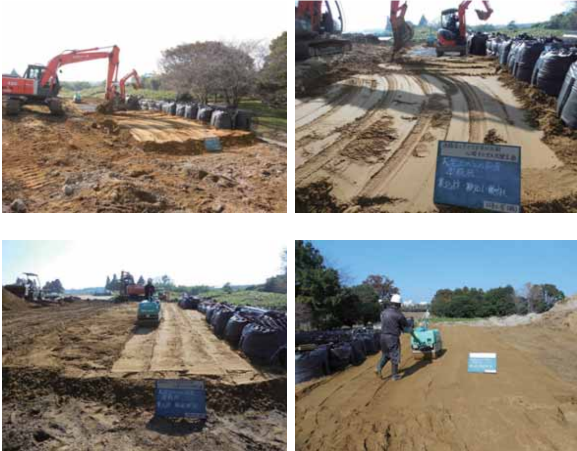
写真-4.2.2-13 4段目大型土のう裏込め材撤出し、敷均し、転圧状況
