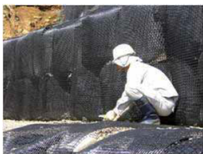
写真-16 ジオテキスタイルの切断
