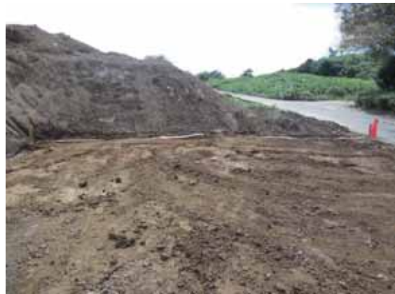
写真-4. 2. 1-23 基盤面成形完了後状況
