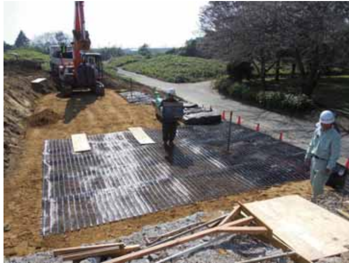
写真-4. 2. 2-9 大型土のう 3 段目補強材設置状況
