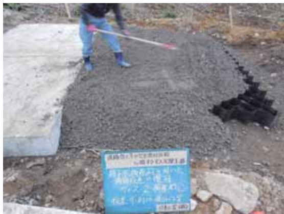
写真-7.1.3-10 段差擦り付け・復旧作業, 転圧状況: 格子状補強材 C
