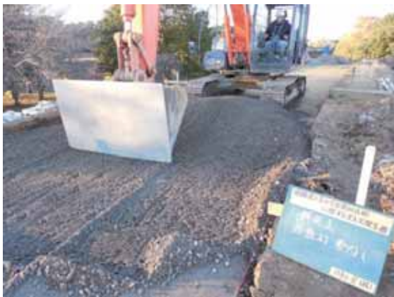
写真-4.2.4-5 路盤工状況
