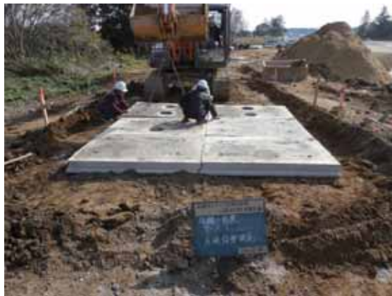
写真-7.1.3-1 路面段差を模倣した地盤の造成と床版の設置状況
