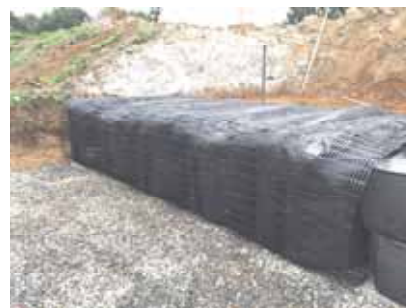
写真-11 ジオテキスタイルの巻き上げ
