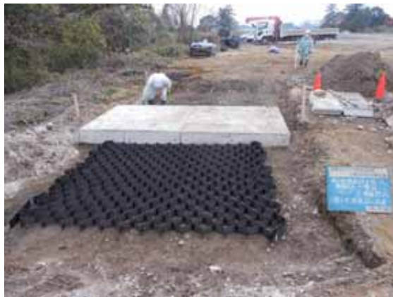
写真-7.1.3-7 格子状補強材 A の設置状況
