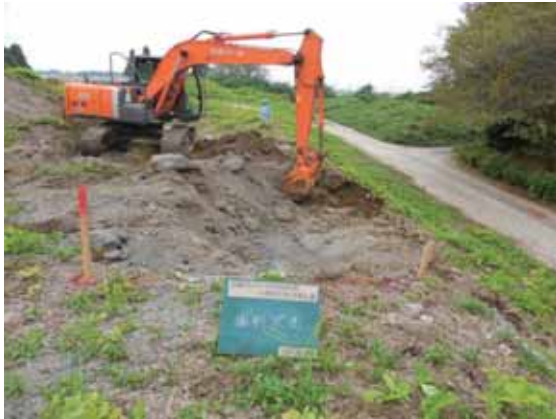
写真-4.2.1-21 既設盛土掘削状況
