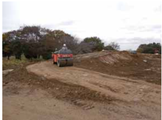
写真-4. 2. 4-2 走行実験道路整備状況
