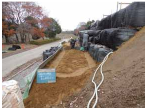
写真-4.2.2-19 壁面材設置及び裏込め材撒出し，敷均し，転圧状況
