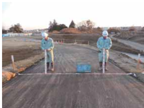
写真-4.2.4-12 上り側スロープの舗装工：延長
