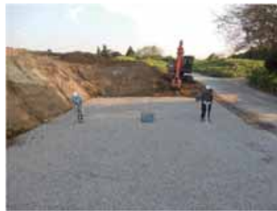
写真-3 基盤排水層
