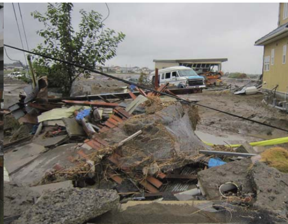
写真-B.9 破堤地点近くの様子
