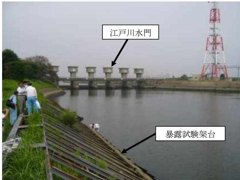
写真 3.3.1 江戸川水門下流の暴露試験場および試験架台外観
