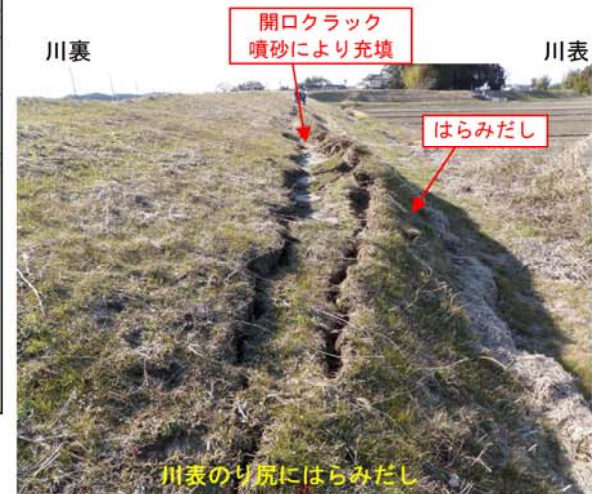
被災状況のスケッチ（関東地整資料）に加筆
