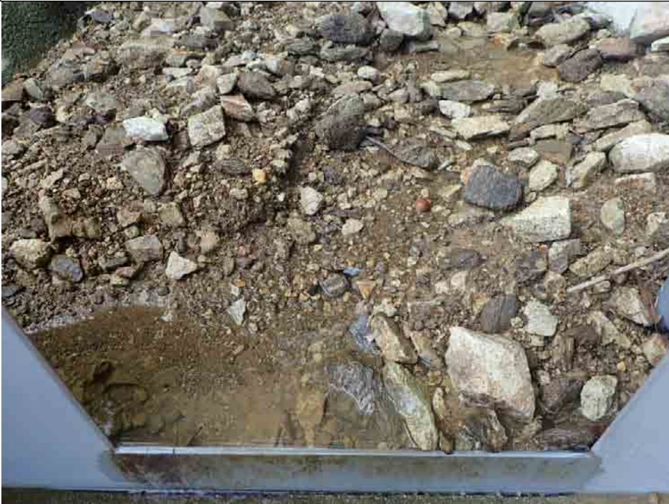
写真 4.1.2 流域下流部における流出土砂の堆積状況（流量堰地点）
