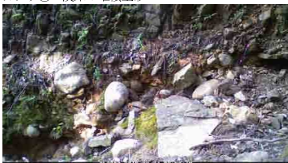
カメラ⑨ 溪床の堆積土砂
