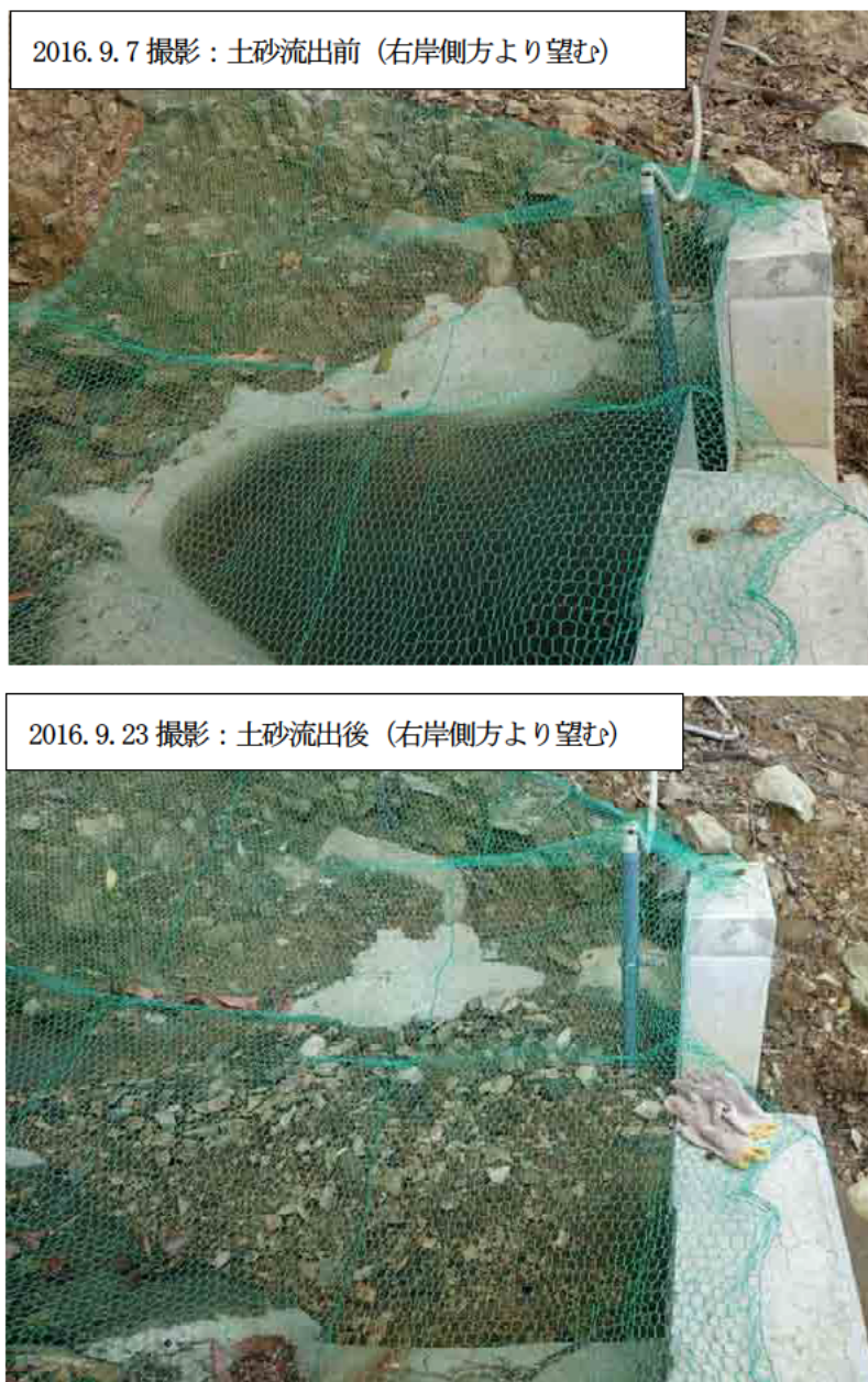
写真 4.1.1 流域下流部における土砂流出前後の状況（流量堰地点）
