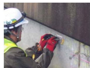
図-6 超音波による調査状況
