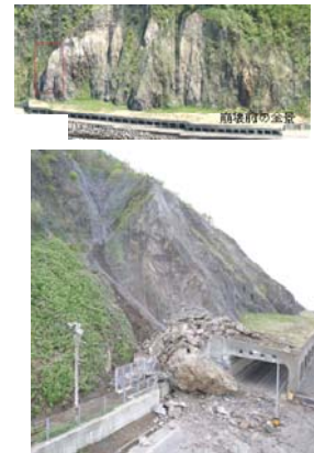
図-15 崩壊機構が不適切な事例 (大規模な岩盤崩壊は想定外)
