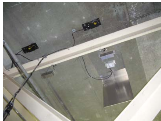
写真1 床版下面へのセンサ設置状況
