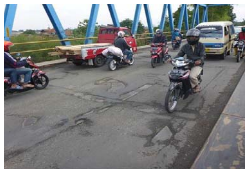
図-7 鋼床版舗装が予定されている橋梁
