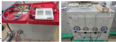
(A)Torrent法 (B)SWAT法 写真-1 非破壊試験の実施状況
