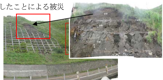
図-11 もともと不安定な土砂・岩盤が不安定化（法枠施工範囲が不足していた）
