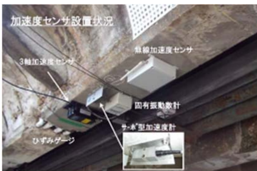
図2 センサ設置状況
