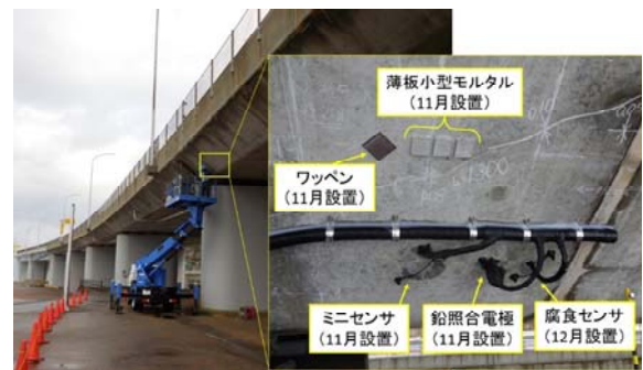
写真4 現場適用状況の例 (塩害環境のモニタリング)
