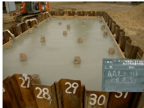
(上載コンクリート打設状況)
