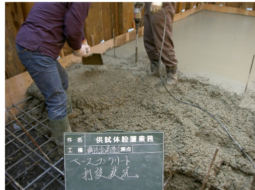
(コンクリート打設)
