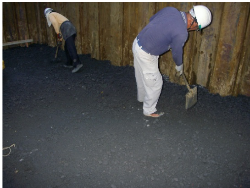
(碎石敷き均し)
