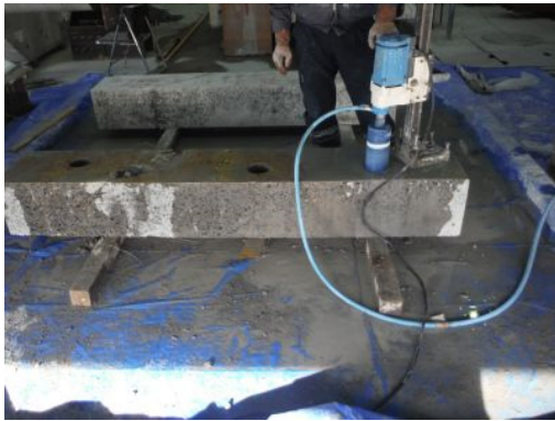
(コアドリルによる削孔状況)
