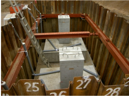
(供試体設置状況)
