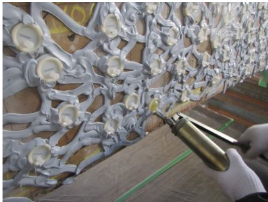
(注入材の注入状況)
