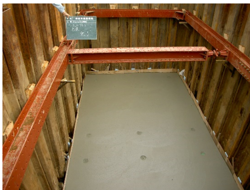
(供試体設置基盤完成)
