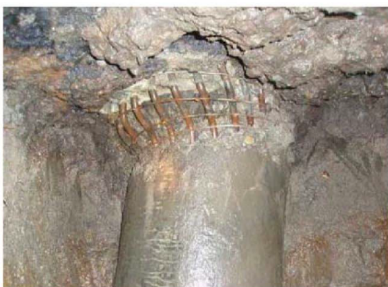
(a) A2 橋台下流側の杭の状況
