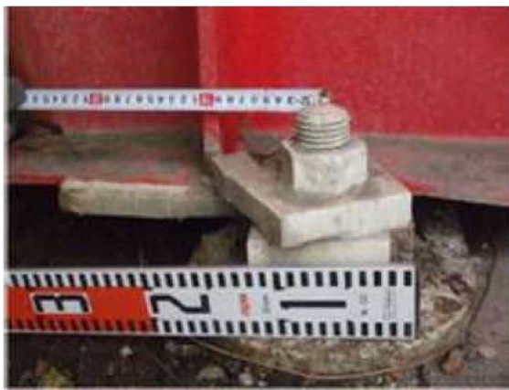
写真-4.2.16.4 A1 橋台部 G3 可動支承ピンチ プレートの移動 (資料提供：宮城県)
