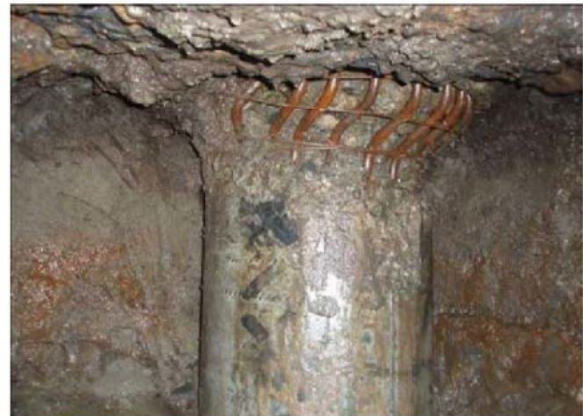
(b) A2 橋台上流側の杭の状況
