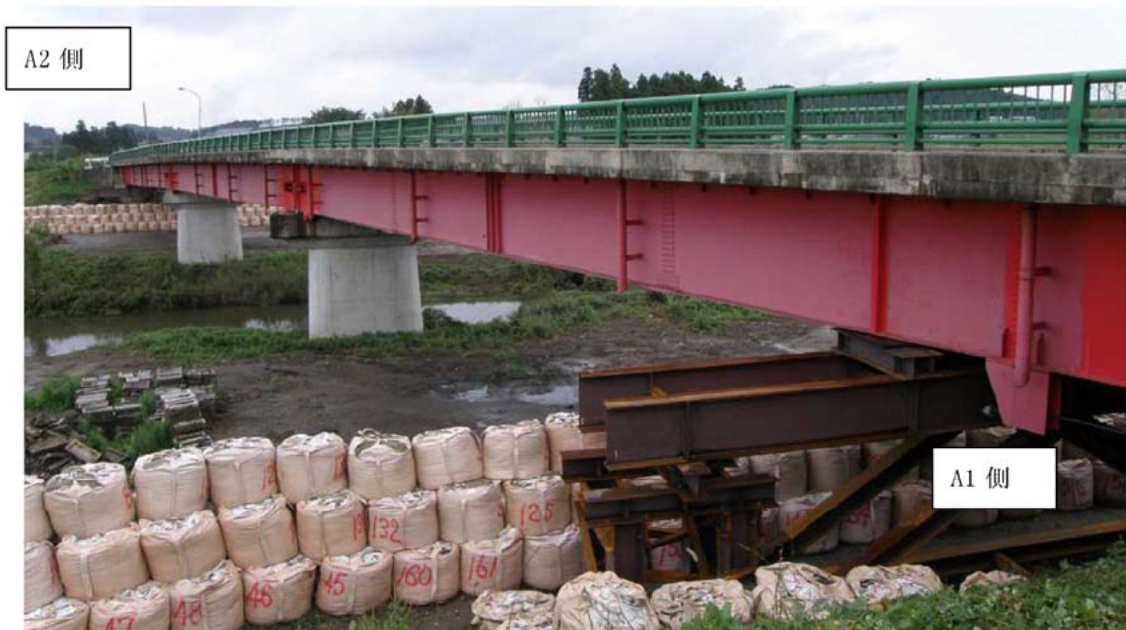
写真-4.2.16.1 西川橋(平成 24 年 10 月撮影)
