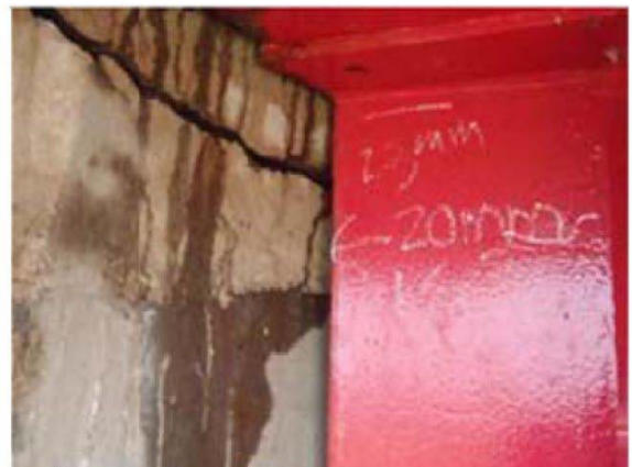
写真-4.2.16.3 A1 橋台部パラペット上部の クラック (資料提供：宮城県)
