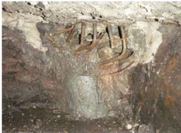
(a) A1 橋台下流側
