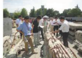
橋の撤去部材見学会(腐食による腐食状況)
