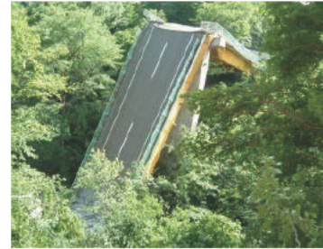
地震による落橋
