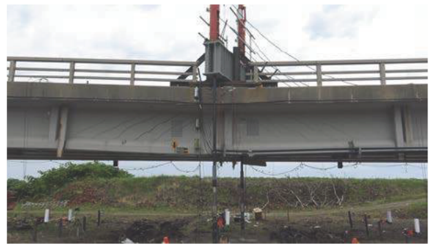
写真-3.1.2 撤去予定橋梁の破壊までの現地载荷試験
