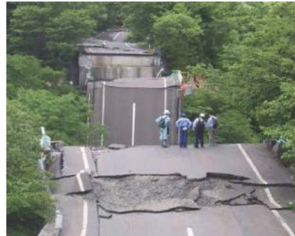
写真-2.2.2 岩手・宮城内陸地震における道路橋の被災調査
