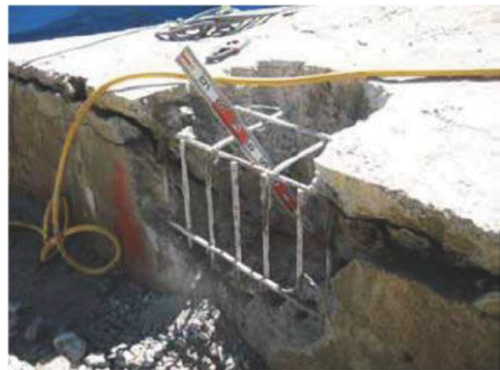
写真-3.3.6 フーチングのASRによる鉄筋破断事例 （出典：土木研究所資料第4034号）
