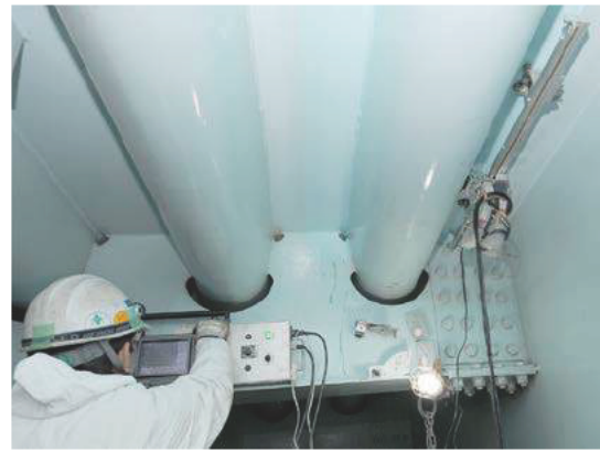
写真-3.3.2 超音波探傷による鋼床版デッキプレートの疲労き裂の調査方法の開発
