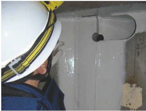
写真 -2.1.1 劣化した道路橋の現地調査
