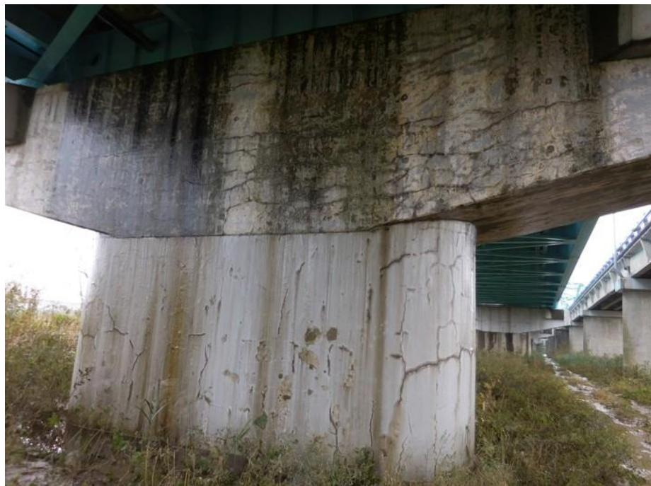
写真-2.1.3 ASR により損傷した橋脚
