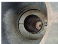
図-16 二重構造の排気管の例
