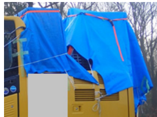
図-A.2.5 ブルーシートによる防水対策.
