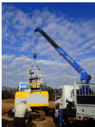
図-A.2.9 クレーンでの機器の設置作業.
