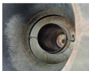
図-2.7 二重構造の排気管の例.
