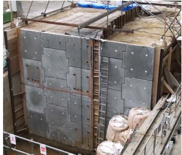
写真-1 補強土実大模型
