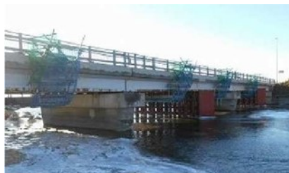
写真-1 橋梁全景
