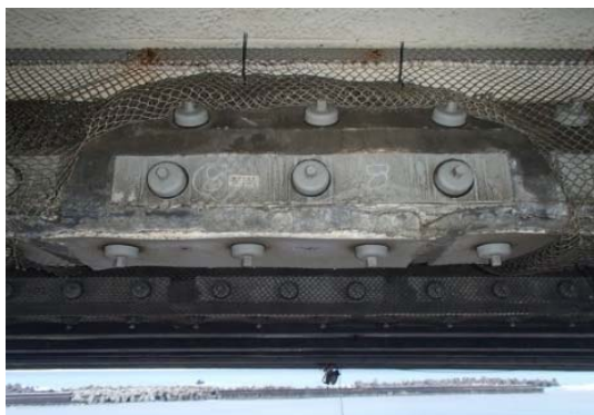
図4 亜鉛シート設置状況
