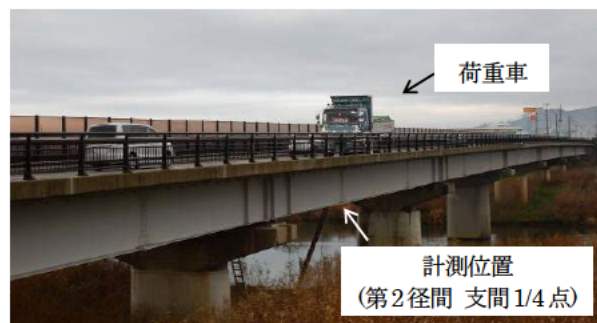
写-2 走行載荷試験状況
