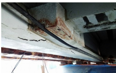
写真-2 外ケーブル設置状況
