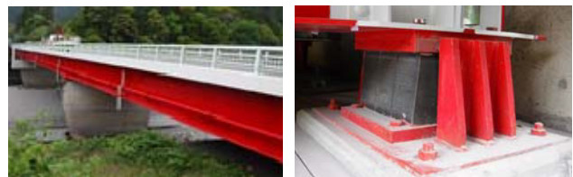
(a) 全景 (b) 支承部
