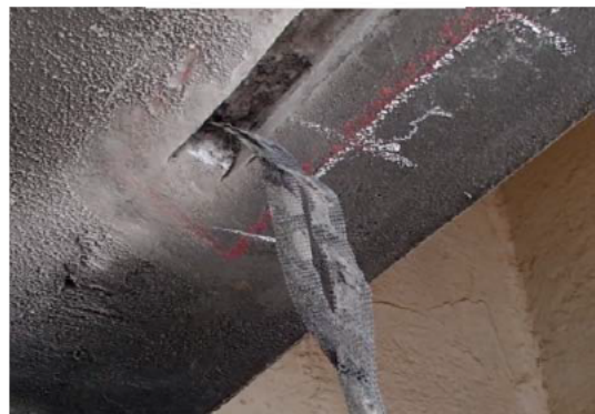
図 3 はつり調査状況
