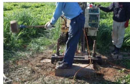
写真1 PS 検層 S 波起振状況
