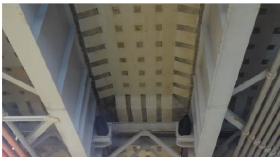
写-1 対象橋梁床版下面補強状況 (格子貼り)
