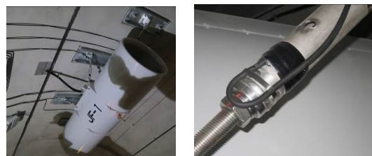
写真-1 軸力計測状況
