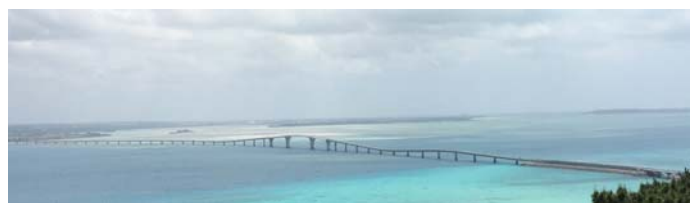
図-2 伊良部大橋全景写真
