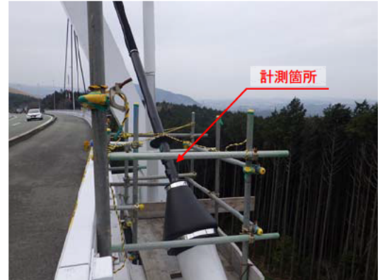
写真1 実橋ケーブル計測状況 (CA8-G1)
