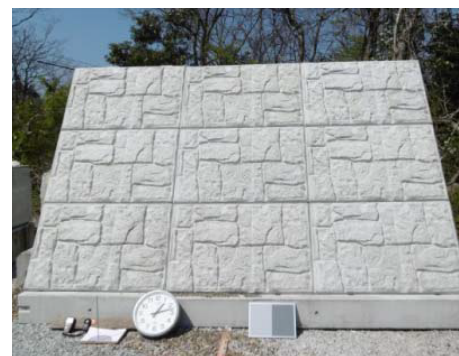
図 6. 判断に迷う護岸ブロック例(2)
