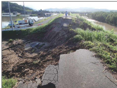
写真-1 小田川の浸透滑りの痕跡
