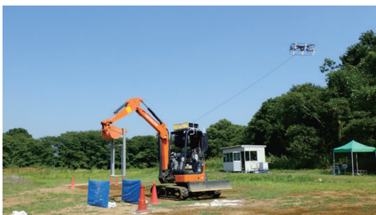
図-4 UAVによる機体・周辺把握の実験の様子
