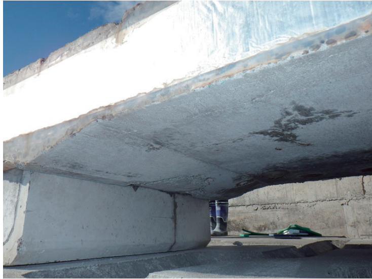
図-2.7 暴露供試体の設置状況（近接）
