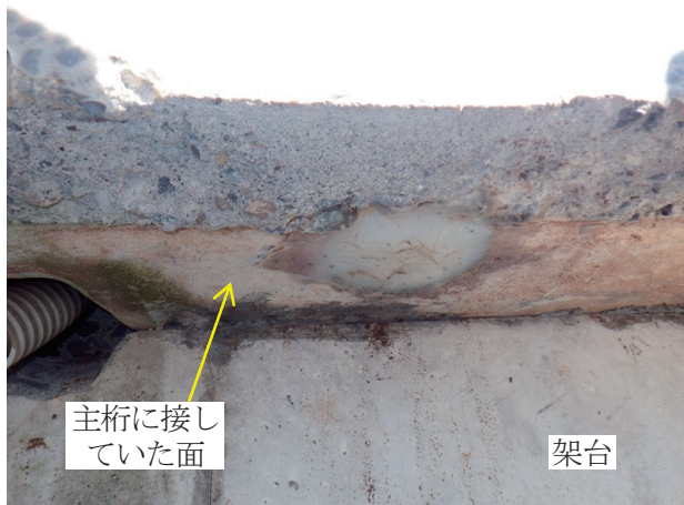
(a) 削孔後，シリコンで埋めた跡
