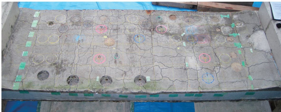
(a) 床版下面の状況 (天地反転したところ)
