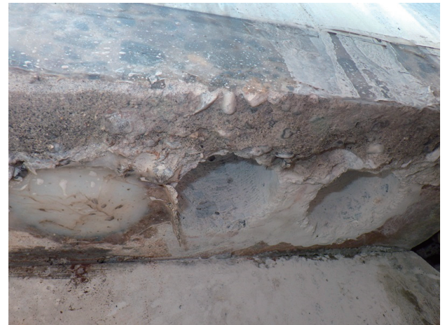
(b) 暴露3年目のコア削孔後，埋める前
