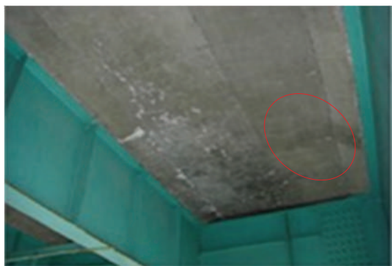
5年前の定期点検時
