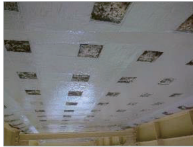
写真-2. 床版下面(炭素繊維貼り付け)
