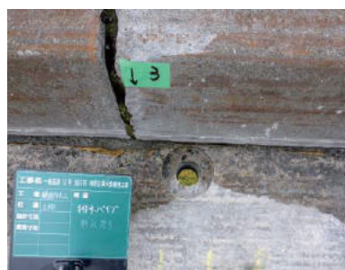
写真-12 水抜きパイプの追加設置
