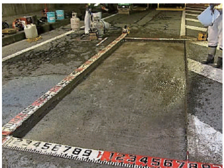
写真-2. 上面は調整コンクリート。浮き等なく健全。ただし湿潤状態。
