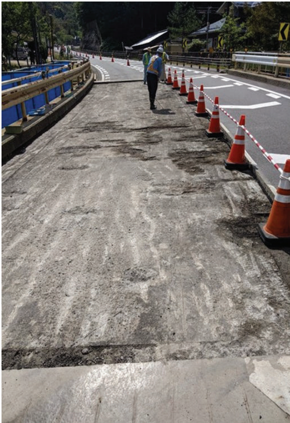
舗装打ち継ぎ部(カウント値669) 地覆端部(カウント値614) 健全部(カウント値139)
