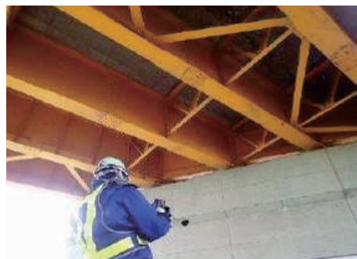
写真-1 降雨後の床版下面目視調査
