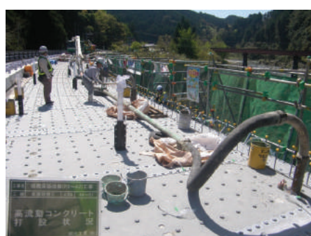
(高流動コンクリート打設状況)
