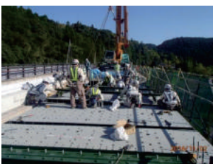
写真-8 床版設置
