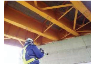
（降雨後の床版下面目視調査）
