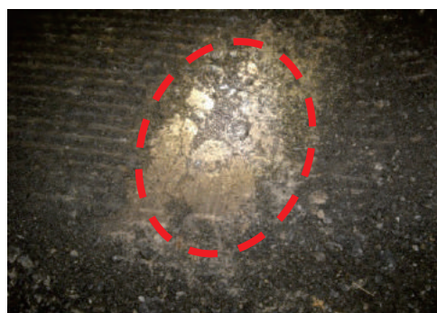
(a) 舗装を剥がした状況 1)
