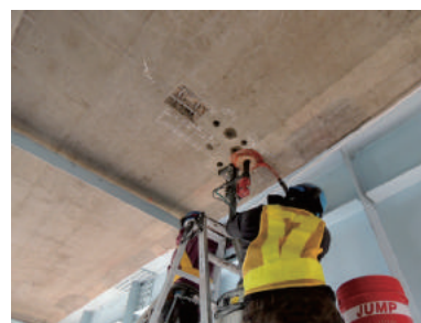
写真-6 コア削孔
