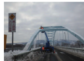
橋梁の雪底処理
