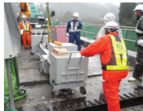
(ジャッキアップ・撤去状況)
