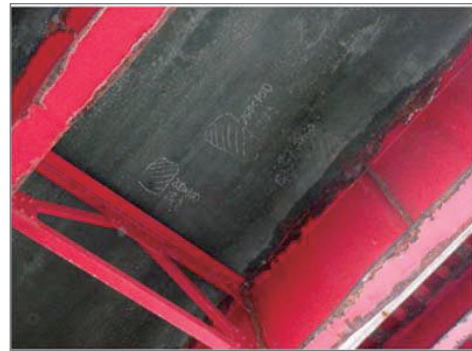
写真-3. 床版下面はH18年に全面炭素繊維貼り付け（床版は確認不可）
