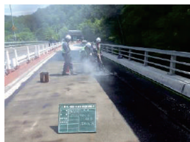
写真-14 塗膜系防水施工
