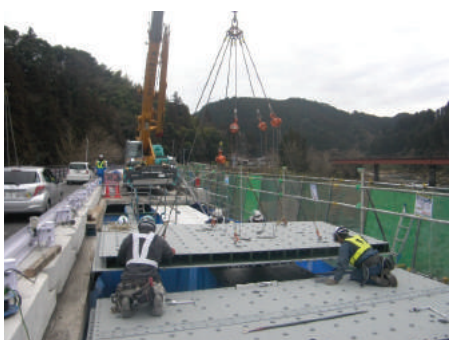
(パネル設置状況)
