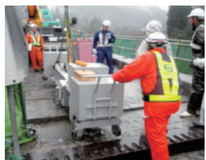
写真-7 既設床版の撤去
