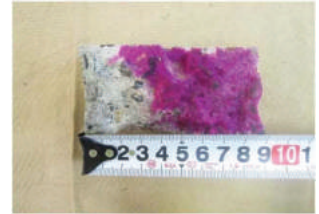
（中性化深さ試験）
