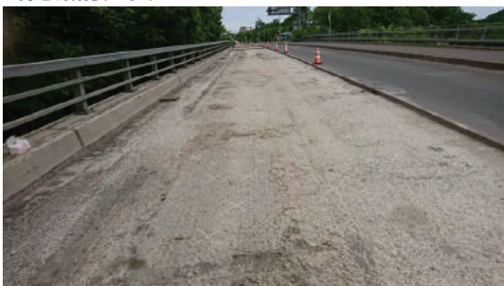
現地切削後の状況
