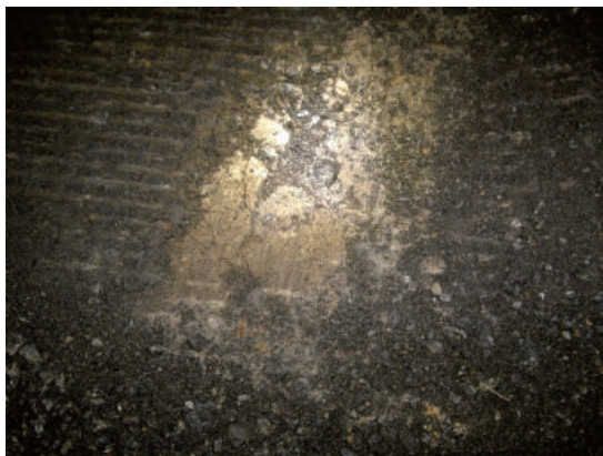
(a) 舗装を剥がしたところ
