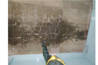
床版下面の詳細近接目視・打音(漏水、角落ち等確認)、車両通行時のひび割れ挙動の確認。
