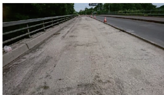
写真-9 現地切削後の状況
