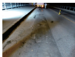
写真-3 舗装補修跡
