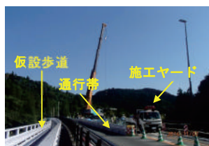
写真-6 工事状況(全体)
