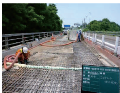
写真-11 WJはつり状況
