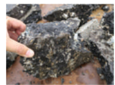
はつり取った舗装(防水層なし)
