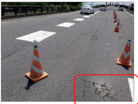
写真-1. 路面As舗装
