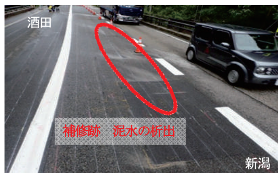
写真-1 舗装撤去前
