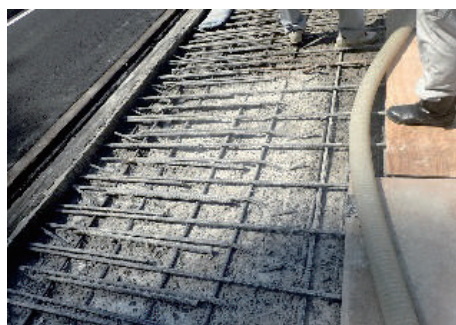
写真-3 ウォータージェットによるはつり作業
