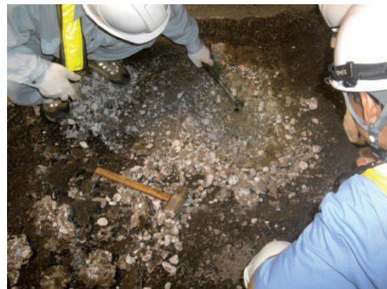
(b) 図 a のコンクリート部を工具で掘るところ
