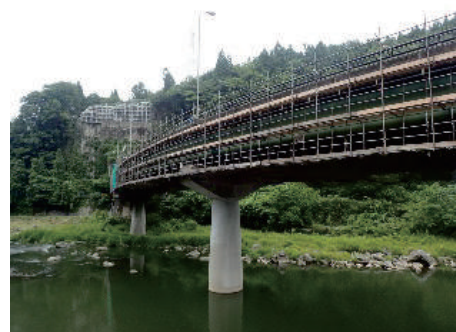
写真-4 大規模な仮設足場の設置事例
