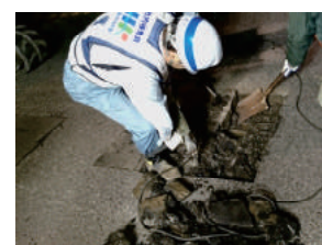
写真-4 開削による確認
