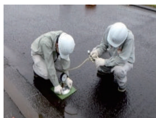
写真-8 水密性確認状況
