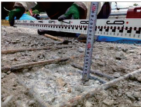
写真-2. 土砂化は上面鉄筋まで達する
