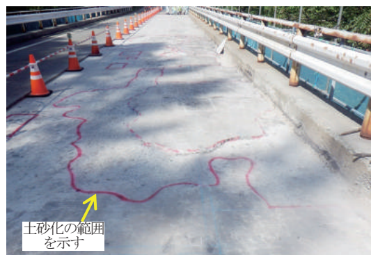
(a) 舗装を剥がして清掃したところ
