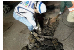
開削による確認
