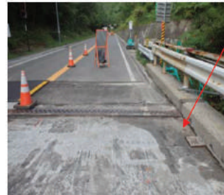
伸縮装置周辺の床版土砂化
