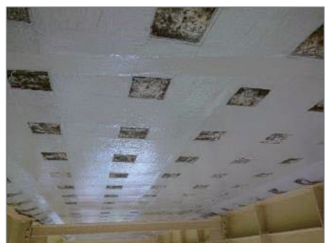
写真-2. 床版下面は炭素繊維貼り付け。観察窓からひび割れと白い析出物。
