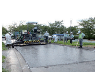
写真-5 開発グース施工状況
