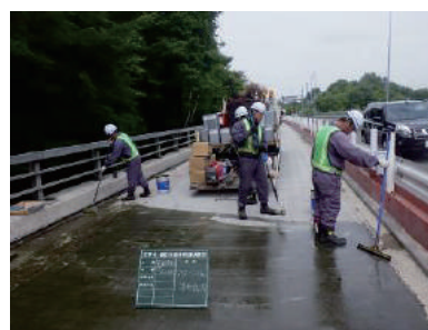
写真-13 浸透系防水施工
