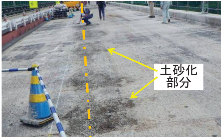
舗装全面をはがした状態
