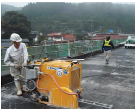
(カッター切断状況)
