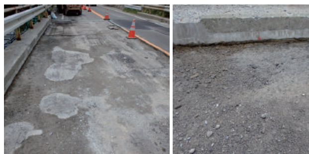
写真-5 舗装撤去後の床版状況（治部坂橋）
