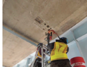
コンクリートコア削孔
