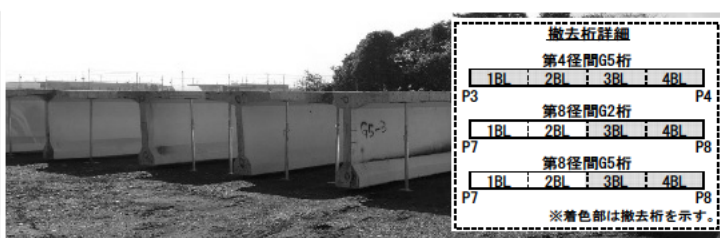
写真-2 撤去桁
