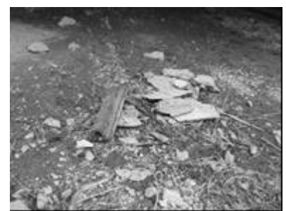
(b) 落下したコンクリート片
