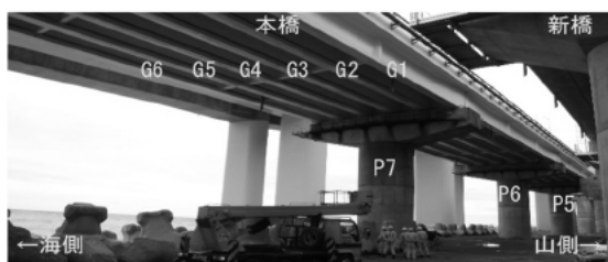
写真-1 橋梁外観（写真は第6~8径間）
