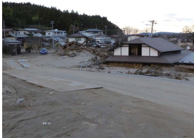
宮城県丸森町で発生した土砂・洪水氾濫の状況
