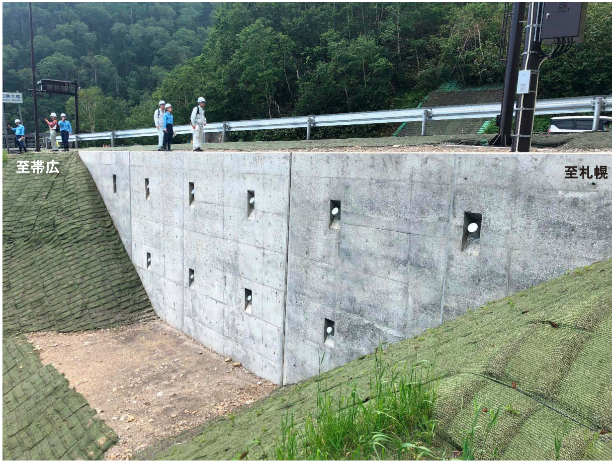
図13 アンカー付き山留式擁壁による盛土の復旧
