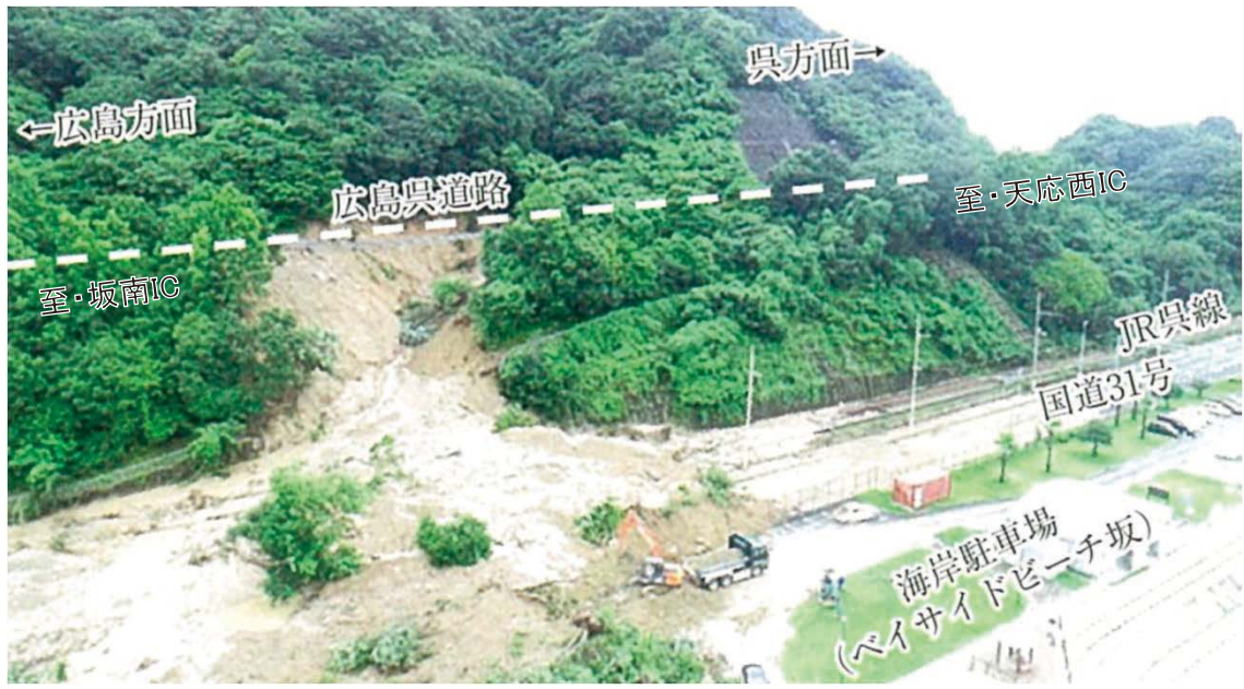
図3 道路盛土及び周辺の被害状況 b)に加筆
