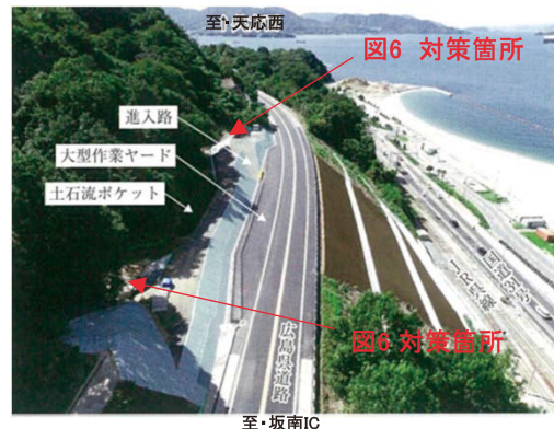
図11 盛土完成状況 b)に加筆
