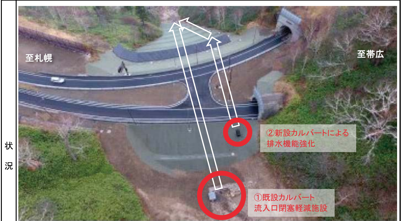
図6 カルバート流入口の簡易な閉塞対策の全体 b) に加筆
