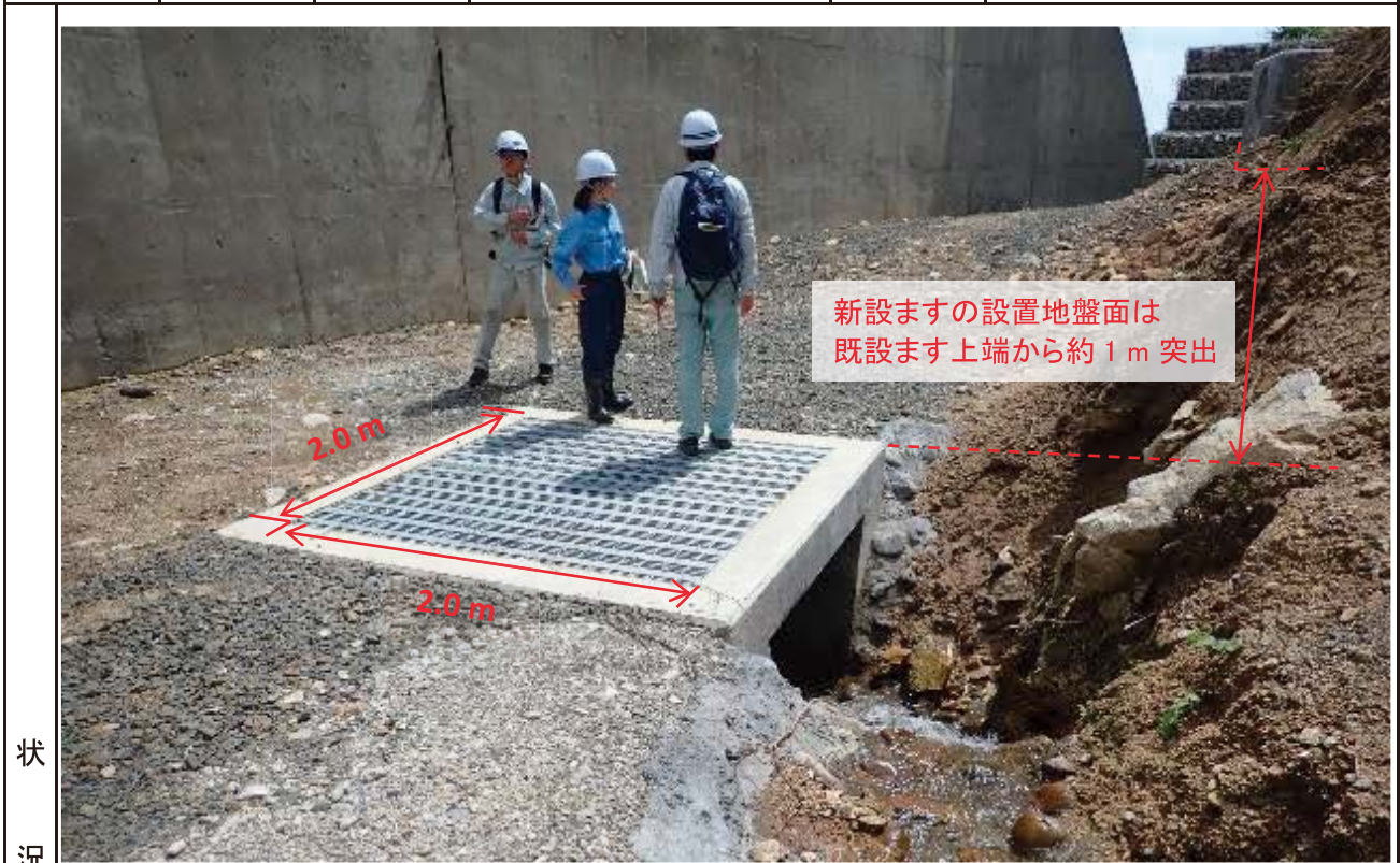
図8 既設ますの補修後の状況
