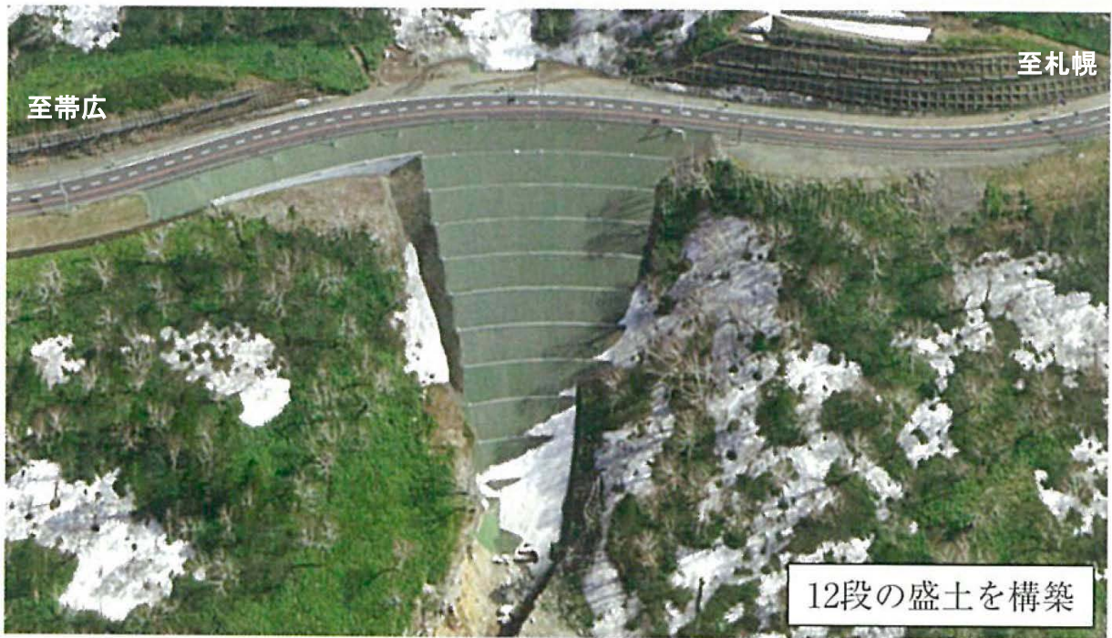
図9 崩壊箇所③の盛土復旧状況 o)
