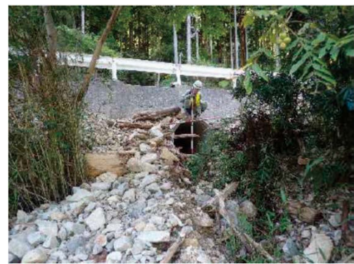
④ カルバート流出口
