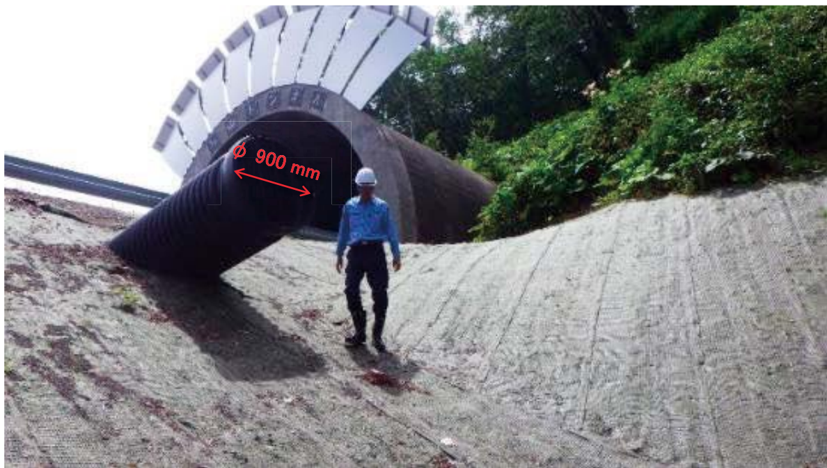
図8 新設カルバート流入口の状況
