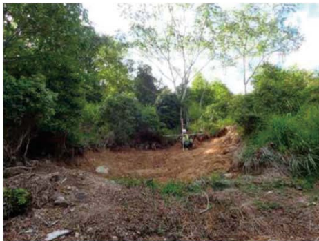
図4 崩壊箇所(土石流源頭部)の状況
