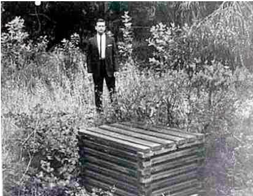
図2-11 盛土脇空間（位置不明）に設置された赤杉による Crib 2)
