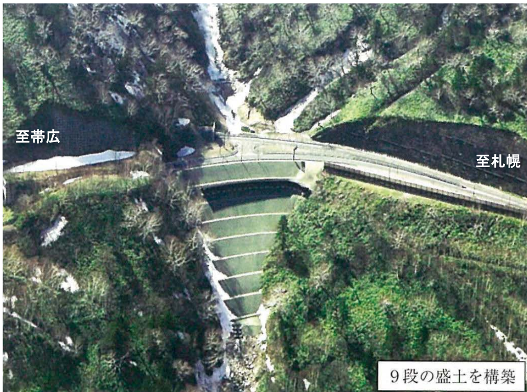
図9 盛土の復旧状況 c)
