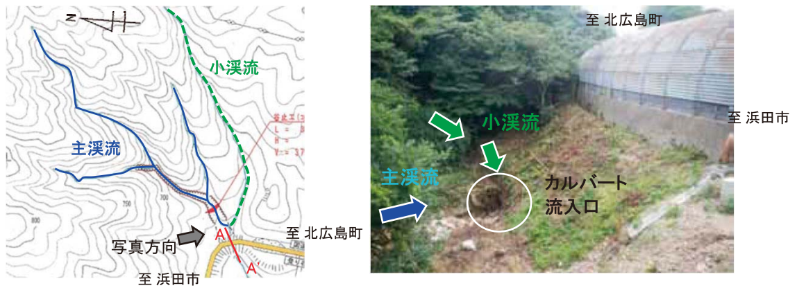
図4 カルバート流入口への溪流流入状況
