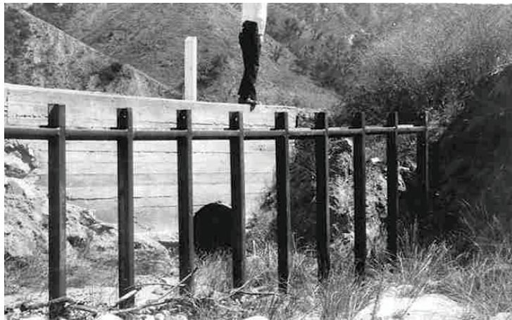
図2-5 鉄レールによる Rack (縦スリットの間隔は図2-4より大きく、0.6~0.9m) 2)
