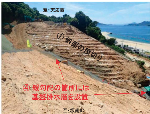
図10 盛土施工状況 d)に加筆
