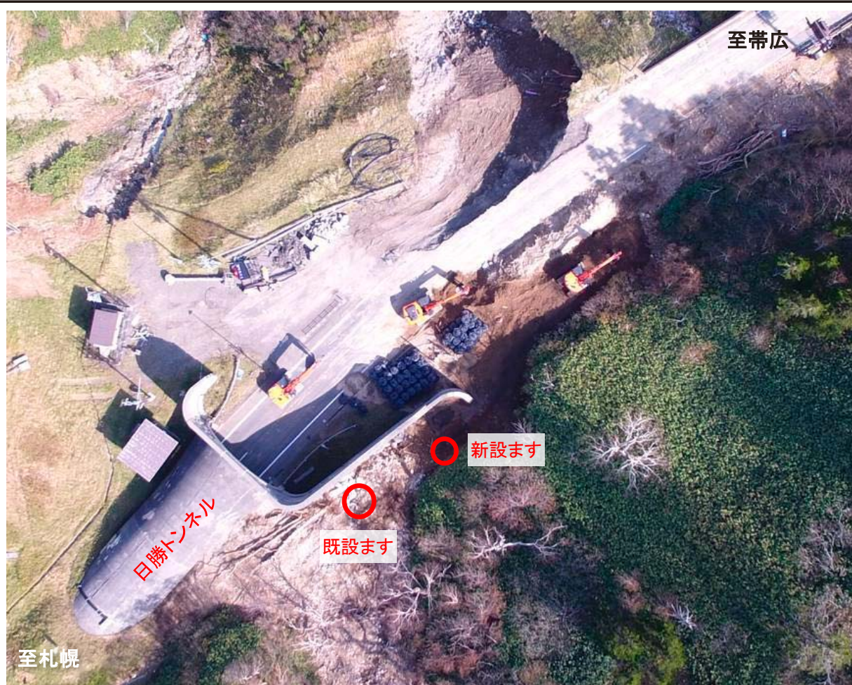
図6 被害を受けた既設カルバート流入口の位置 a) に加筆
