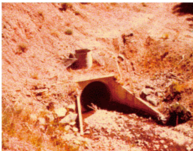
図2-8 カルバート流入口の天端から数フィート内側に設置された Riser、設置当初 2)
