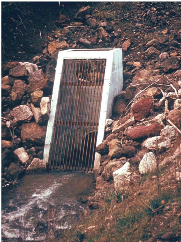
図2-15 Rack と Riser の機能を有する施設 (ワシントン州) 2)
