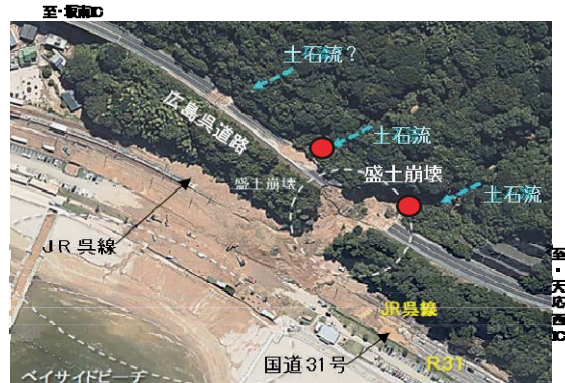
図6 強固な閉塞軽減工(施設)を設置した溪流(図中、赤丸) a)に加筆
