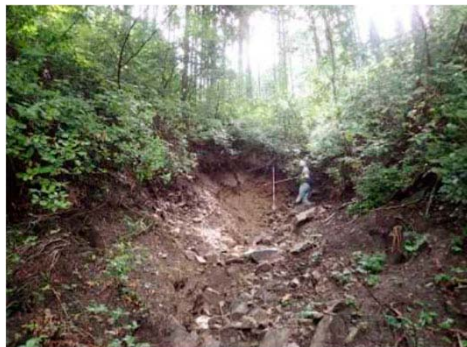
図4 崩壊箇所(土石流源頭部)の状況
