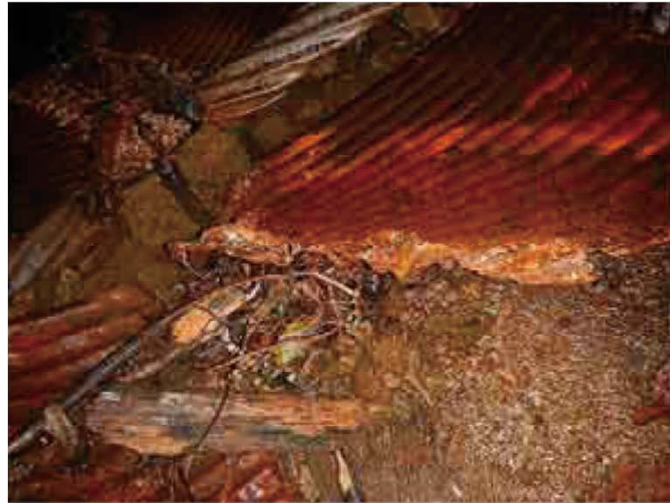
図 11 盛土内に残った既存カルバートの管内状況
