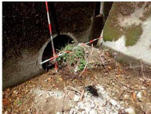
③ カルバート(ヒューム管φ1000mm) 流入口及びます部
