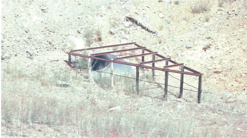
図 2-1 粗石、巨石の多い地域に設置された鉄レールとケーブルによる Deflector 2)
