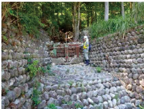
① 谷止鋼製柵 (※土石流発生時は満砂状態)
