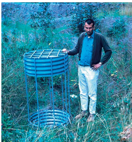
図2-7 盛土脇空間（位置不明）のカルバート流入口直上に設置された Riser（上端に渦防止装置） 2)
