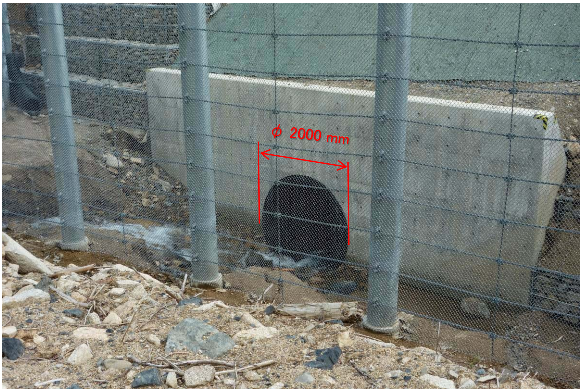
図7 カルバート流入口の状況
