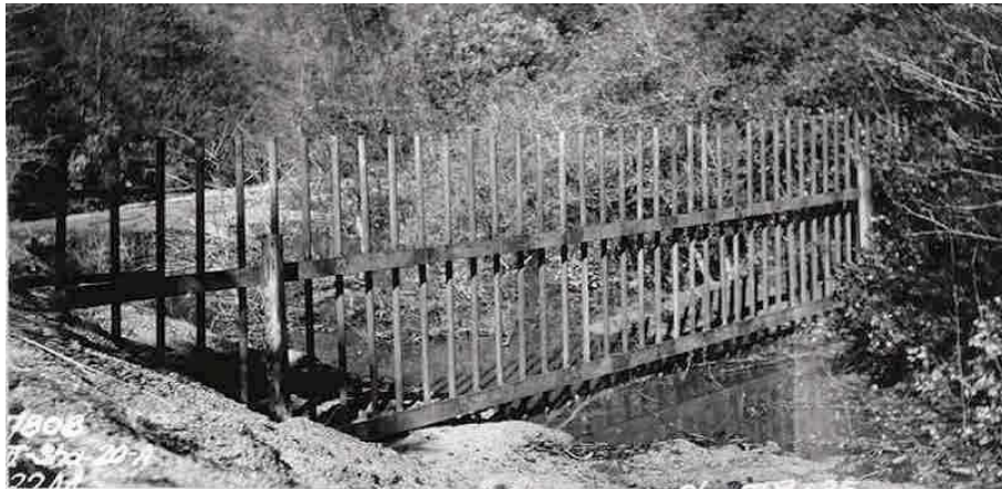
図2-4 カルバートの30 m 上流に35年間設置されている鉄製の柱とレールによる Rack 2)
