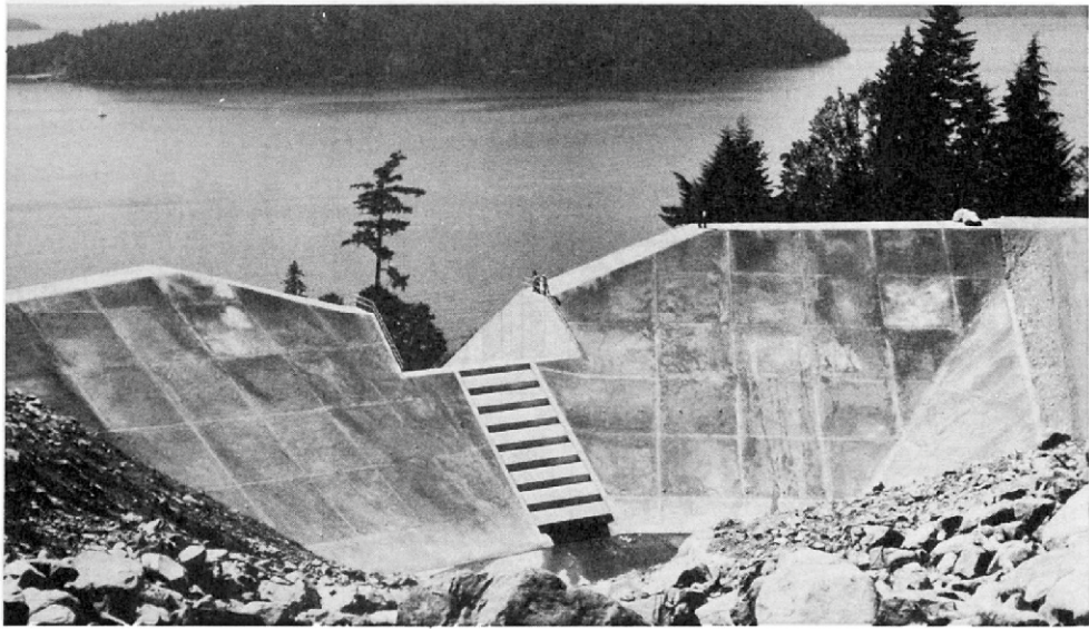
図 2-18 国道 99 号と交差する溪流に設置された盛土形式の土砂捕捉施設の外觀 (チャールズクリーク) 15)
