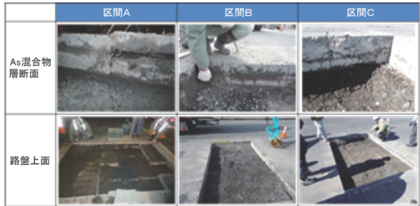
図-6 国道の早期劣化区間の開削調査
