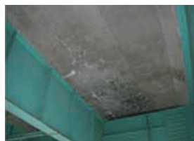
(a) 5年前の定期点検時
