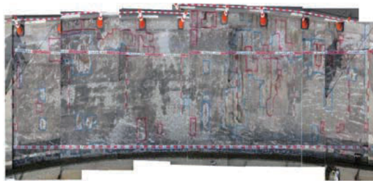
写真4 舗装開削後オルソ画像
