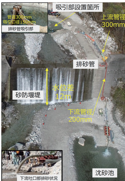
図－8 排砂管の配置
