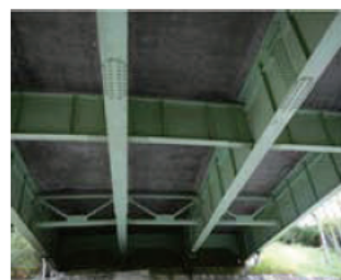
床版下面写真
